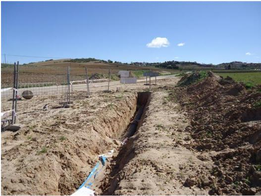
Aspecto de la zanja con la tubería instalada
