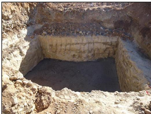
Vista de la excavación del cajeadado en el que afloran limos arenosos
