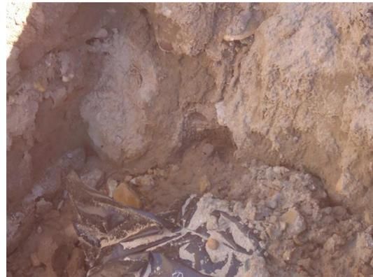
Detalle de los materiales aflorantes en el fondo de excavación de la zanja
