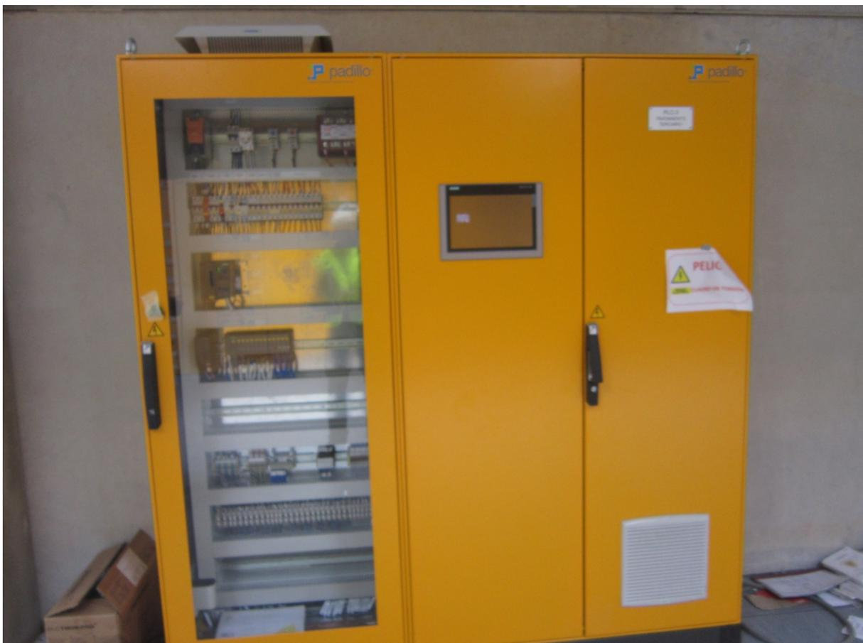
En el caso del PLC de la sala del terciario de la EDAR, será preciso complementar las tarjetas existentes con nuevas tarjetas de señales de entradas y salidas tanto analógicas como digitales, que se ubicarán en los raíles DIN reservados al efecto, para incorporar las señales del nuevo bombeo.
