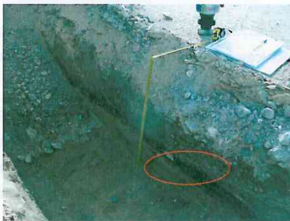
Fotografía 4: Nivel de rellenos detectado en la calicata C-3.
