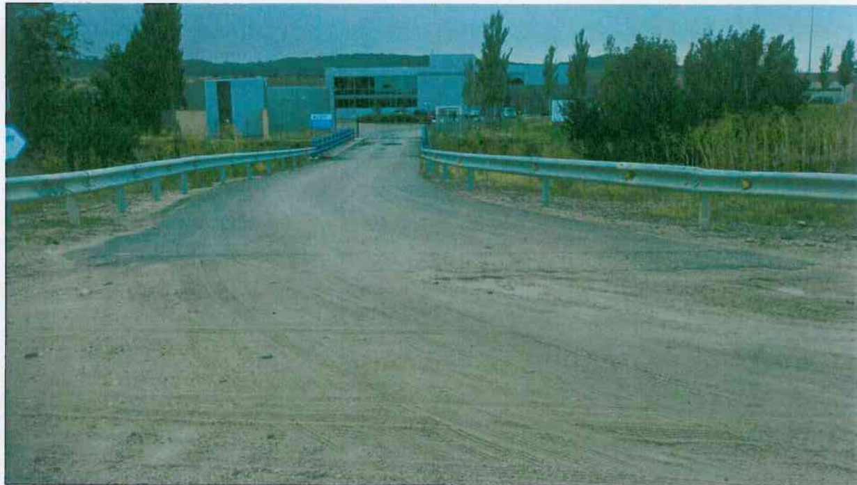
Entrada a EDAR Arroyo Culebro
