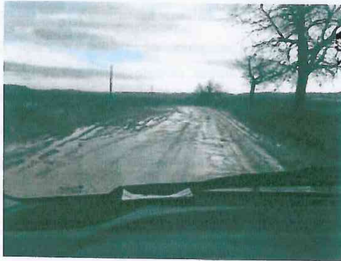
Fotografía 9: Vista general del trazado con poca lluvia.
