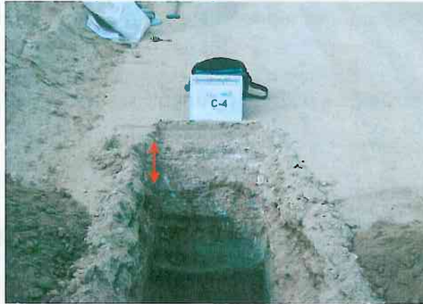
Fotografía 3: Nivel de zahorra detectado en la calicata C-4.
