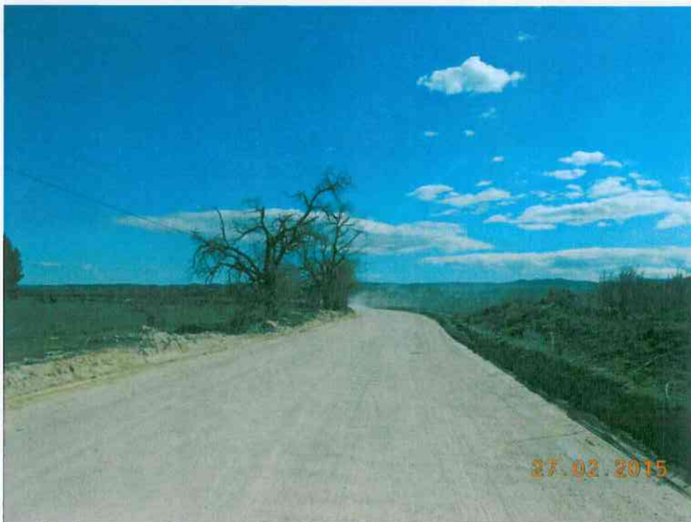
P.K. 1+590 en la margen izquierda
