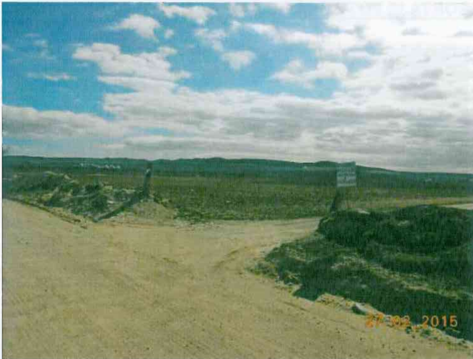
P.K. 0+180 en la margen derecha
