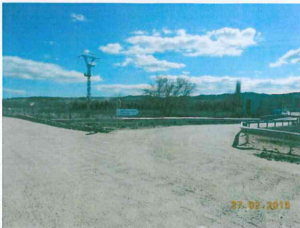
P.K. 1+990. Acceso a EDAR Arroyo Culebro Cuenca Baja.
