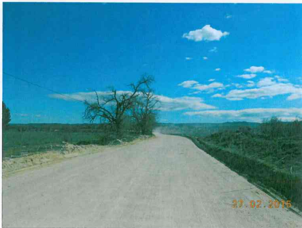
P.K. 1+590 en la margen izquierda
