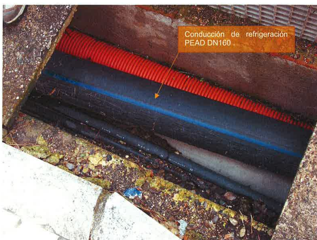
Sección de la canaleta con la conducción de refrigeración a sustituir.
