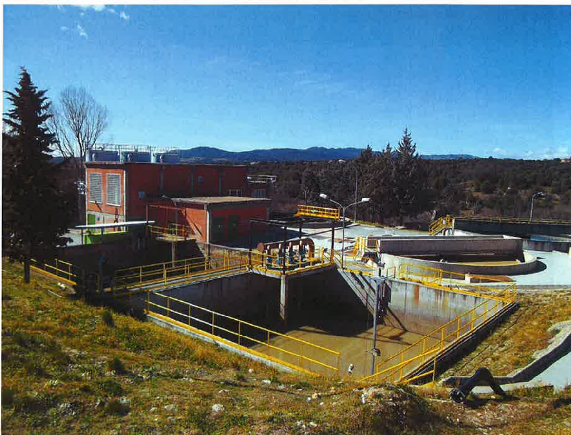
Vista de la zona de tratamiento de fangos, con el edificio situado al fondo.
