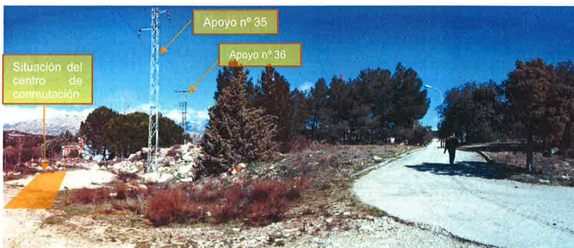
Situación del nuevo Centro de Conmutación
