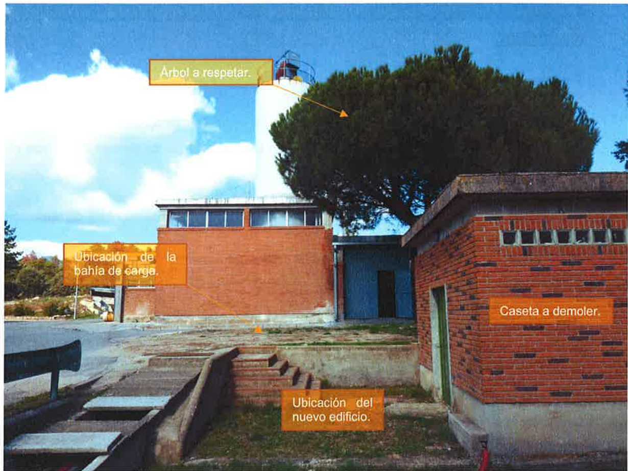
Emplazamiento escogido para el edificio de almacenamiento del reactivo.
