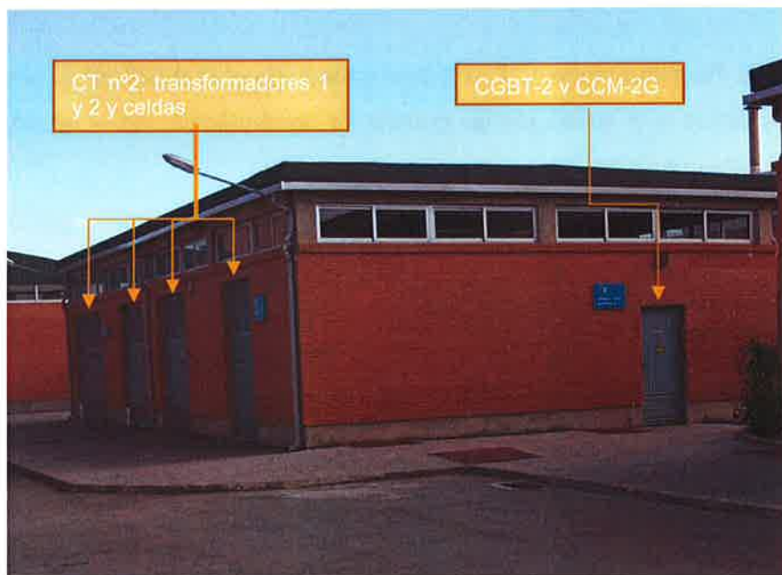
Edificio de C.T. nº 2 (reactivos)
