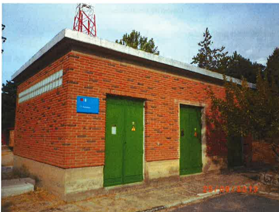
Edificio del Centro de Transformación nº 1.
