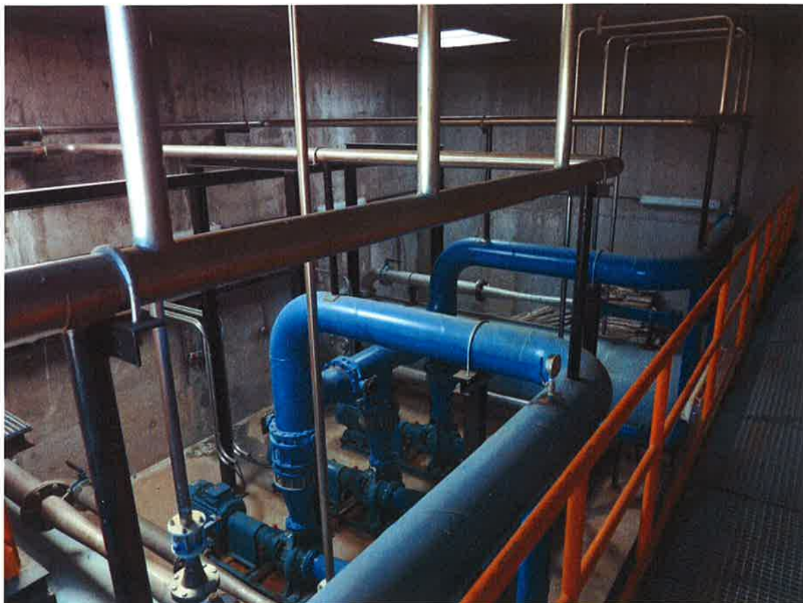
Vista del interior de la primera subcámara, de ejecución seca.
