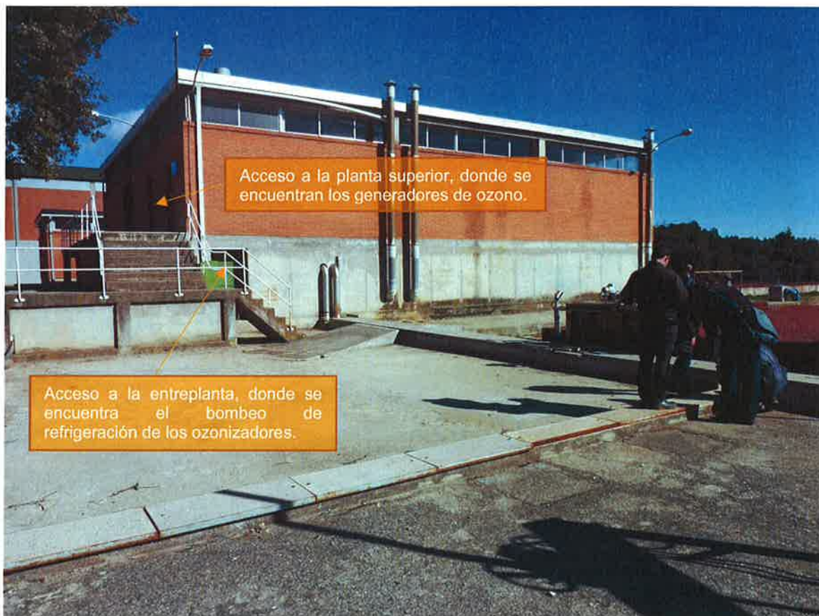
Panorámica exterior del edificio de la ozonización intermedia.
