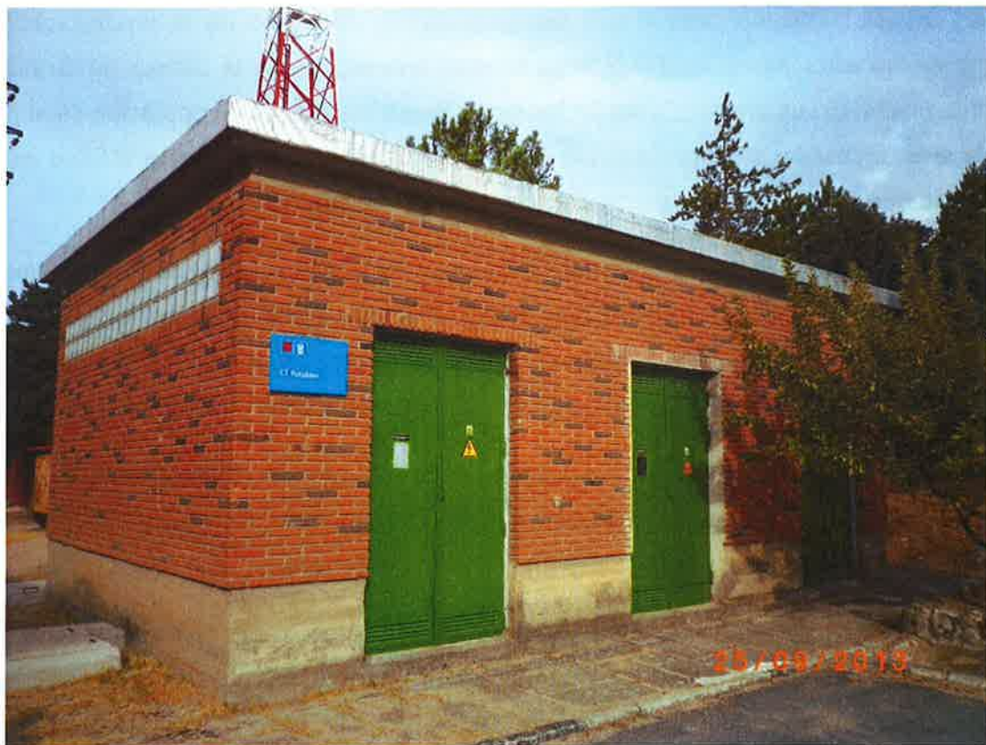
Centro de Transformación Nº1 – Potables, frente al edificio de control.
