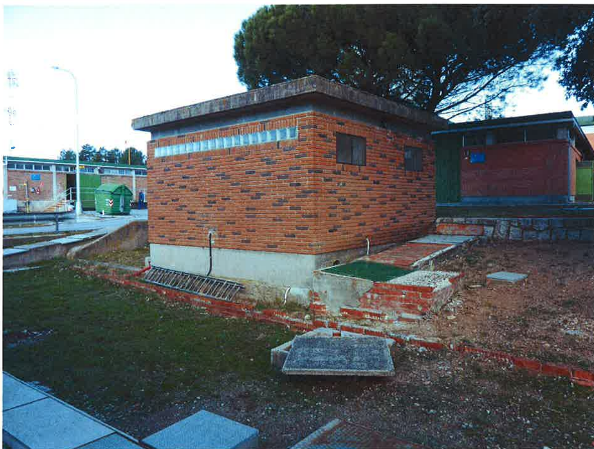
Caseta que alberga el bombeo a la Residencia.
