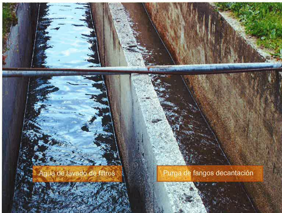
Detalle de ambos canales en este mismo tramo.
