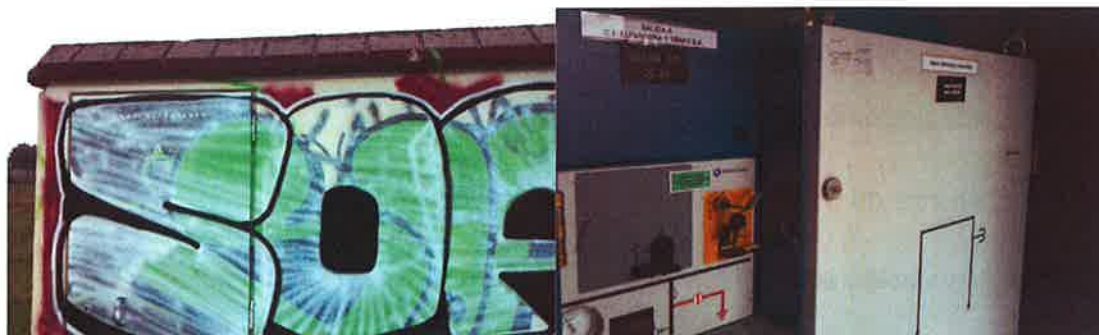
Centro de seccionamiento actual.
