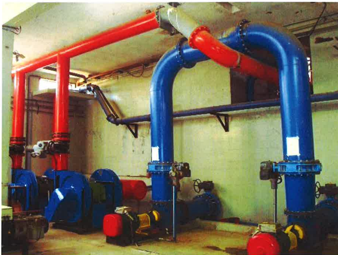
Instalación de bombas y soplantes de lavado de filtros.
