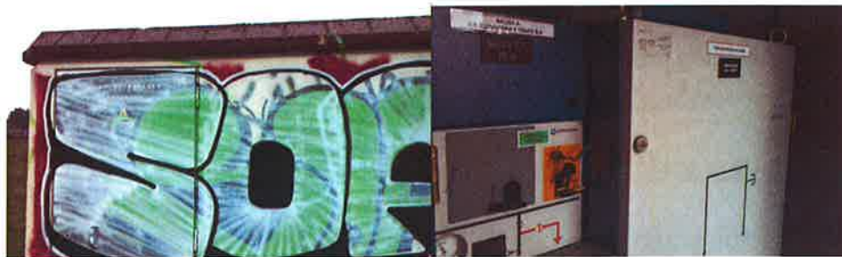
Centro de seccionamiento actual.
