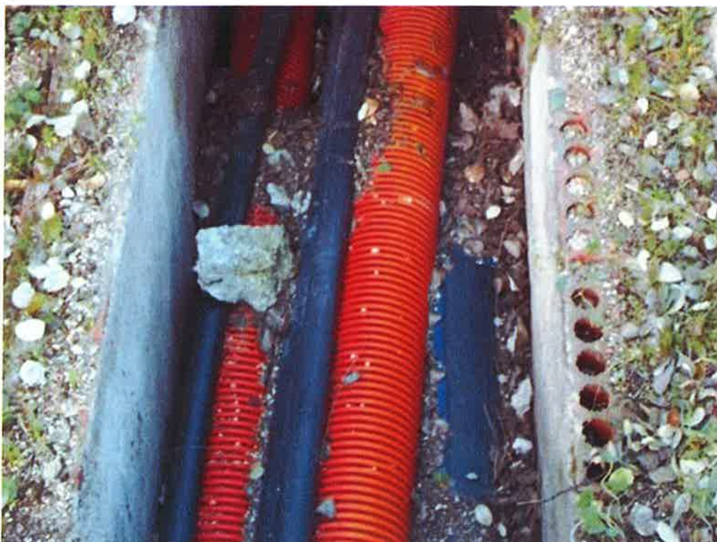
Detalle de la canaleta de reactivos y de agua de refrigeración a ozonizadores.
