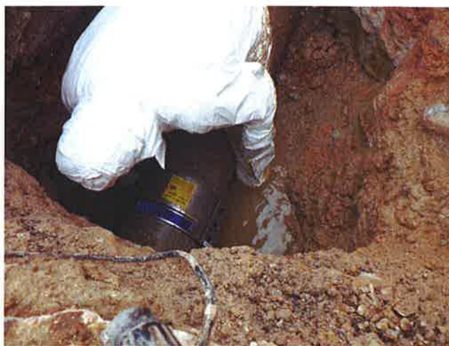
Colocación de abrazadera
