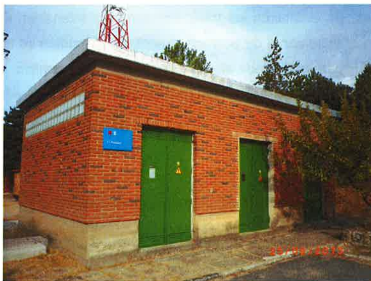
Edificio del Centro de Transformación nº 1.
