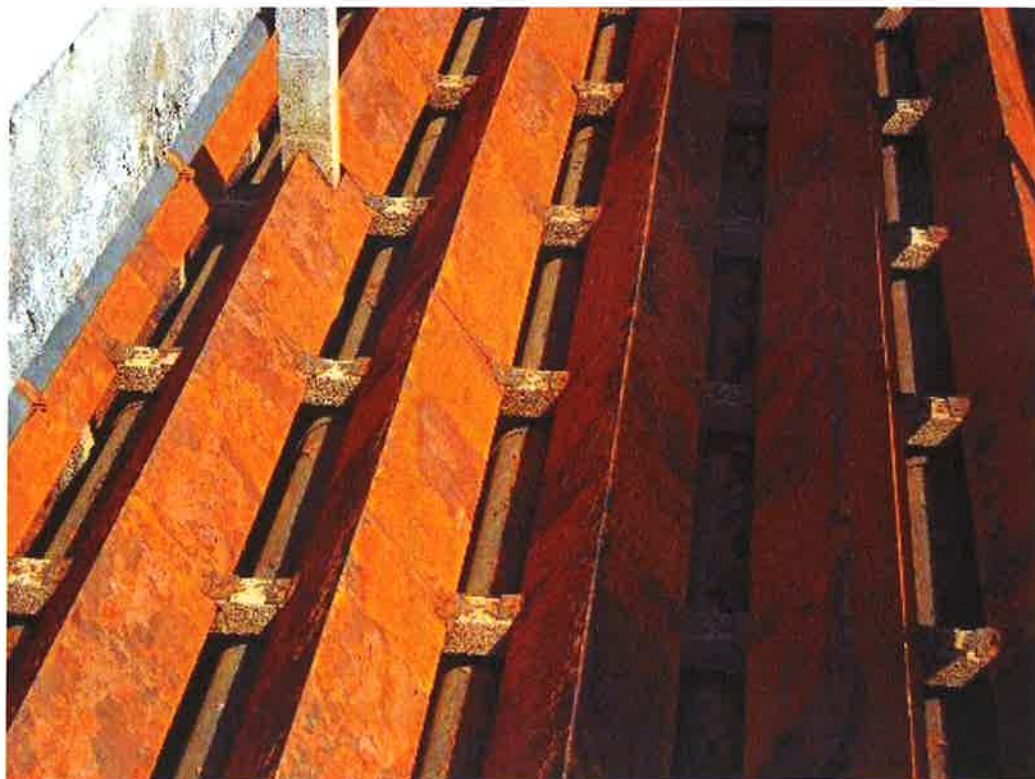
Detalle de las placas tranquilizadoras, y de las tuberías perforadas bajo ellas.
