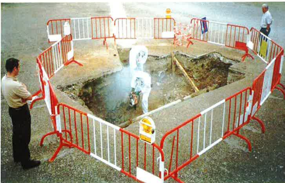
Ejemplo de zona de trabajo mal acotada con riesgo de exposición de otras personas
