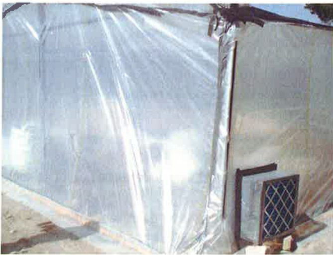
Cubierta de protección para evitar exposiciones inadvertidas
