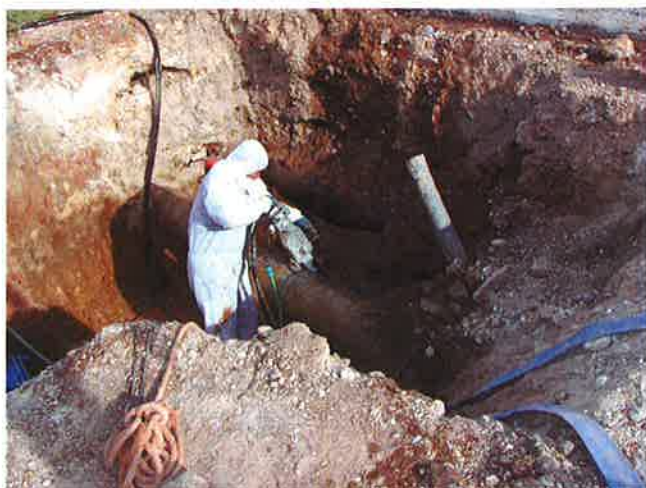
Corte con sierra mecánica
