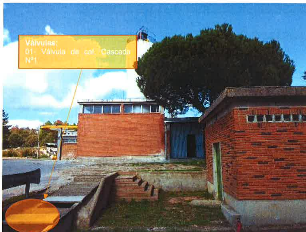
Situación de las válvulas de dosificación N01 a N02.
