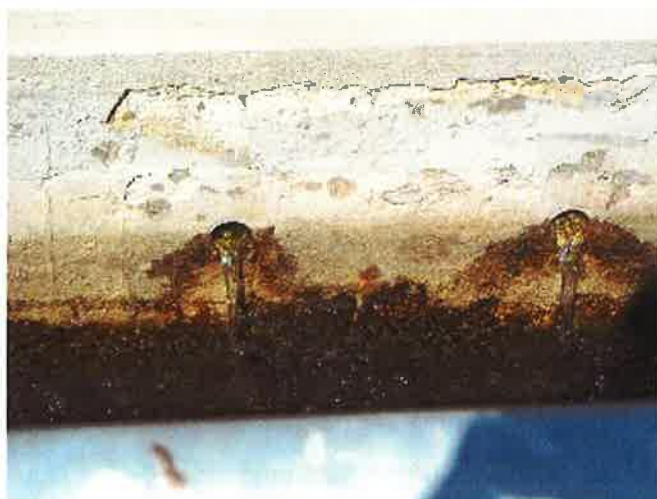
Detalle las perforaciones en las canaletas superiores de recogida de agua.
