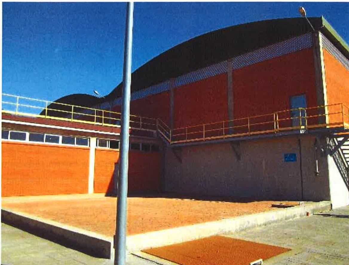
Vista frontal del edificio de filtros de carbón activo.
