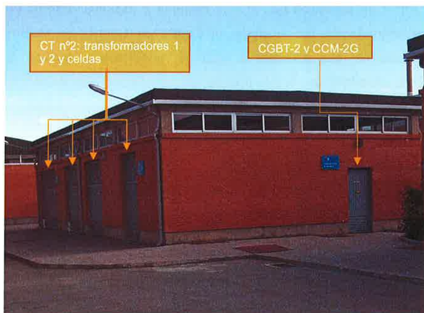
Edificio de C.T. n° 2 (reactivos)
