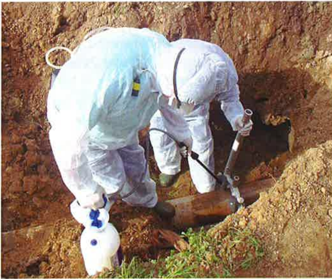
Corte con herramienta manual y aporte de agua
