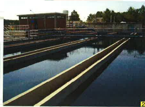
CANAL DE AGUA DECANTADA
