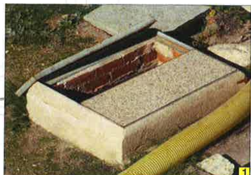
ARQUETA EXISTENTE DE CONEXIÓN
