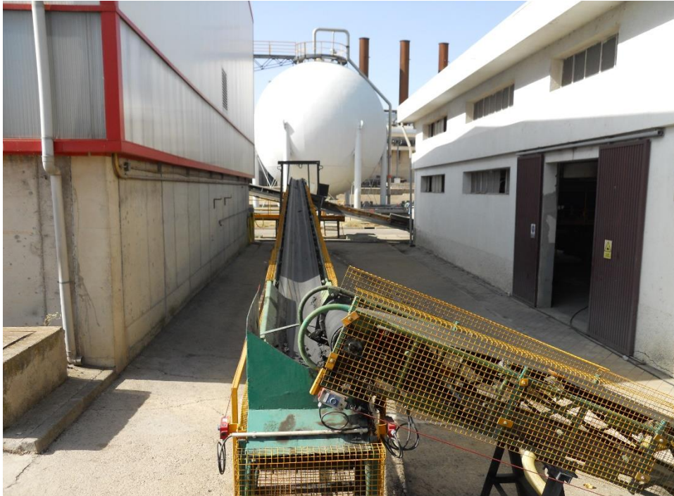
Exterior edificio secado fangos
