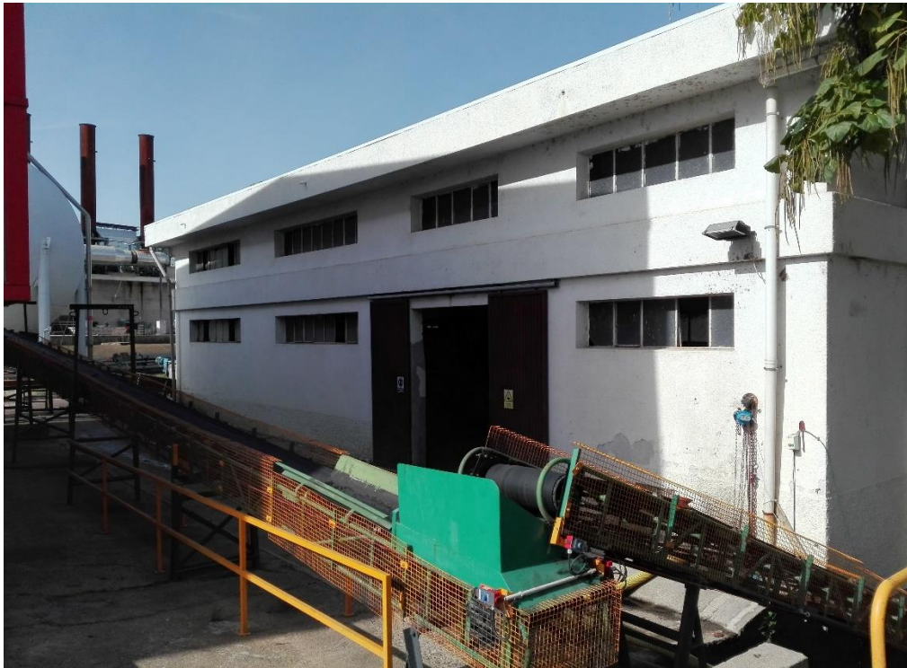
Edificio secado de fangos
