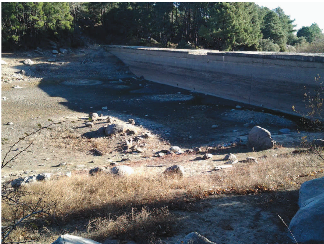
Figura 3: Vista general de la presa y del paramento de aguas arriba.
