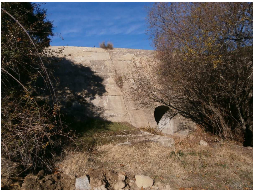
Foto 8. Aspecto del paramento de aguas abajo, en la margen derecha, con el acceso a la galería.
