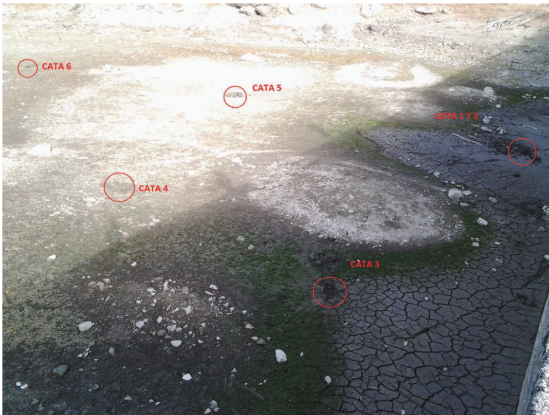
Figura 5: Localización de las catas en el vaso del Embalse de La Alberca.
