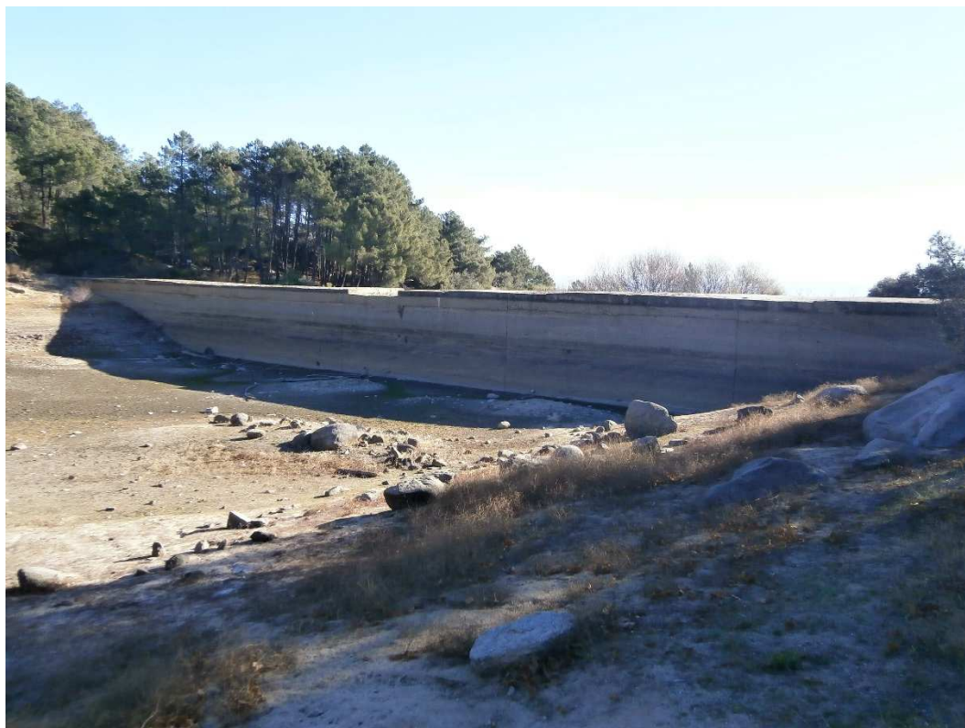
Foto 1. Vista general de la presa y del paramento de aguas arriba.
