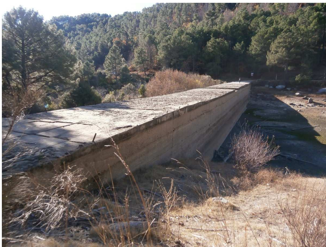
Foto 4. Vista de la presa desde la margen izquierda.
