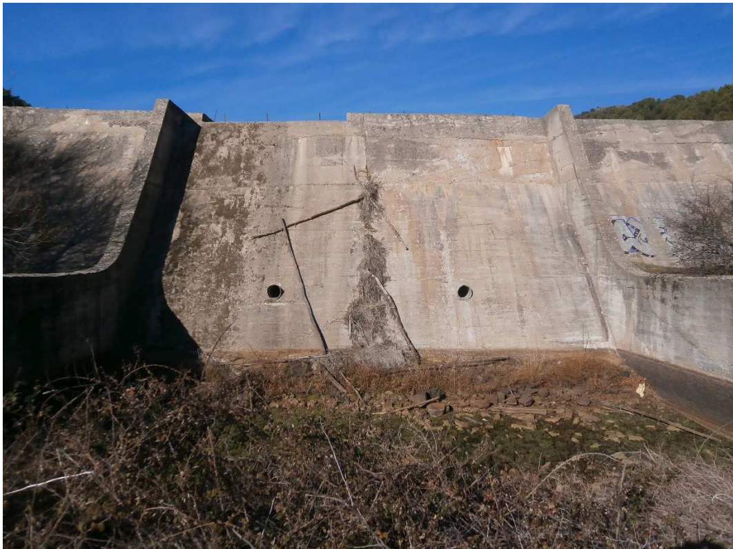
Foto 10. Imagen del paramento de aguas abajo en su parte central, coincidente con el cuenco de amortiguación y canal de descarga del aliviadero y también la disposición de los conductos del desagüe de fondo.
