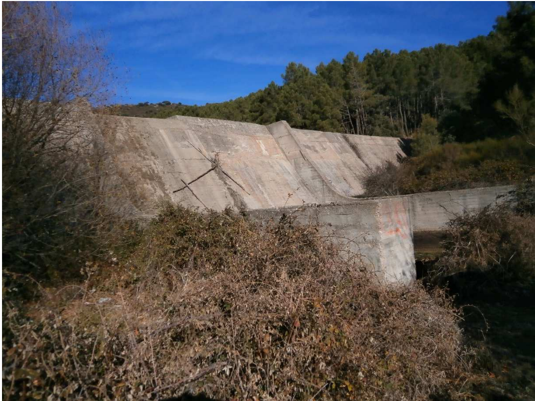
Foto 9. Vista del paramento de aguas abajo y de los hastiales del canal de vertido.
