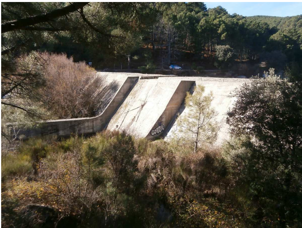
Foto 11. Vista general del cuerpo de presa desde aguas abajo.
