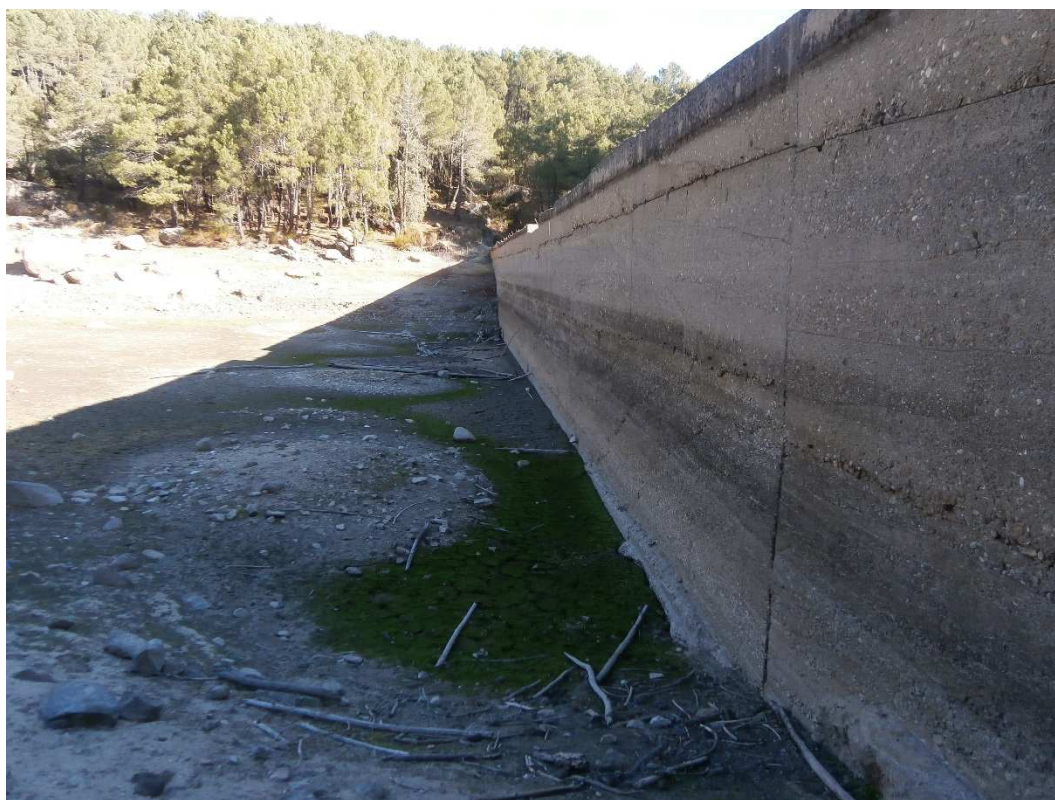
Foto 2. Vista del vaso del embalse y del paramento de aguas arriba desde la margen derecha.
