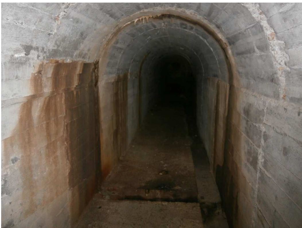
Foto 12. Vista del interior de la galería.
