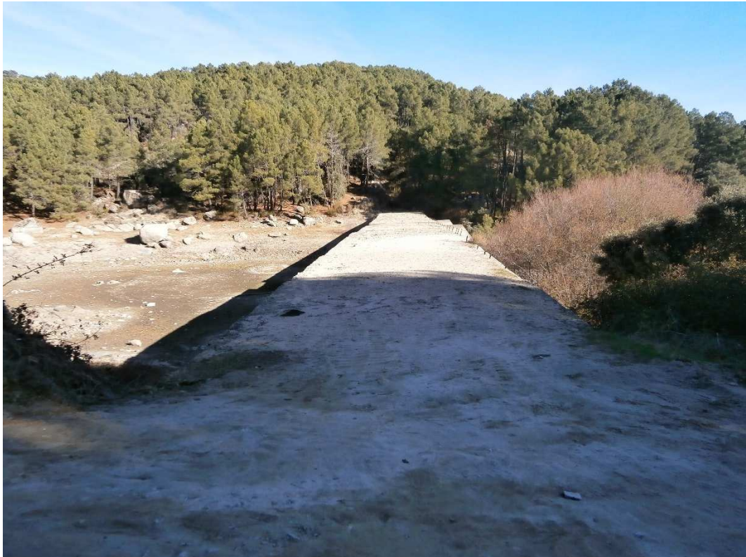
Foto 7. Vista general de la coronación de la presa desde el estribo derecho.
