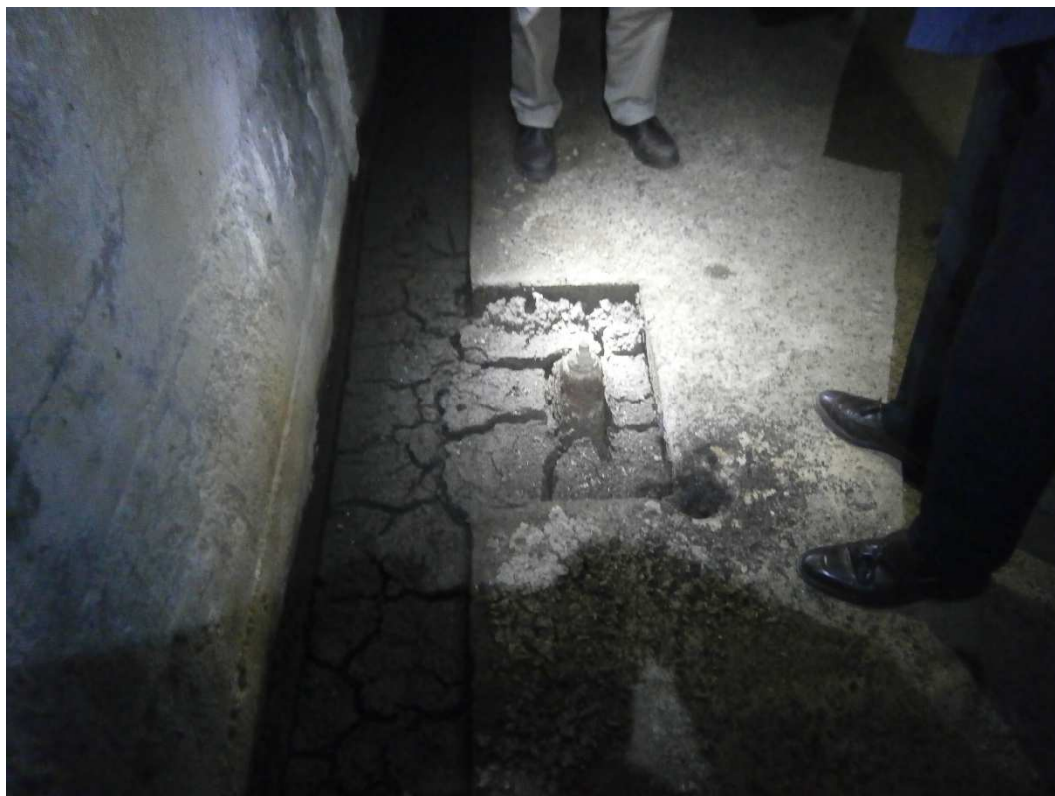
Foto 13. Aspecto de una de las válvulas en el interior de la galería.
