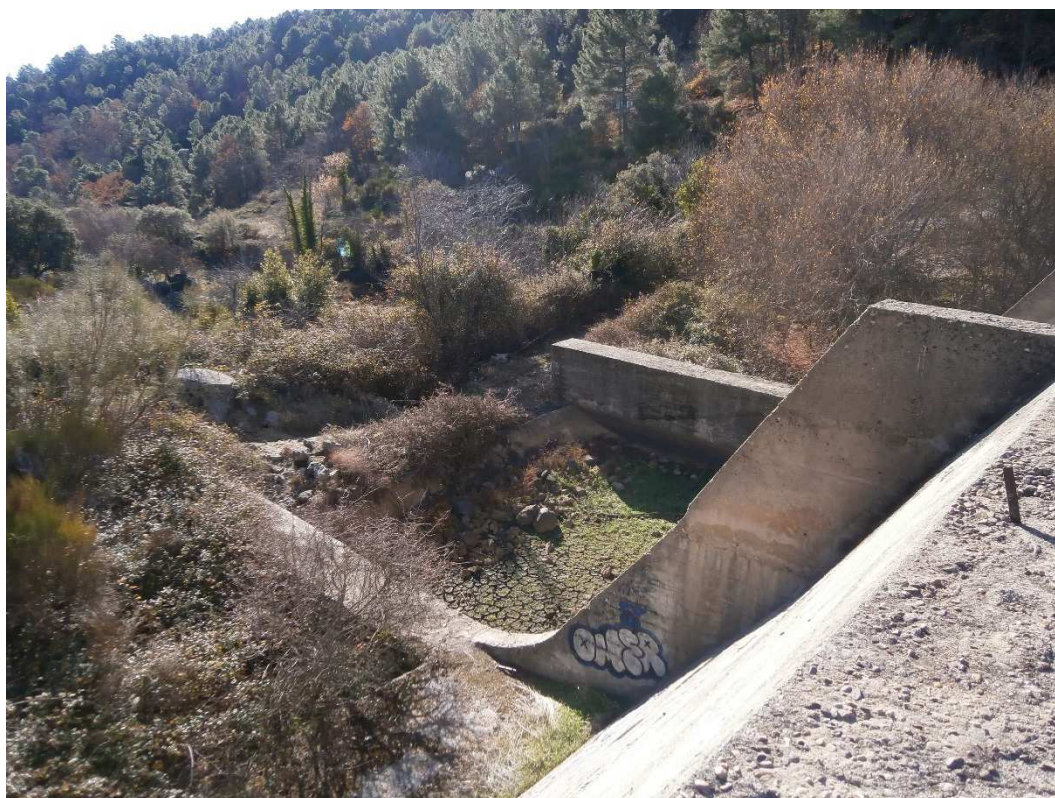
Foto 6. Aspecto general del cuenco de amortiguación y del hastial del aliviadero.
