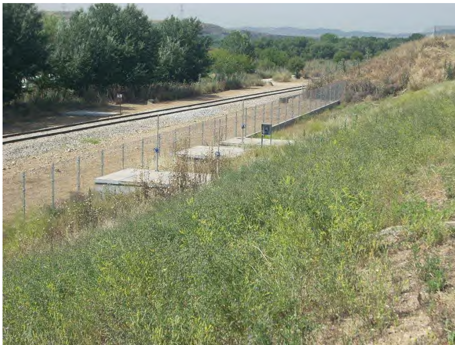
Arquetas de entrada a la depuradora en las que se conectará el saneamiento de la planta nodriza
