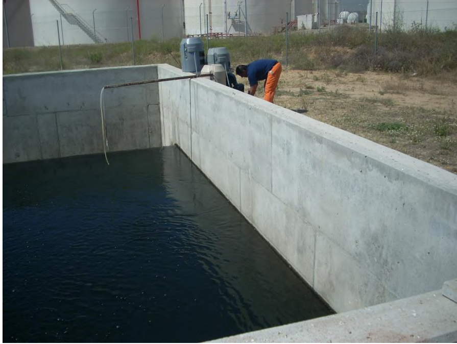
Depósito de agua tratada, con vista de la zona en la que se ubicará el grupo de bombeo
