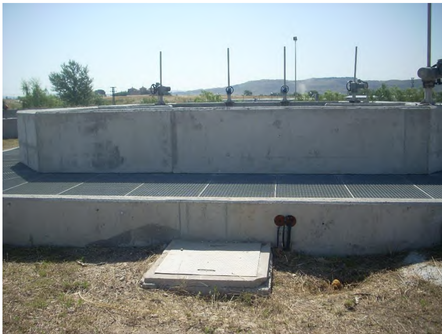
Arqueta de reparto a decantación primaria
