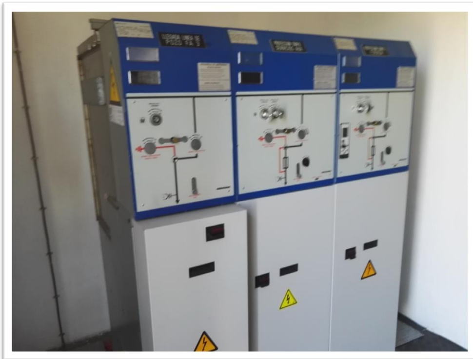
Detalle de interior del edificio
