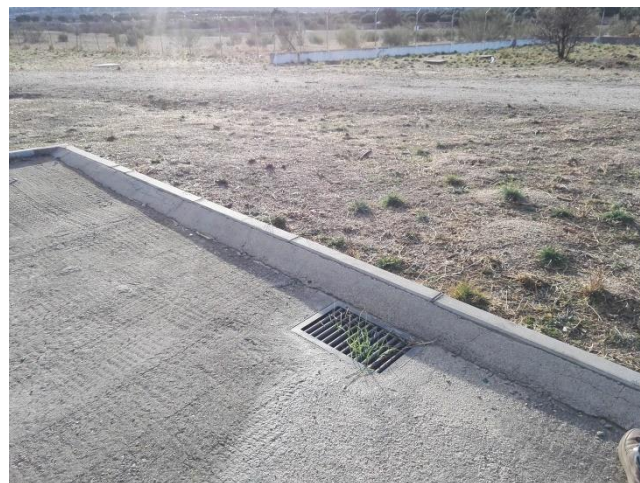
Imbornal recogida de aguas pluviales en la plataforma existente.
