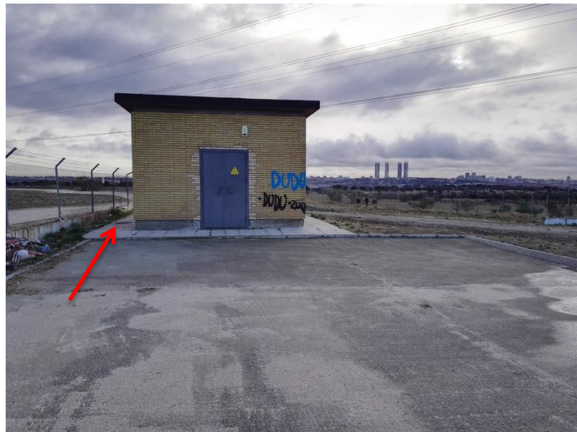
Ubicación de arqueta acometida eléctrica.
