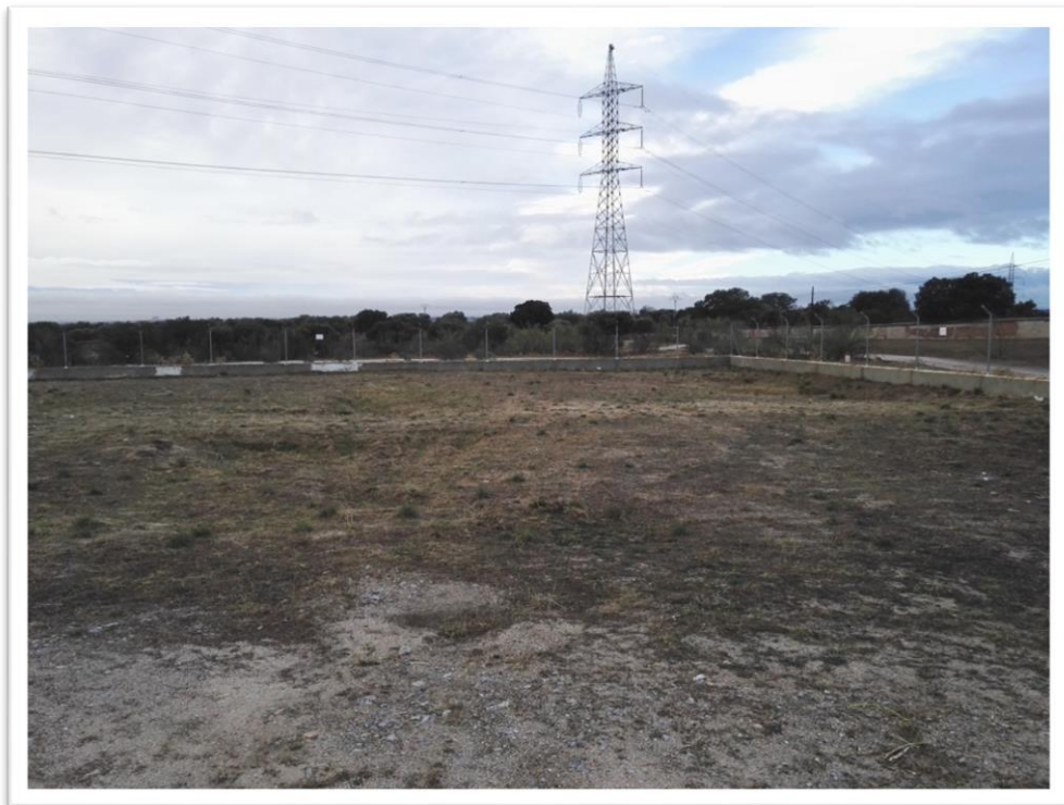
Explanada interior de la instalación. Línea aérea alta tensión que cruza por la instalación.
