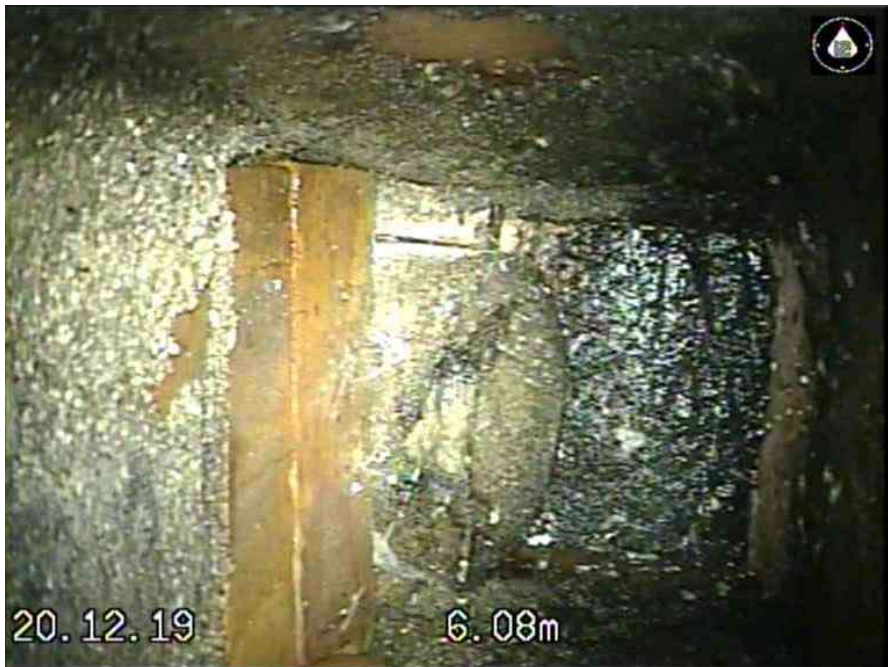
2_37f1b4e9-a81b-4958-810b-2dcc5343f266_20191220_123959_772.jpg, 00:00:32, 6.08 ACOMETIDA EN TECHO SOBRESALIENTE a 12
