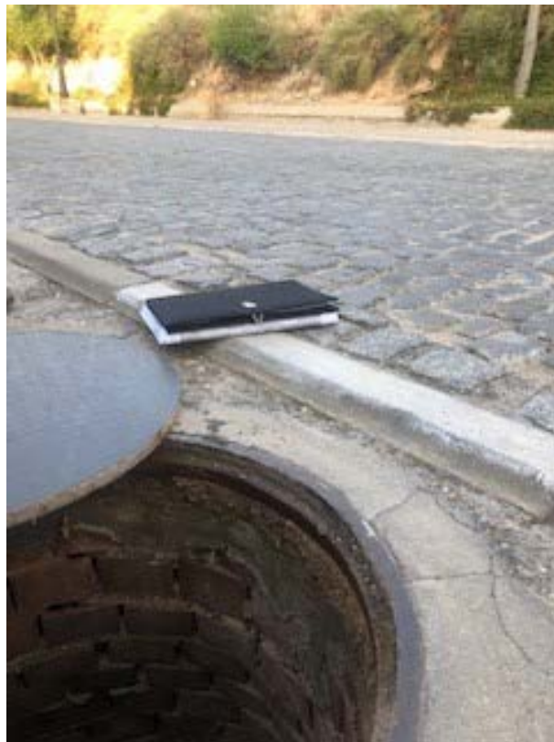
Fotografía nº 27.- Pozo aguas arriba del de conexión en la C/ Aranjuez
