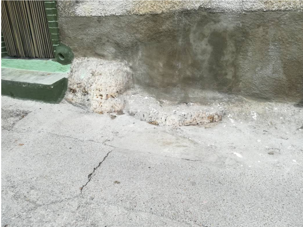
Caliza del páramo en la cimentación de la vivienda (2)
