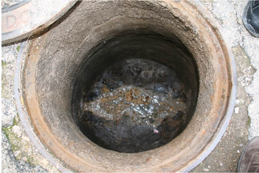
Fotografía nº 14.- Interior pozo PE-2.2
