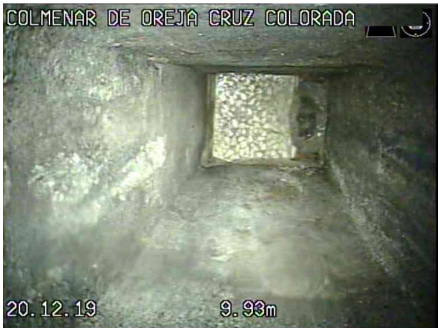
3_b7f776e4-47cb-4398-be7d-7d7925764d3a_20191220_092141_864.jpg, 00:01:33, 9.93 ACOMETIDA EN TECHO SOBRESALIENTE a 12
