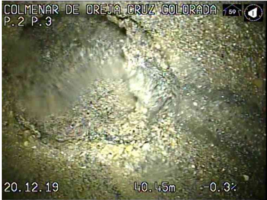
2_070dc9ec-6091-40e1-9336-5f54bef11885_20191220_085758_494.jpg, 00:02:52, 40.45 ACOMETIDA LADO DERECHO SOBRESALIENTE desde 12 a 2
