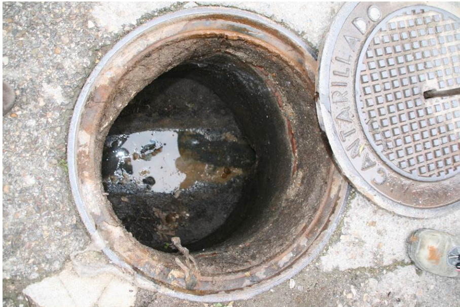
Fotografía nº 15.- Interior pozo PE-3.2
