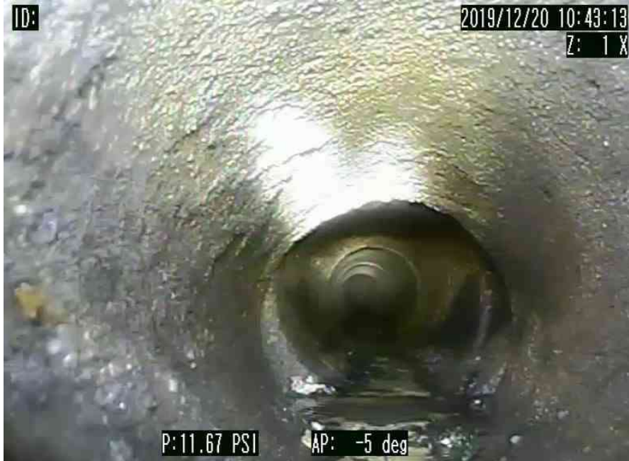
7_ffe5f2d6-0a86-4214-aab9-9c84d05fb212_20200102_175325_441.jpg, 00:00:00, 0.00 INICIO DE LA INSPECCION
