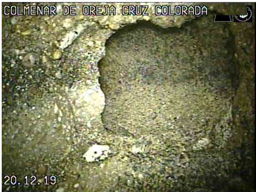
2_576e7dd8-de94-4dc9-aacf-b70fbb1a318_20191220_085425_893.jpg, 00:01:08, 31.65 ACOMETIDA LADO DERECHO SOBRESALIENTE desde 10 a 12
