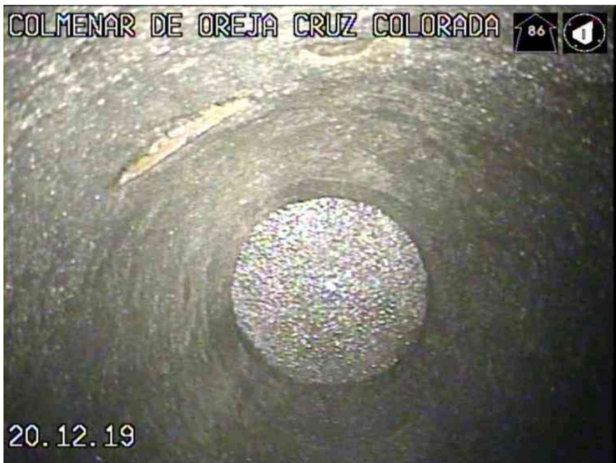
1_677be098-c771-4459-aa4b-d6789931b9aa_20191220_083206_082.jpg, 00:01:40, 10.75 FINAL DE LA INSPECCION
