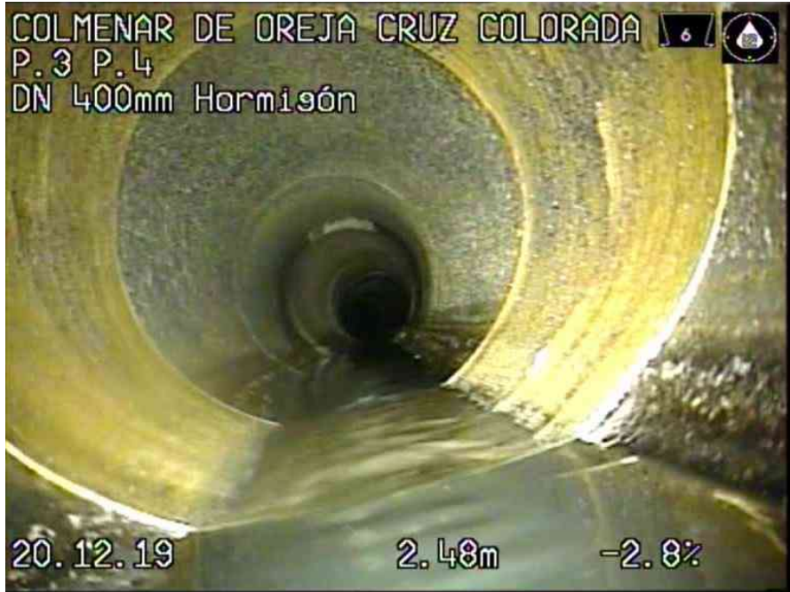
3_036bca0b-1564-4253-99ce-1c123a58f03d_20191220_092013_943.jpg, 00:00:34, 2.48 REPARACION POR MANGA TOTAL
