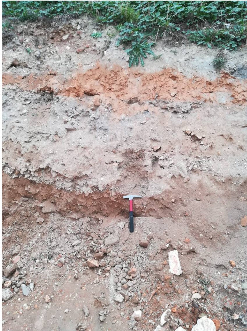
Talud excavado en zona de relleno antrópico
