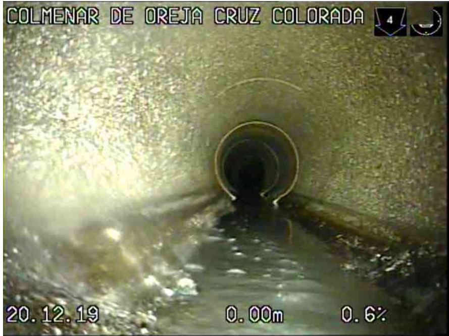
3_6928ea02-0a23-4c2f-ad61-7f717f22b9c9_20191220_091856_026.jpg, 00:00:02, 0.00 INICIO DE LA INSPECCION
