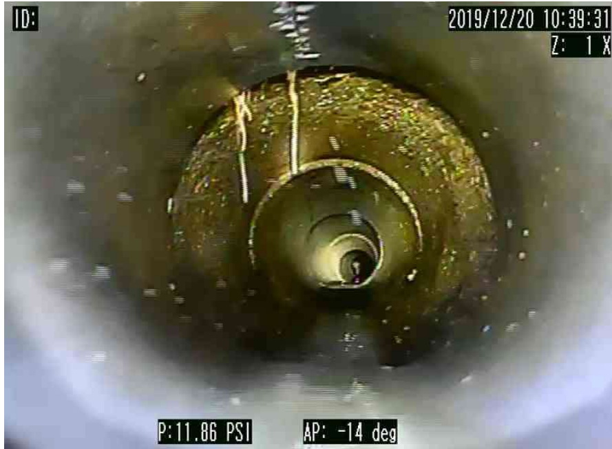
8_f285a027-0d97-4963-9427-8cf2878ce5b7_20200102_175529_483.jpg, 00:00:00, 0.00 INICIO DE LA INSPECCION
