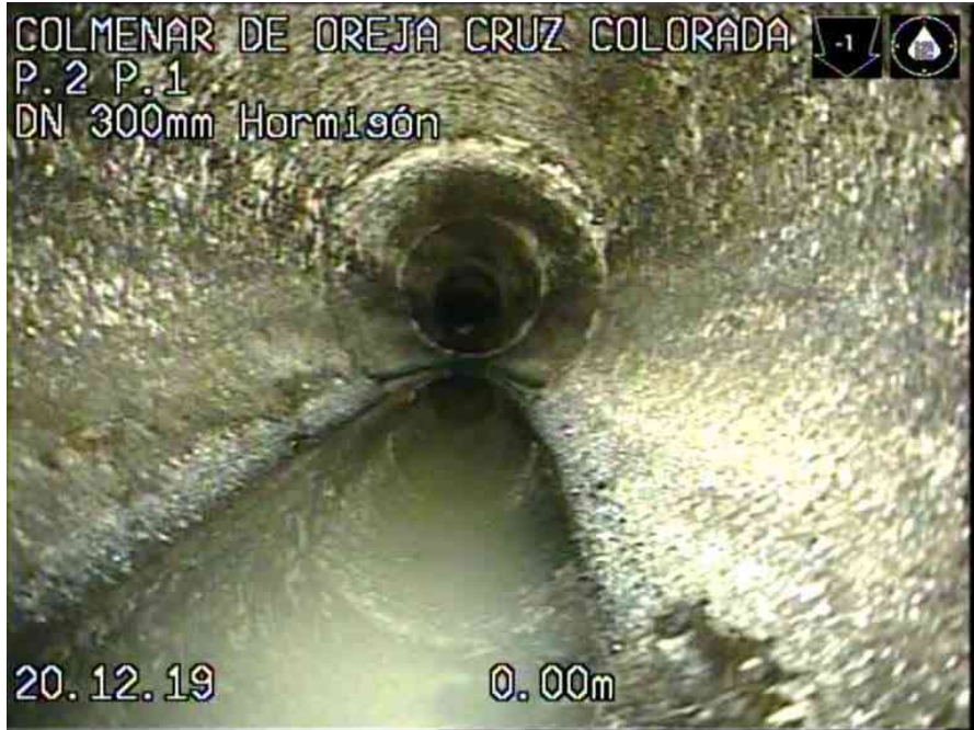
1_364a1775-c44d-44b6-a2d1-5c27491b8384_20191220_082851_140.jpg, 00:00:03, 0.00 INICIO DE LA INSPECCION
