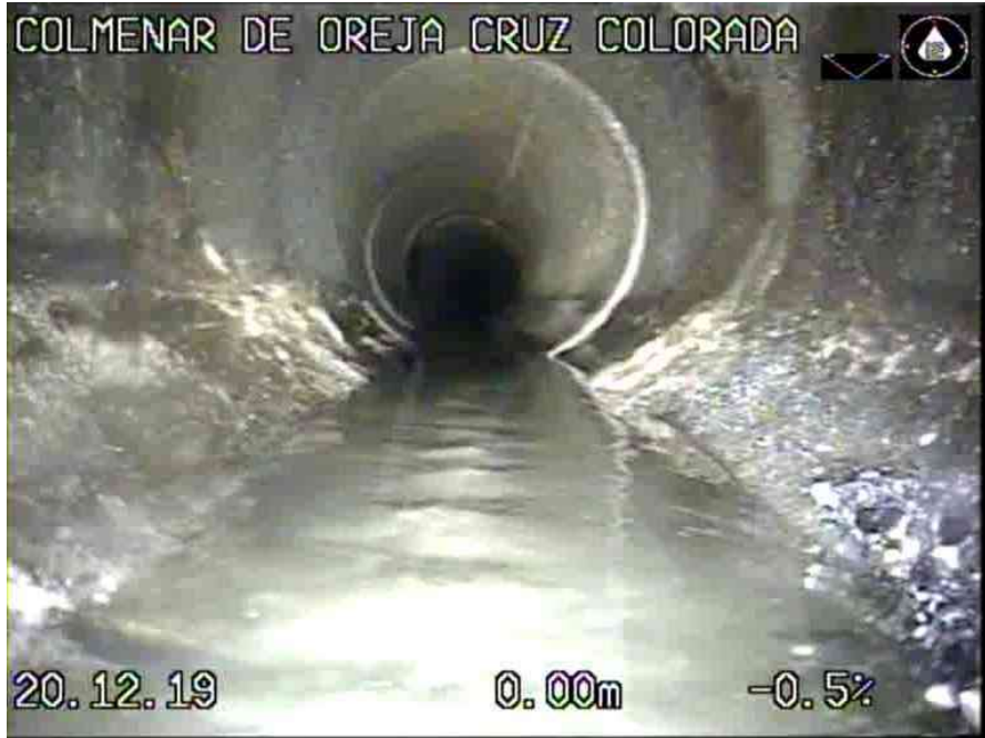
4_acf99fc2-01c3-47e6-b58f-38d0b5e5c26e_20191220_092326_847.jpg, 00:00:02, 0.00 INICIO DE LA INSPECCION
