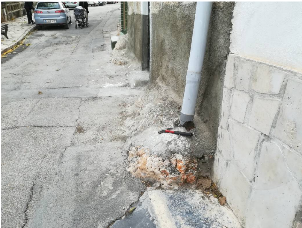
Caliza del páramo en la cimentación de la vivienda (1)
