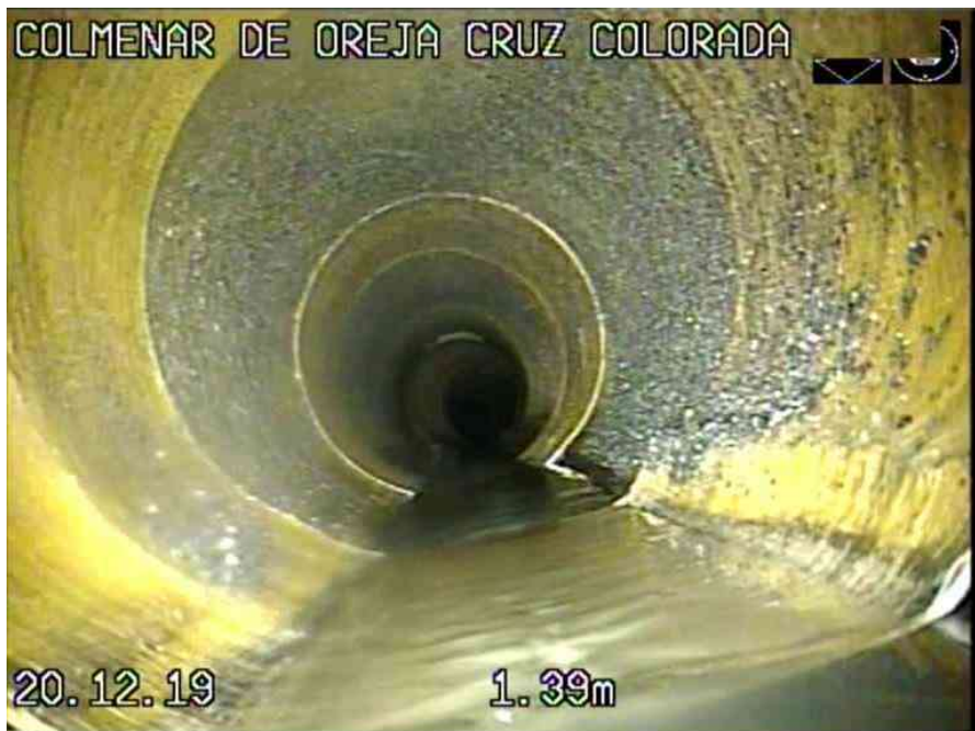
3_3ba028cc-6451-4b6a-a4fe-084dab190ef6_20191220_091947_127.jpg, 00:00:24, 1.39 REPARACION POR MANGA TOTAL
