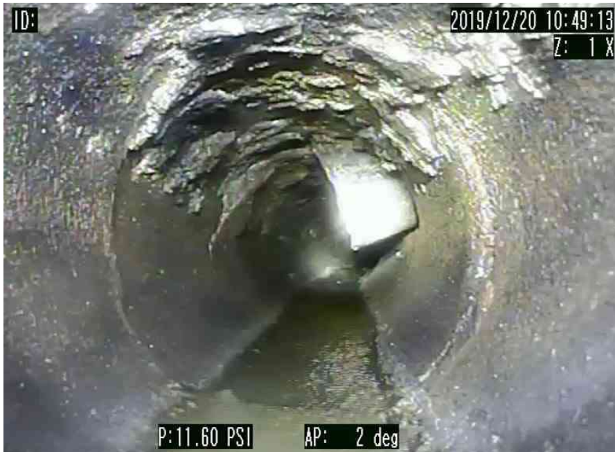
6_ae514b6d-799b-4663-aaba-20da36944b69_20200102_175213_649.jpg, 00:00:00, 21.30 FINAL DE LA INSPECCION
