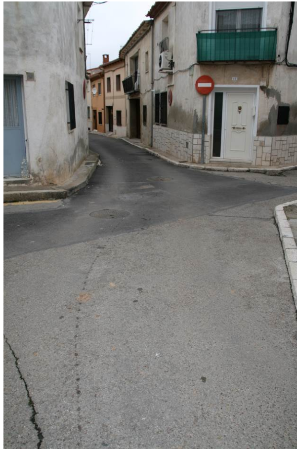
Fotografía nº 7.- Pozo PE-5.1 al final de la C/ Cruz Colorada
