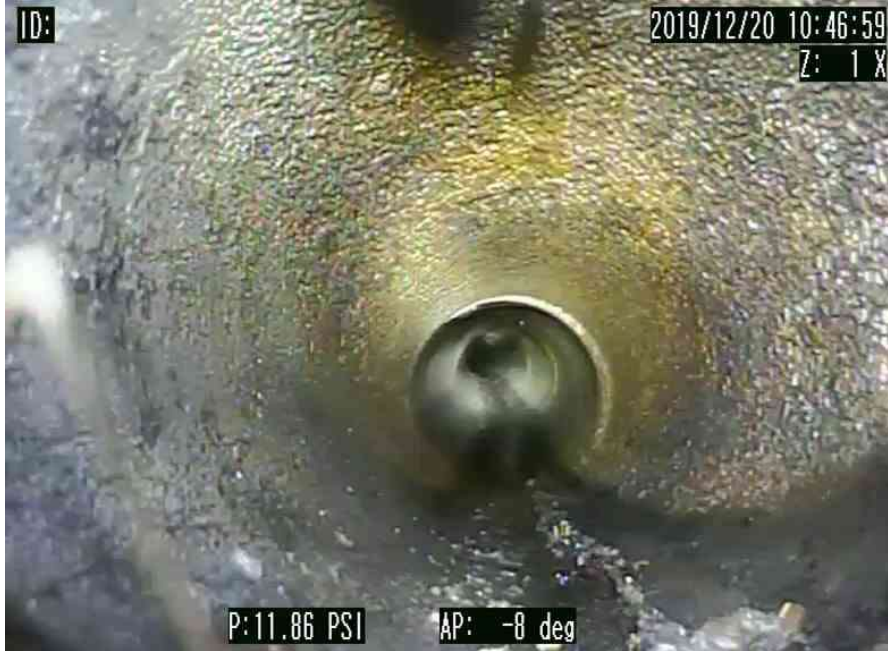
6_a95a4c34-fecc-49ad-b9d1-4cb29023d843_20200102_175159_896.jpg, 00:00:00, 0.00 INICIO DE LA INSPECCION
