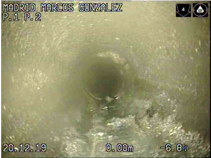
1_6287027f-1671-4ee9-bf39-f714d4de79b5_20191220_112340_719.jpg, 00:00:02, 0.00 INICIO DE LA INSPECCION
