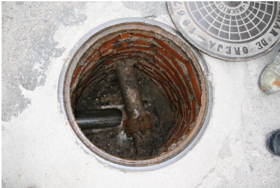
Fotografía nº 17.- Interior pozo PE-4.2
