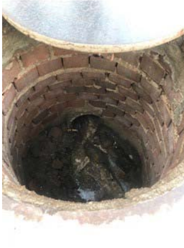
Fotografía nº 28.- Pozo aguas arriba del de conexión en la C/ Aranjuez (Detalle)
