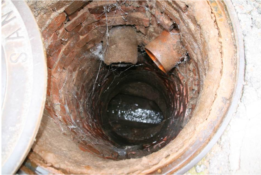
Fotografía nº 6.- Interior pozo PE-4.1
