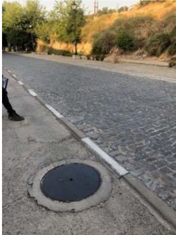
Fotografía nº 26.- Pozo aguas arriba del de conexión en la C/ Aranjuez
