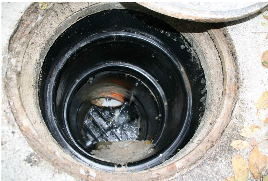
Fotografía nº 19.- Interior pozo PE-1.3
