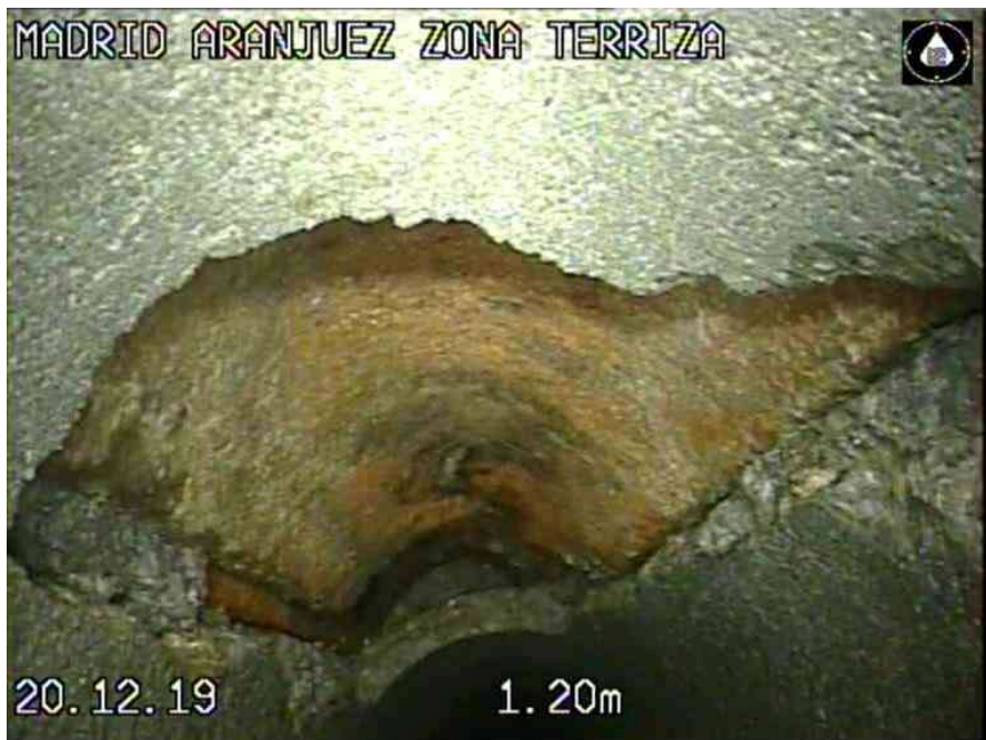
1_2b522919-843e-45f6-afd2-d4cec1b4ab45_20191220_121457_209.jpg, 00:00:10, 1.20 REPARACION MEDIANTE FLEJE DE ACERO OXIDADO
