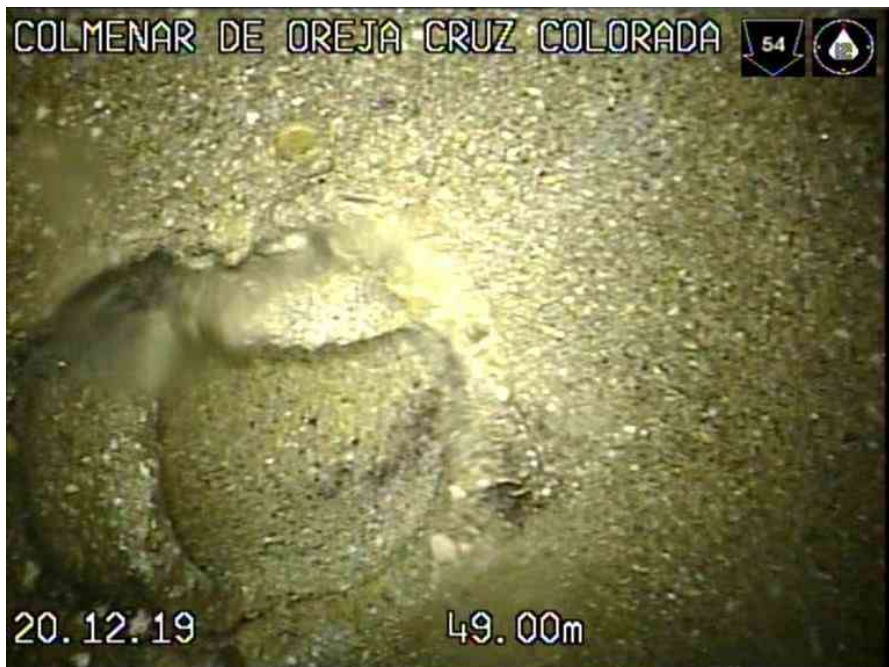
2_3d01bbef-759a-411d-aa4d-fb14cf28f182_20191220_085952_018.jpg, 00:04:10, 49.00 ACOMETIDA LADO IZQUIERDO SOBRESALIENTE desde 10 a 12
