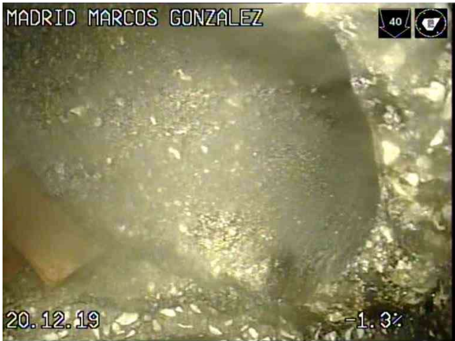
1_ce66b03d-a648-418a-830d-a3e718ffc764_20191220_112956_553.jpg, 00:04:33, 38.46 ACOMETIDA LADO DERECHO SOBRESALIENTE desde 12 a 2
