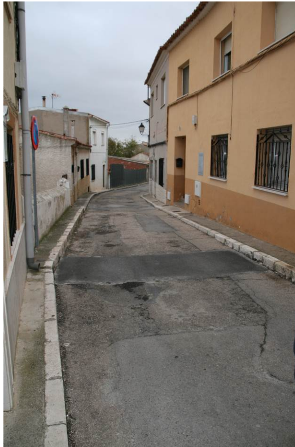
Fotografía nº 13.- Tramo de la C/ Marcos González aguas abajo de la cámara de carga
