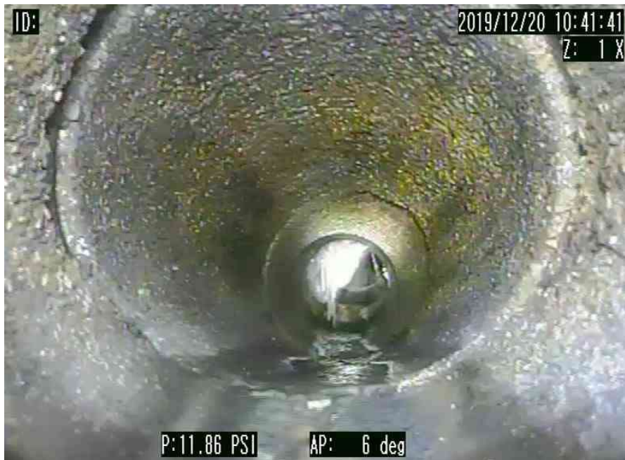
8_80c0a890-3494-4d93-9da7-fe04cb872187_20200102_175553_540.jpg, 00:00:00, 13.30 FINAL DE LA INSPECCION
