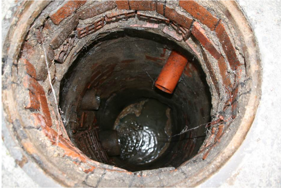
Fotografía nº 8.- Interior pozo PE-5.1
