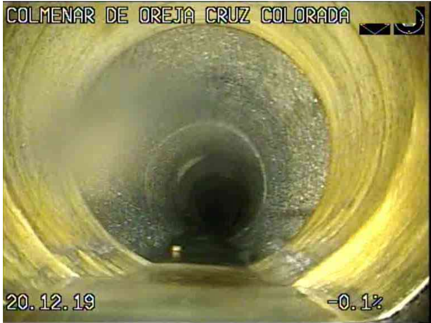
2_2c702f3b-a453-42cd-8879-0f95b91742bc_20191220_085624_057.jpg, 00:02:06, 36.84 REPARACION POR PACKERS CONTINUOS
