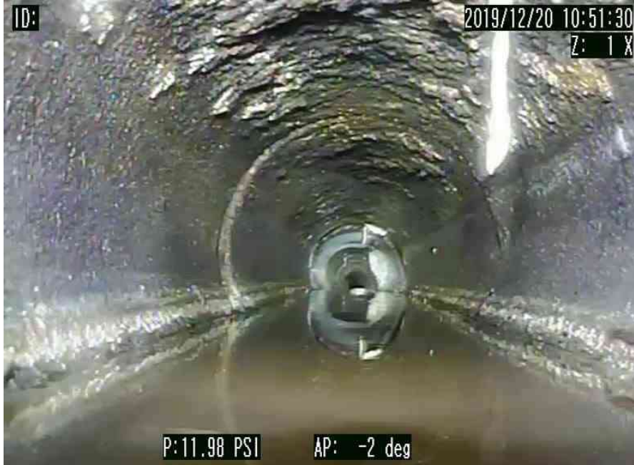
4_478d9eea-d7e3-46cf-8231-c2e67e88986d_20200102_174701_397.jpg, 00:00:00, 0.00 INICIO DE LA INSPECCION
