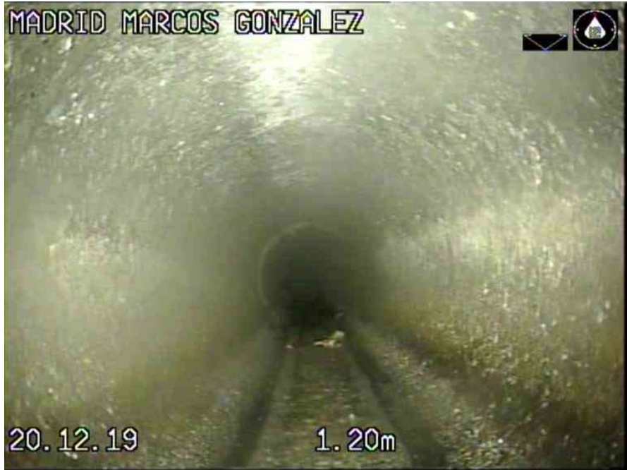
4_674f39eb-d308-4797-848d-4083760d61b9_20191220_114547_297.jpg, 00:00:04, 1.20 INICIO DE LA INSPECCION
