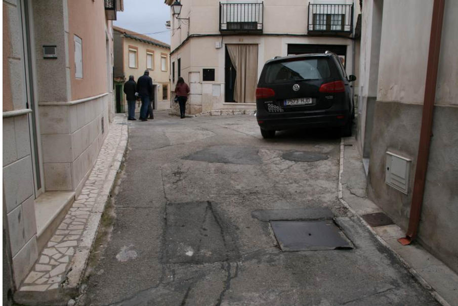
Fotografía nº 10.- Inicio de la zona de reposición de aglomerado en la C/ Marcos González
