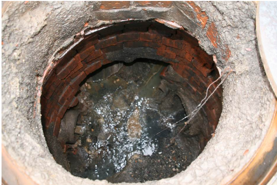
Fotografía nº 3.- Interior pozo PE-2.1
