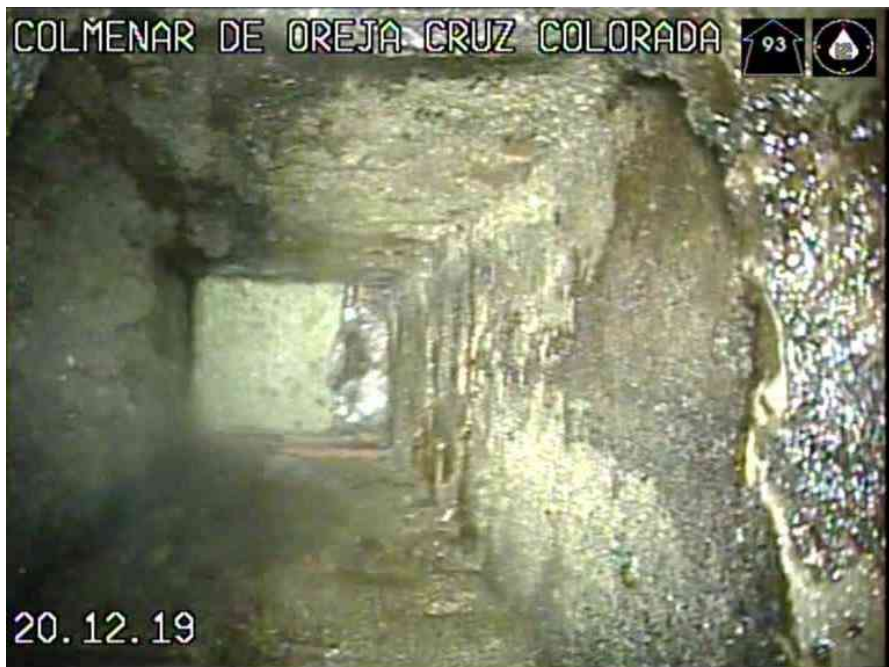
3_bc3b8561-c192-471d-9f6d-811147e4a932_20191220_092039_935.jpg, 00:00:51, 5.15 ACOMETIDA EN TECHO SOBRESALIENTE a 12
