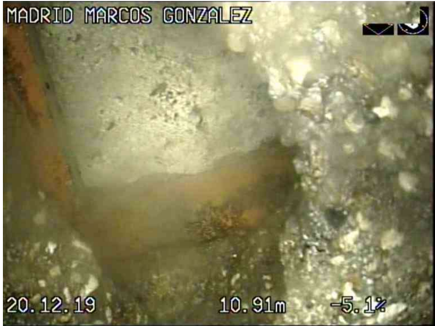
1_93129d11-2c54-4df9-8a43-e39913b9ed27_20191220_112629_604.jpg, 00:01:44, 10.91 ACOMETIDA LADO DERECHO SOBRESALIENTE desde 12 a 2
