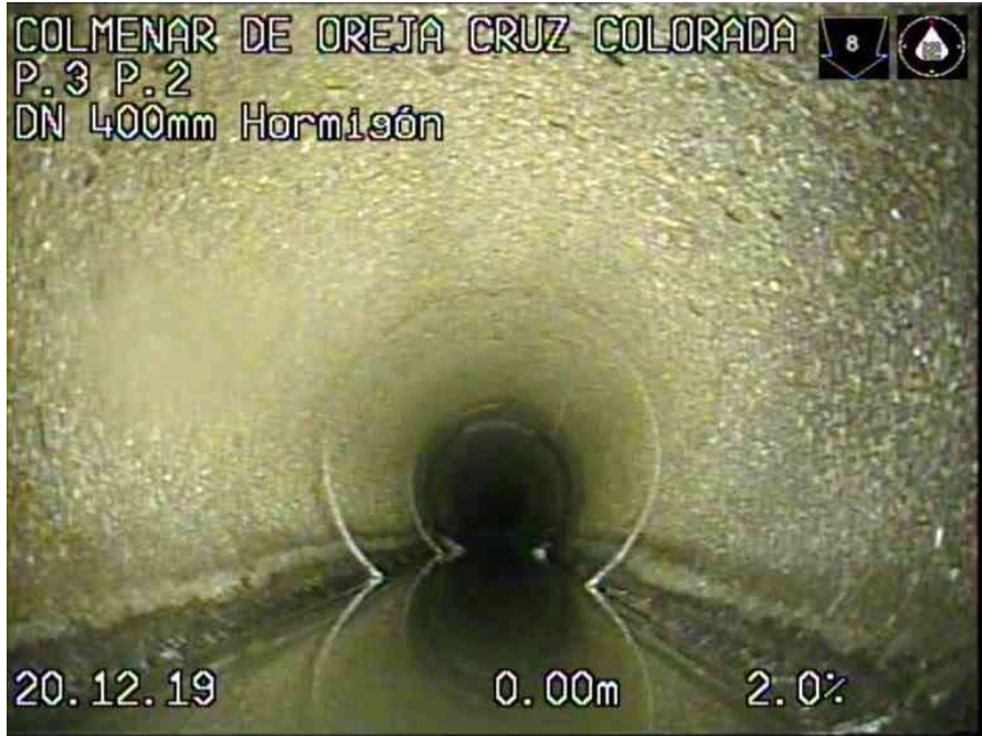
5_f86b02d7-e8d3-4ba0-a132-416a7982a74e_20191220_091520_122.jpg, 00:00:04, 0.00 INICIO DE LA INSPECCION
