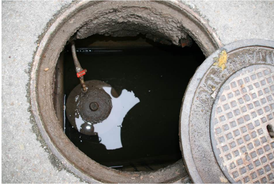
Fotografía nº 12.- Interior pozo PE-1.2 (Cámara de carga)
