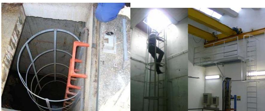
En aquellas instalaciones donde se disponga de espacio suficiente, cuando proceda, se colocarán escaleras metálicas o de obra como solución constructiva preferente, en contraposición con la instalación de escalas de servicio fijas.
