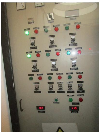
El sistema de control de todo el proceso se realiza comandado por un PLC instalado en un cuadro exclusivo junto al Cuadro de Distribución, en la misma sala.
