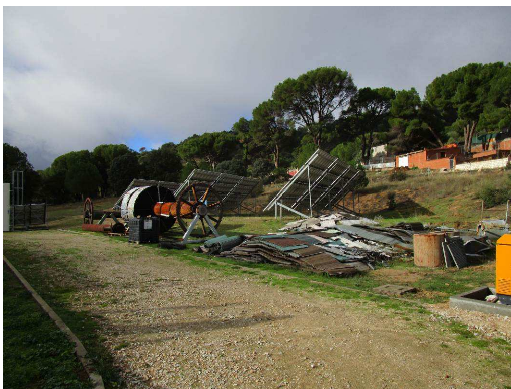
18.- Zona oeste, placas solares a desmantelar y zona de implantación del nuevo edificio
