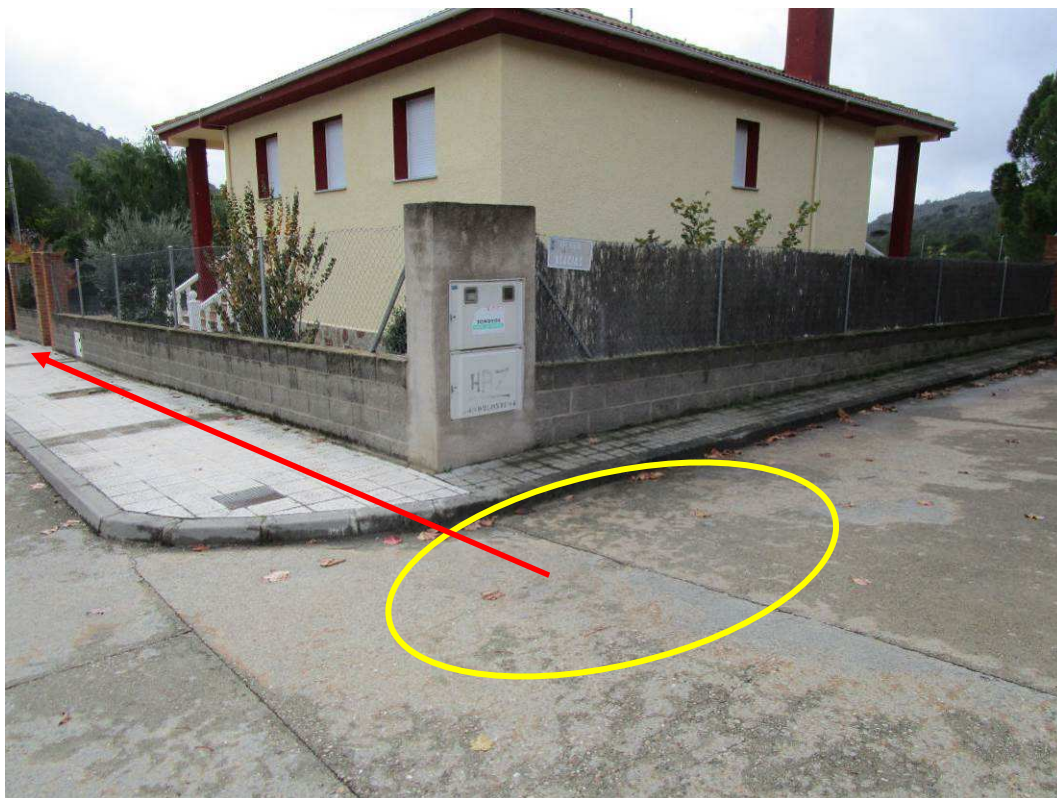
1.- Punto de enganche subterráneo del suministro eléctrico en el cruce de las calles Acacias y Avenida Puente Romano
