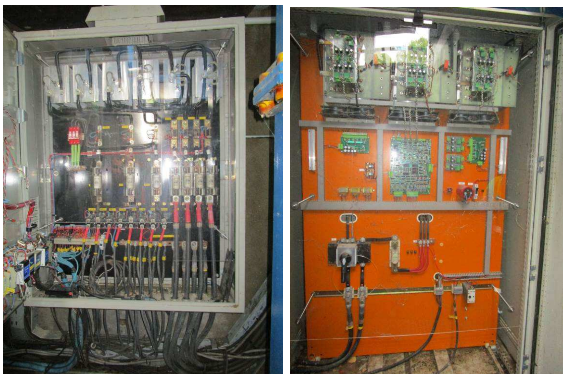
20.- Cuadro de estabilización y filtrado CC-CC (izquierda) e inversor CC-CA (derecha). Ubicados bajo tratamiento biológico
