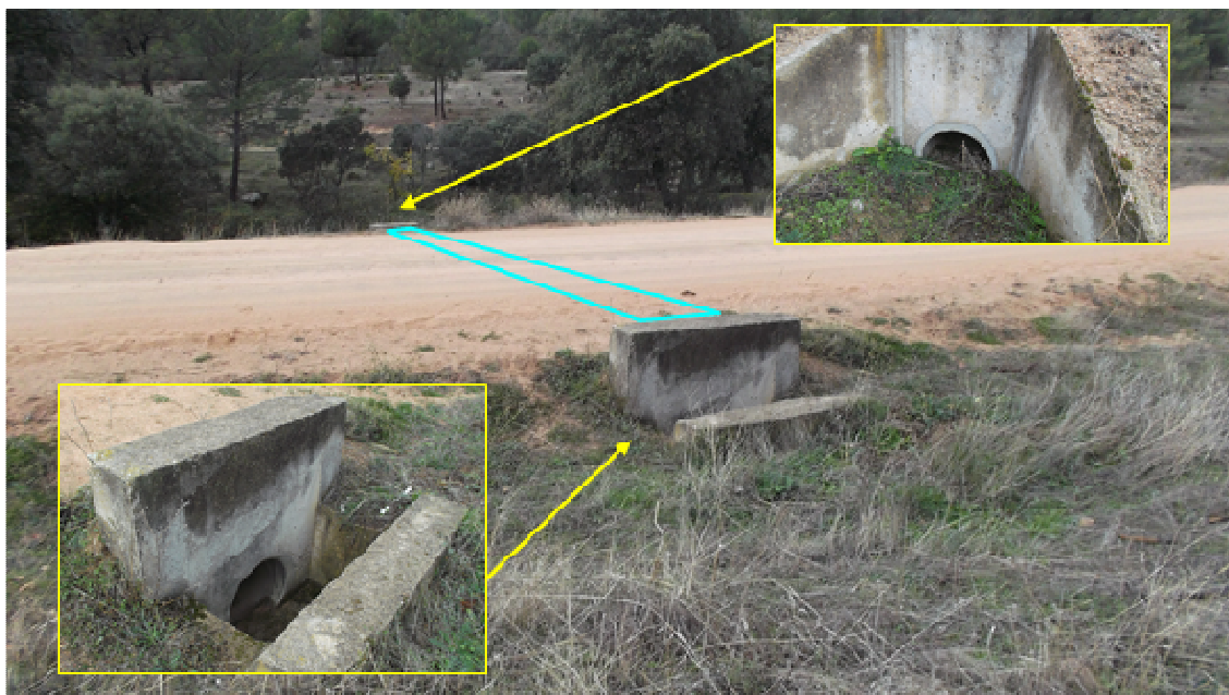
10.- Tercer cruce de drenaje con detalle de sus bocas
