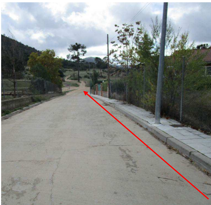
5.- Último tramo urbano del trazado subterráneo de Media Tensión por Avenida Puente Romano, antes de llegar al camino de tierra.
