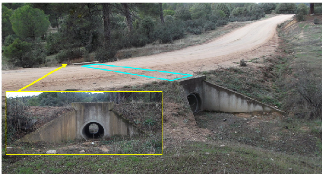
11.- Cuarto cruce bajo camino de drenaje transversal , más próximo a la planta depuradora
