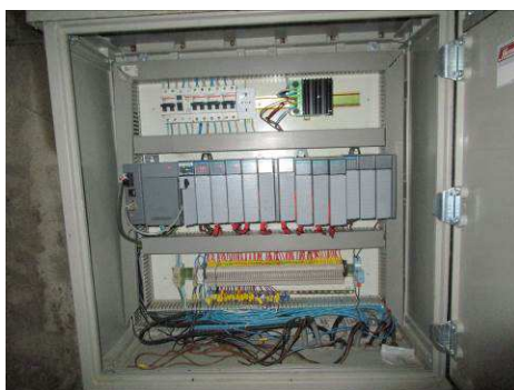
PLC control energético, bajo tratamiento biológico.
