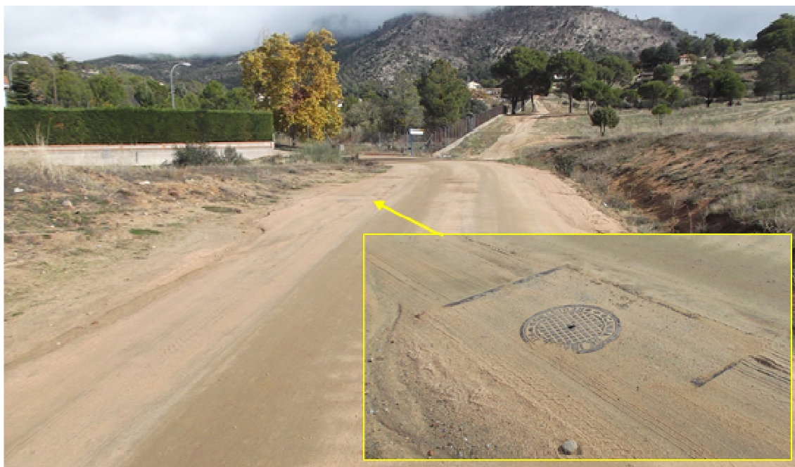
7.- Detalle de tapas de registros de conducción de agua que discurre por el camino.
