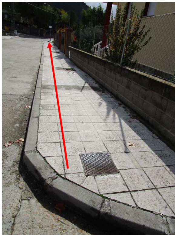
2.- Primer tramo del trazado de la línea subterránea bajo acera de la Avenida Puente Romano
