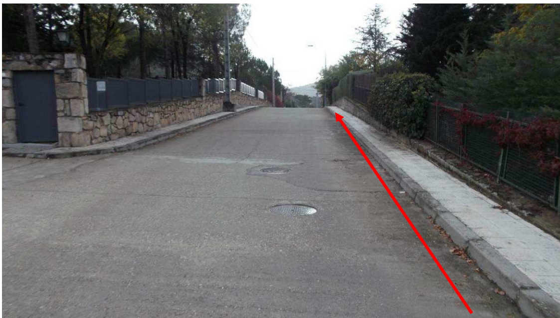
3.- Continuación del trazado de línea de Media Tensión por calzada de Avenida Puente Romano desde su cruce con Calle Pradera Redonda
