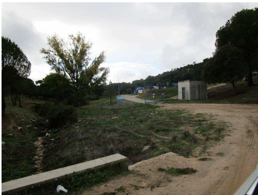
14.- Entrada a la planta depuradora desde el camino de acceso
