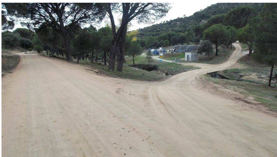
12.- Último tramo del camino en su llegada a la E.D.A.R.
