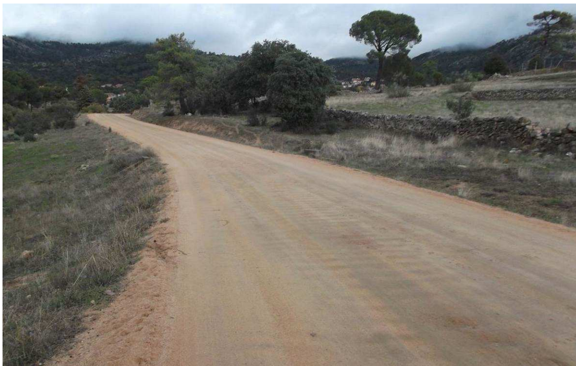
9.- Camino por donde discurre el trazado subterráneo de Media Tensión.
