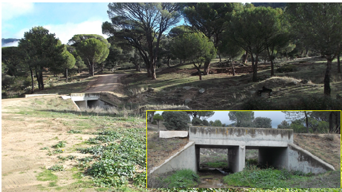
13.- Marco de hormigón de paso sobre el Arroyo Rodajos en la entrada a la E.D.A.R.
