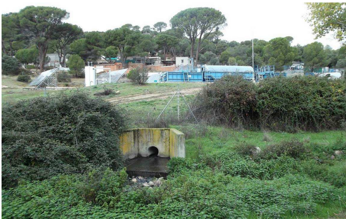
16.- Vista general de la planta desde el punto de vertido
