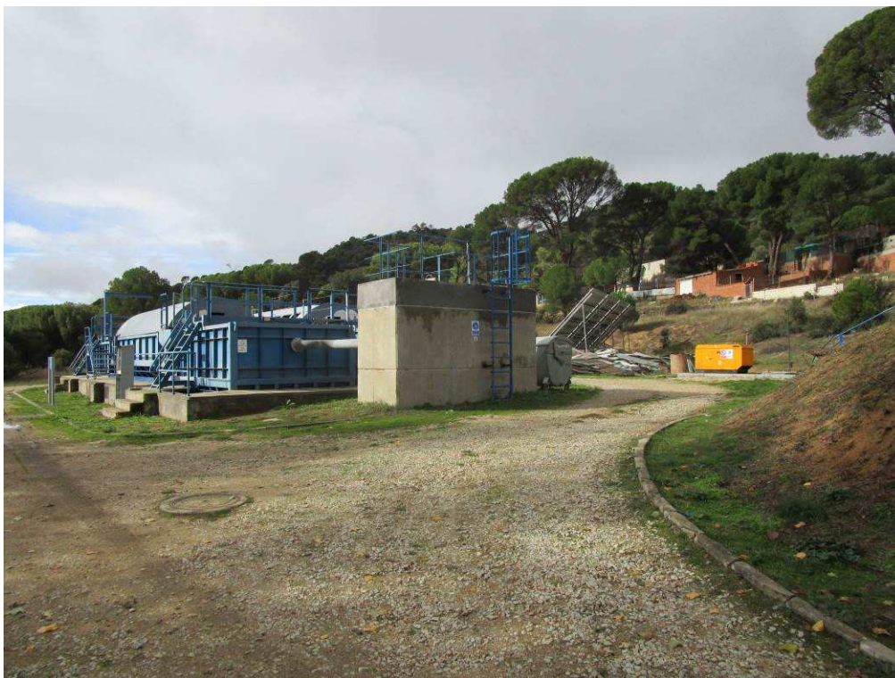
15.- Vista general de la depuradora desde la entrada a la misma
