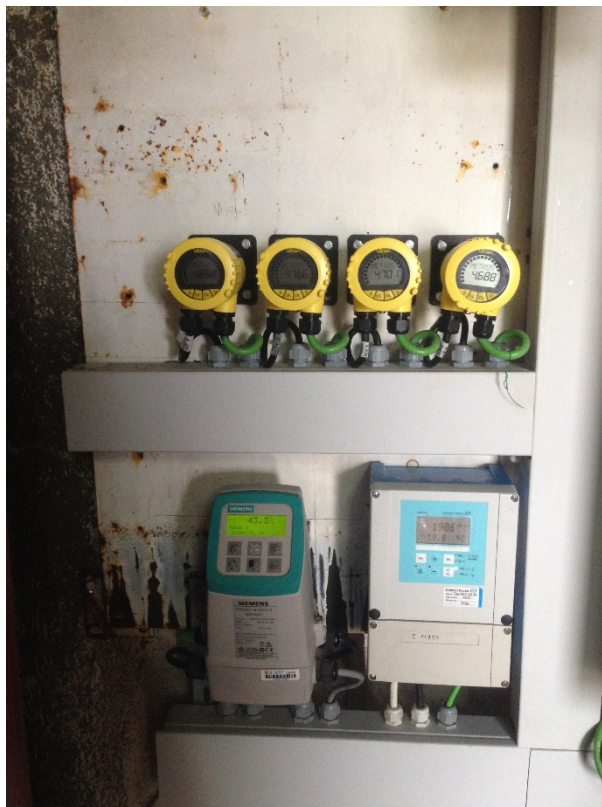
Imagen 27: Instrumentación cuatro niveles radar, un caudalímetro y un transductor de presión.
