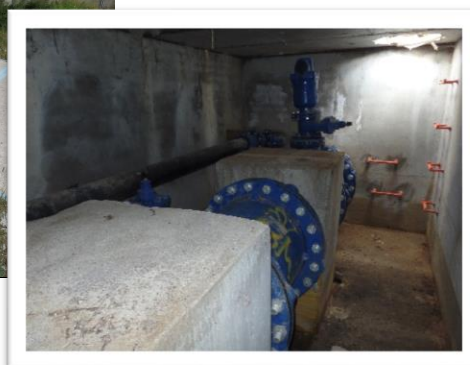
Imagen 7: Arqueta de seccionamiento Bombeo C.I.R (LC2)
