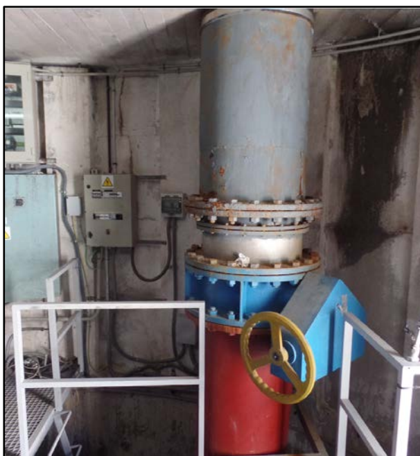
Imagen 6: Línea de llenado depósito 3.500 m 3 construido durante los años 90
