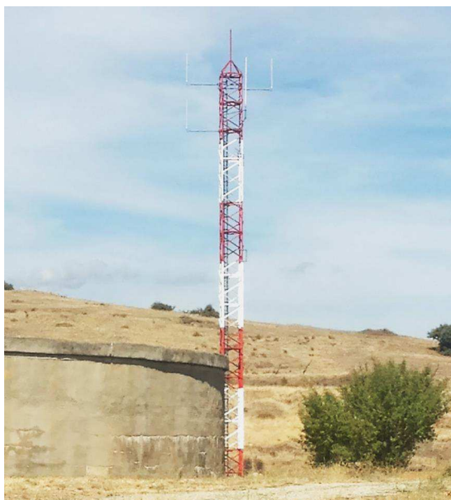
Figura 4: Antena de comunicaciones existente con pararrayos
