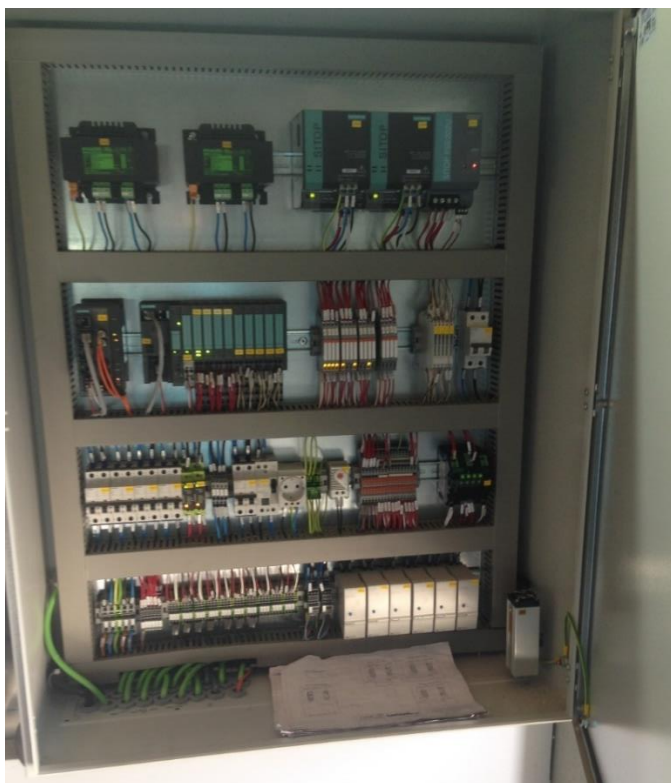
Imagen 32: Armario de la remota en caseta de válvulas existente
