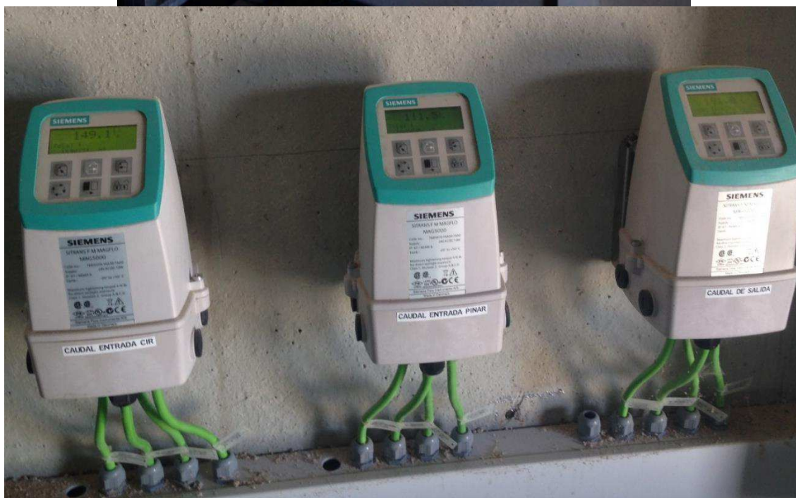
Figura 6: Displays de los caudalímetros en caseta de válvulas existente
