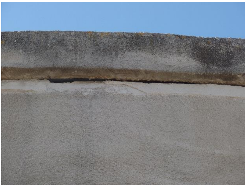
Imagen 33: Vista de viga de coronación
