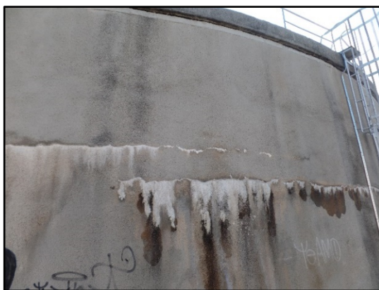
Imagen 1: Filtraciones en depósito de 3.500m 3
