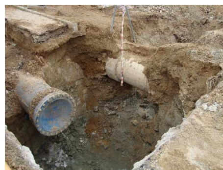
Imagen 2: Brida ciega existente DN800
