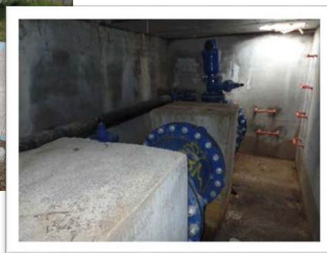
Imagen 7: Arqueta de seccionamiento Bombeo C.I.R (LC2)
