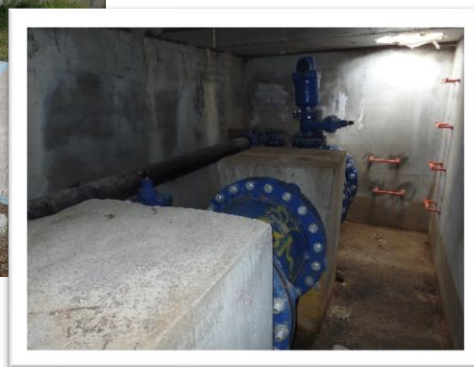
Imagen 9: Arqueta de seccionamiento Bombeo C.I.R (LC2)
