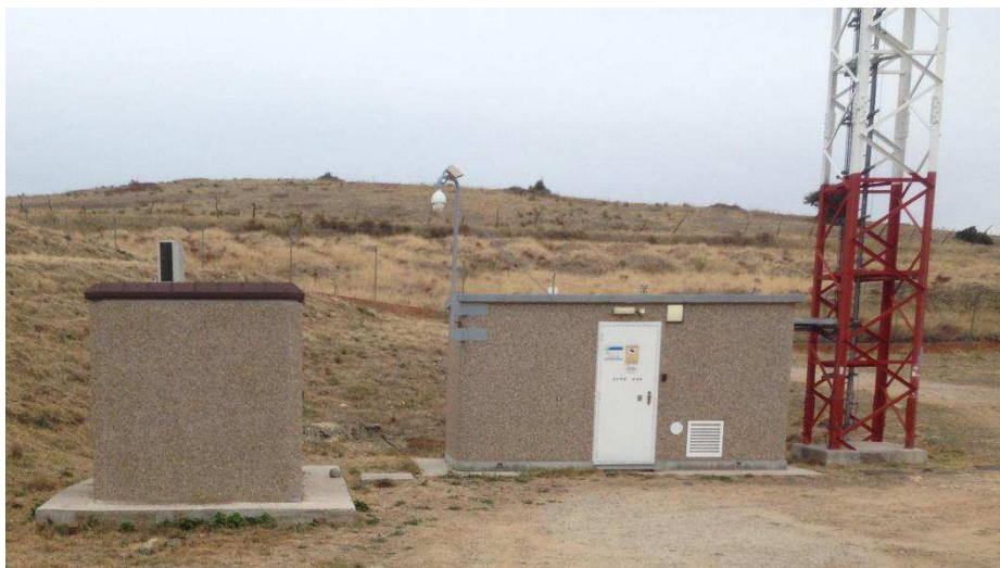
Figura 2: Caseta de instrumentación (izquierda), caseta de comunicaciones (centro), y antena (derecha)
