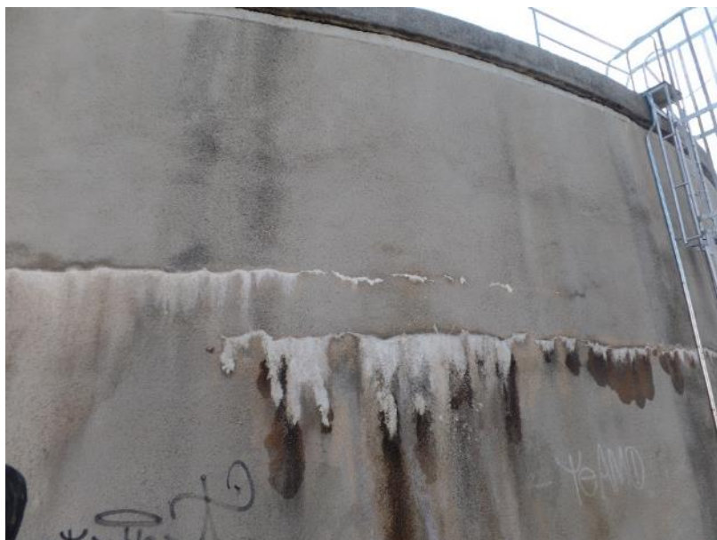
Imagen 31: Vista de las filtraciones con eflorescencias (vaso noroeste)
