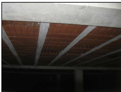
Imagen 3: Vista inferior de forjado con bovedillas desprendidas
