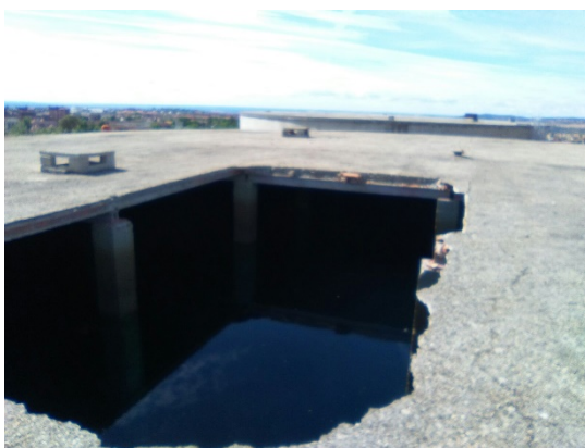
Imagen 2: Rotura de la cubierta
