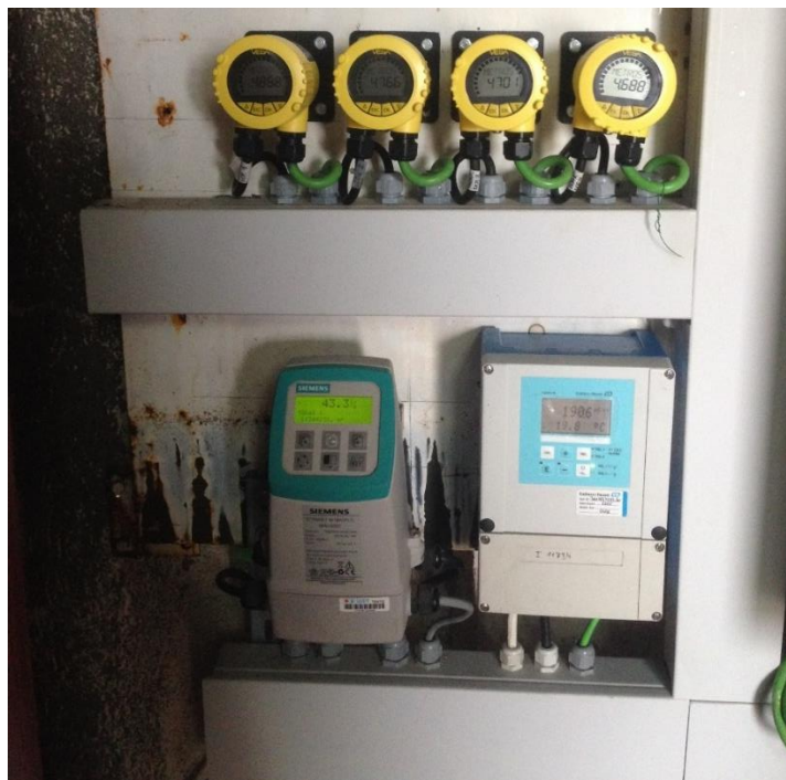
Imagen 30: Displays de instrumentación en la caseta junto a los cuatro depósitos existentes
