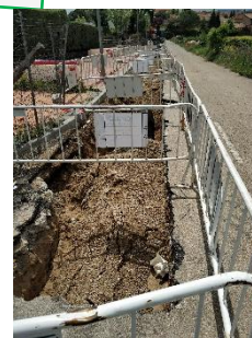
Imagen 15: Tubería en ejecución
