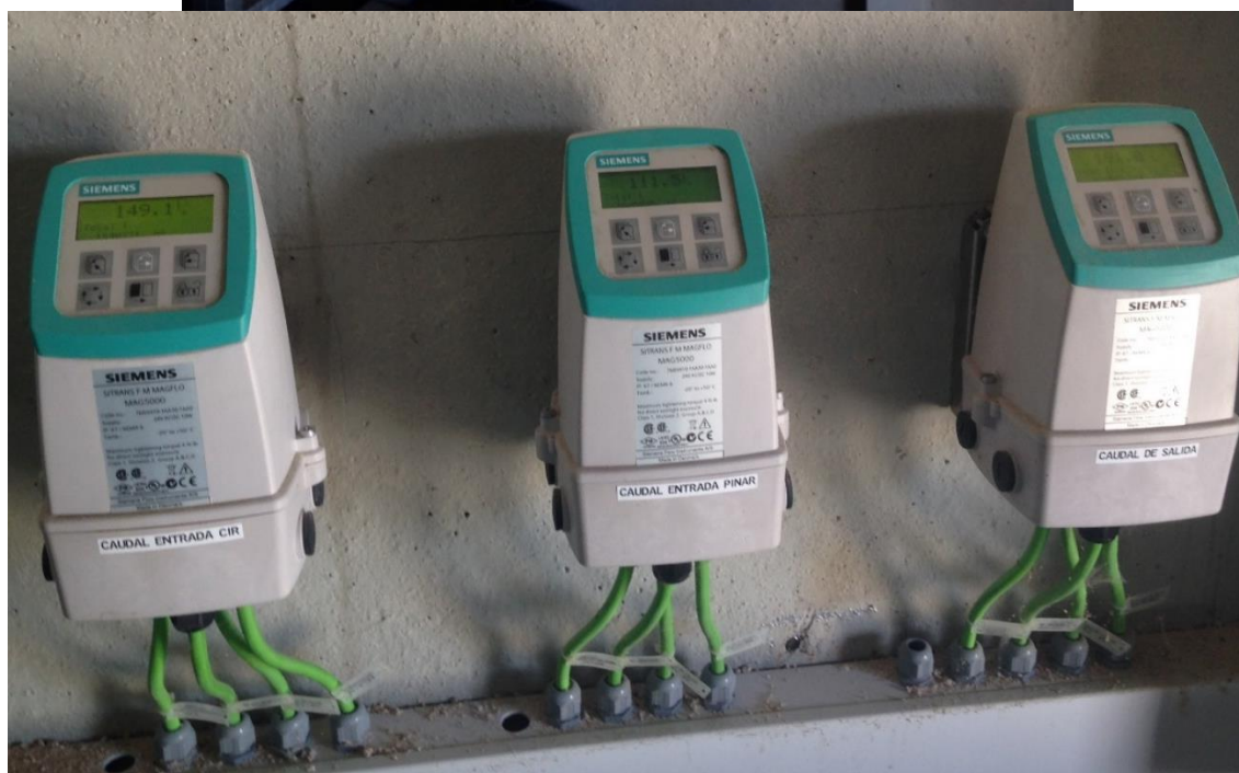
Imagen 33: Displays de los caudalímetros en caseta de válvulas existente
