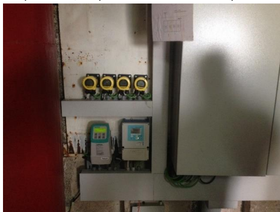
Imagen 18: Cuatro niveles y transductor de presión
