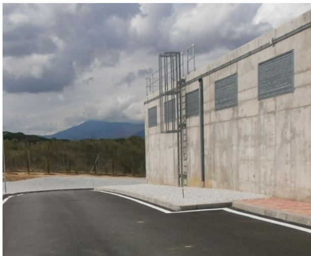
Imagen 1: Ejemplo escalera de acceso y barandillas de protección.
