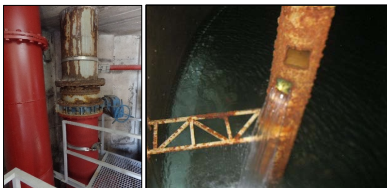
Imagen 5: Estado de las conducciones deterioradas
