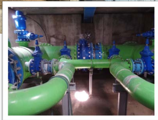
Imagen 15: Arqueta de salida unión de líneas S1 y S2
