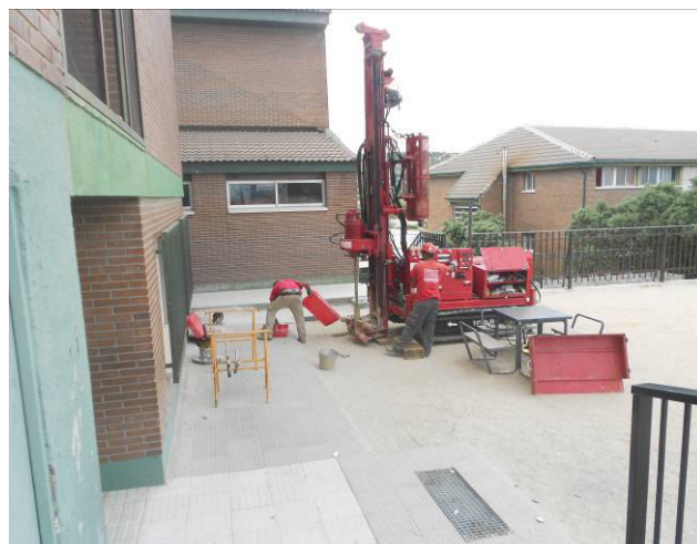
Vista del sondeo S-2, escalera de emergencia del edificio 3 Se aprecia la arqueta con rejilla central, que esta vinculada con la arqueta del costado derecho, visto el proyecto de frente a fachada (31 de Mayo 2017)
