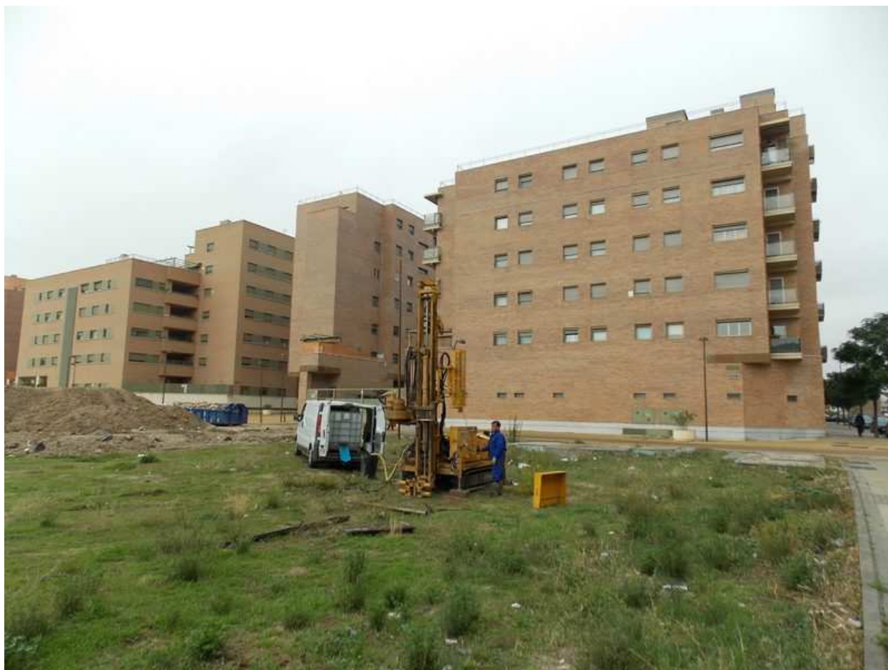
FOTOGRAFIA 11: Vista de la perforación del sondeo 6.
