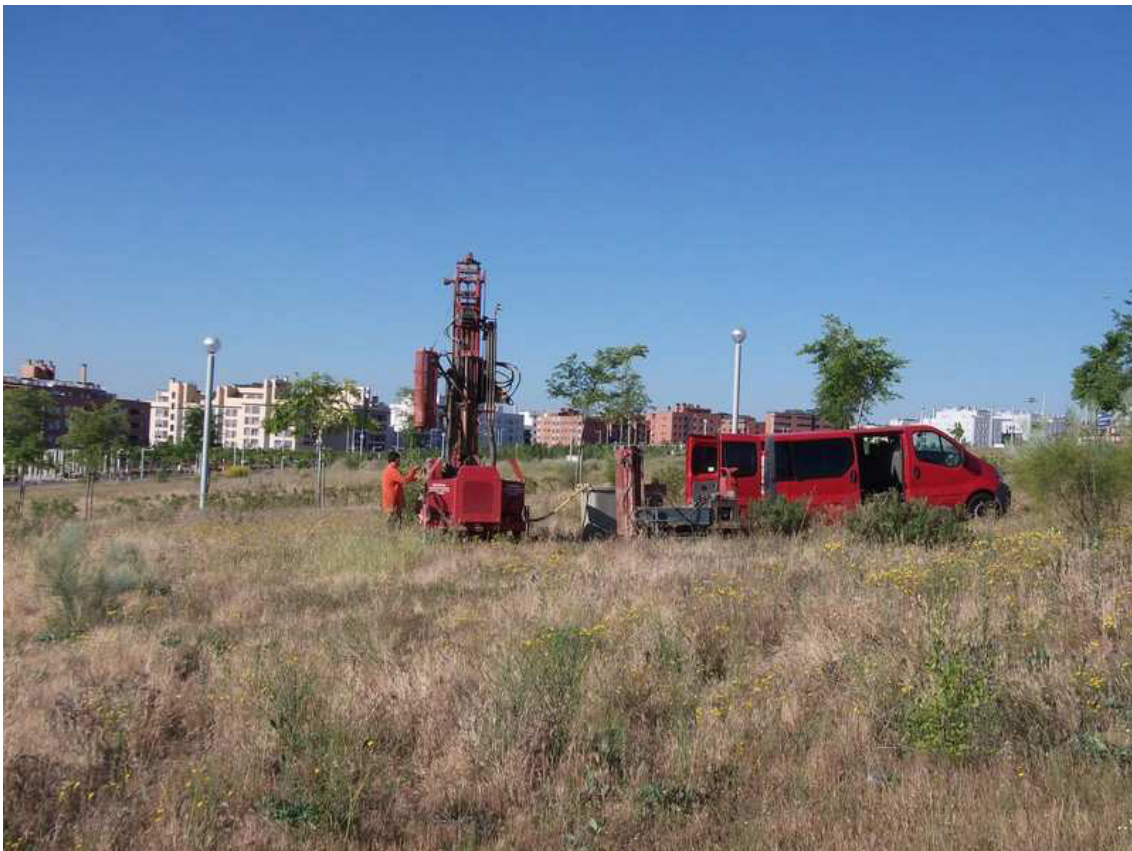
FOTOGRAFIA 2: Vista de la realización del sondeo 3 y penetrómetro 3.
