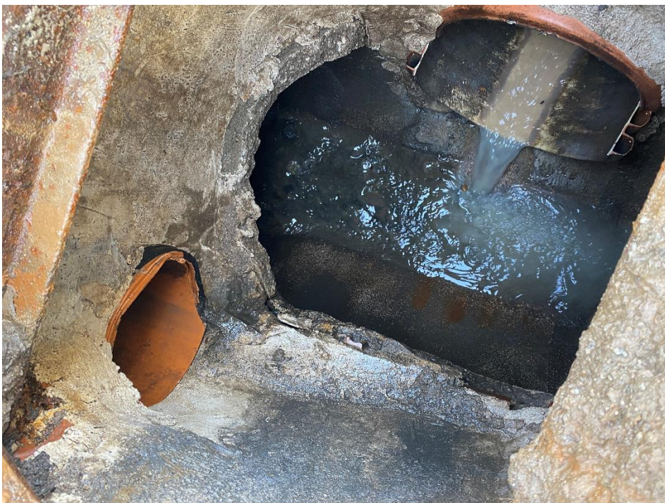
Imagen 9: Calle Escuelas. Pozo P.62GC-154. Profundidad 1,68 m
