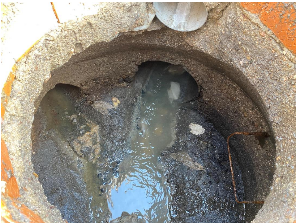
Imagen 27: Calle Escalona. Pozo P.62GC-47. Profundidad 1,20 m
