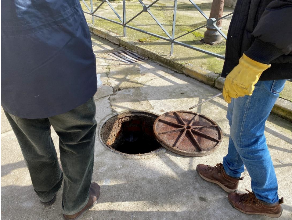
Imagen 26: Calle Escalona. Pozo P.62GC-47
