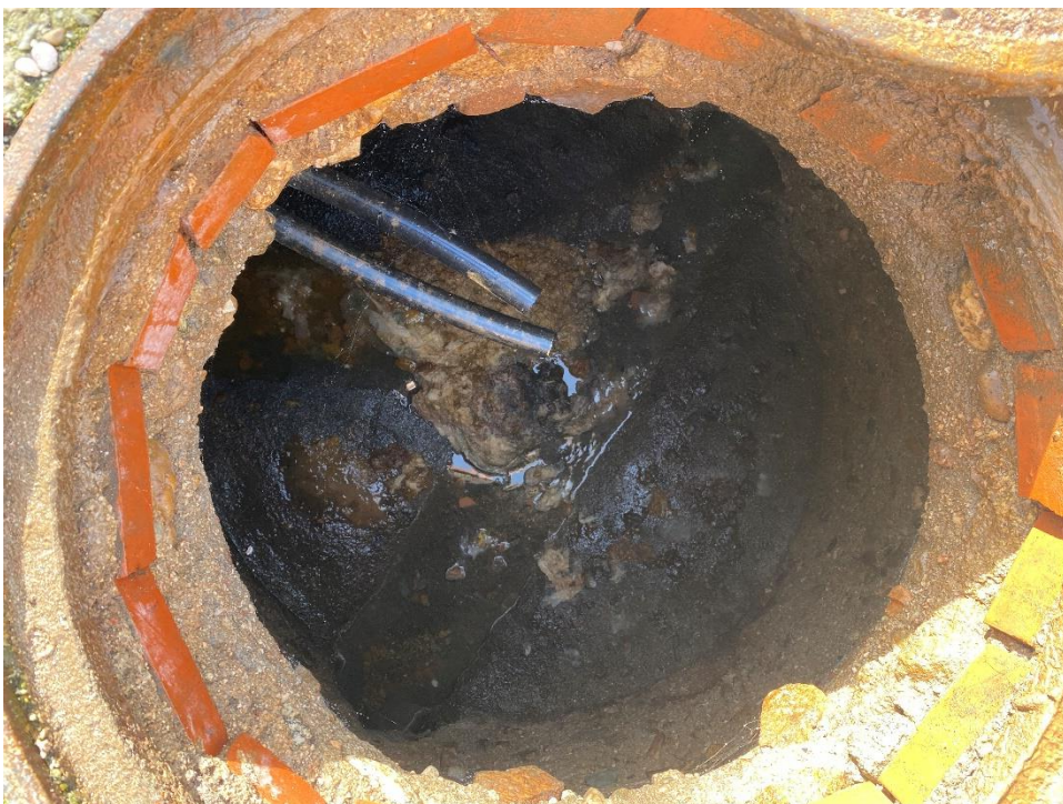
Imagen 5: Calle Paredes. Pozo P.62GC-195. Profundidad 1,11 m
