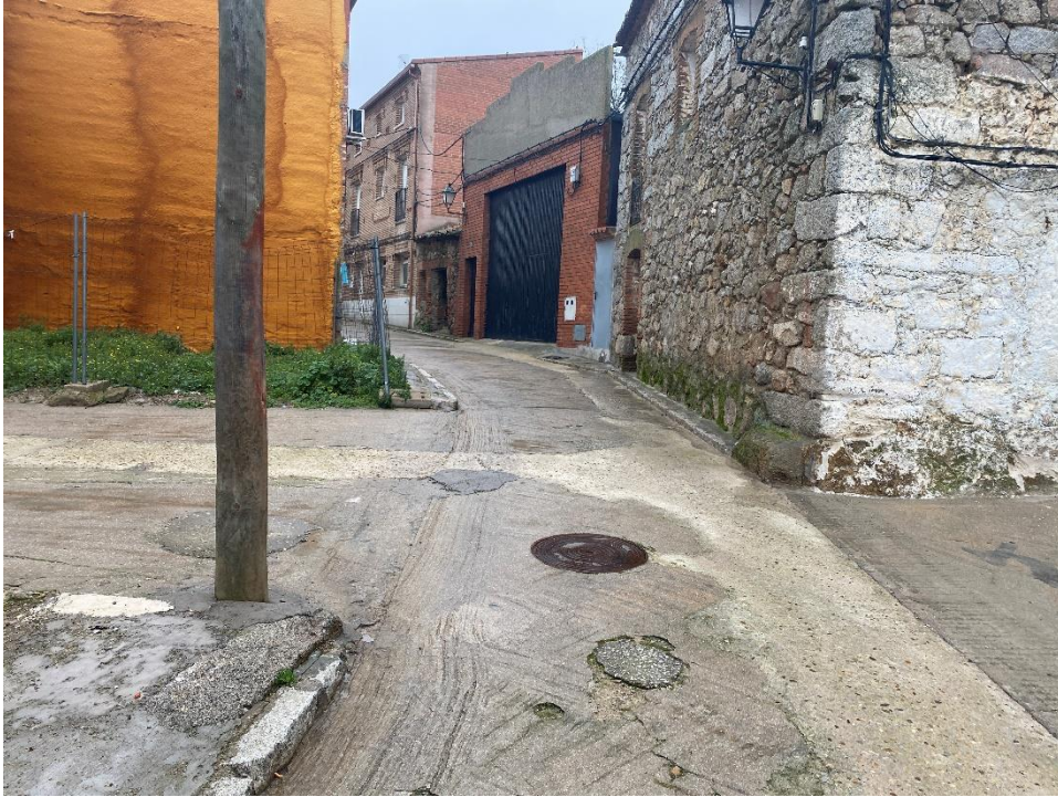
Imagen 4: Calle Paredes. Pozo P.62GC-195
