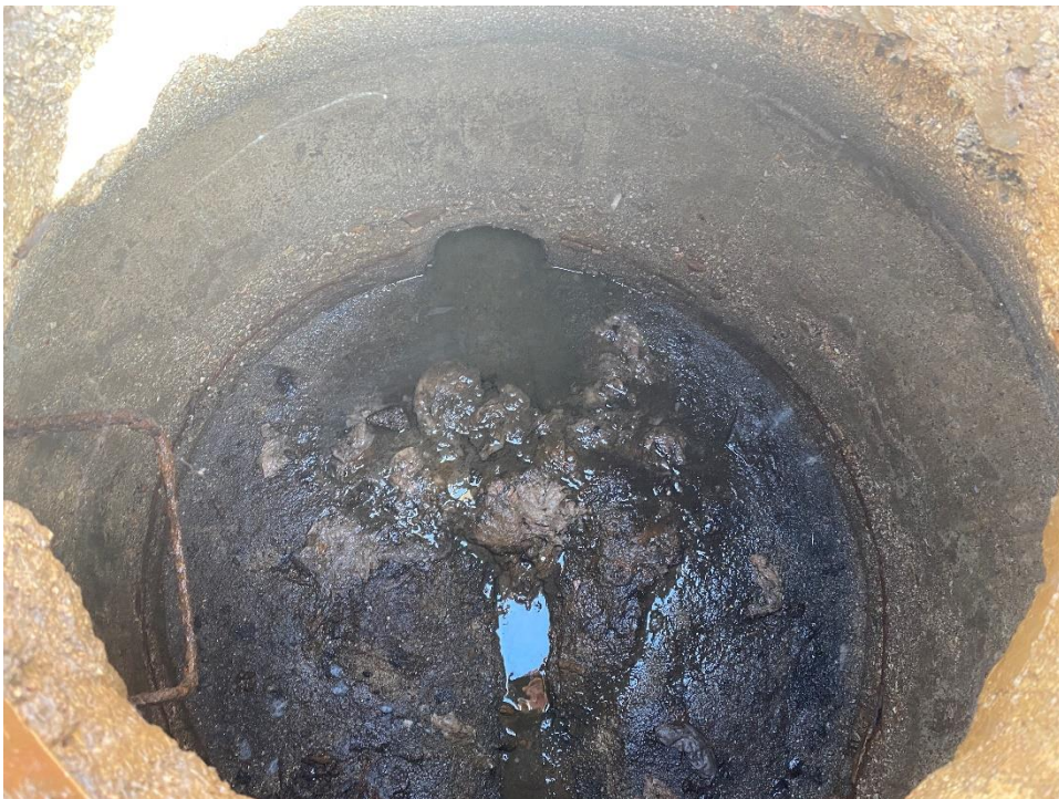
Imagen 15: Calle Doctor Abad. Pozo P.62GC-181. Profundidad 1,36 m
