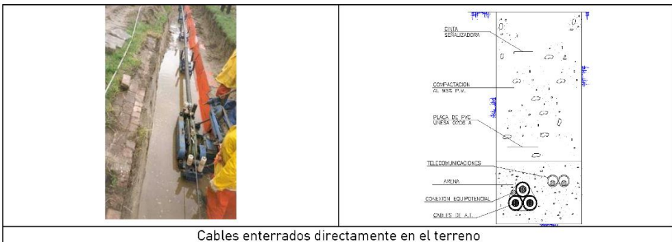
Cables enterrados directamente en el terreno
