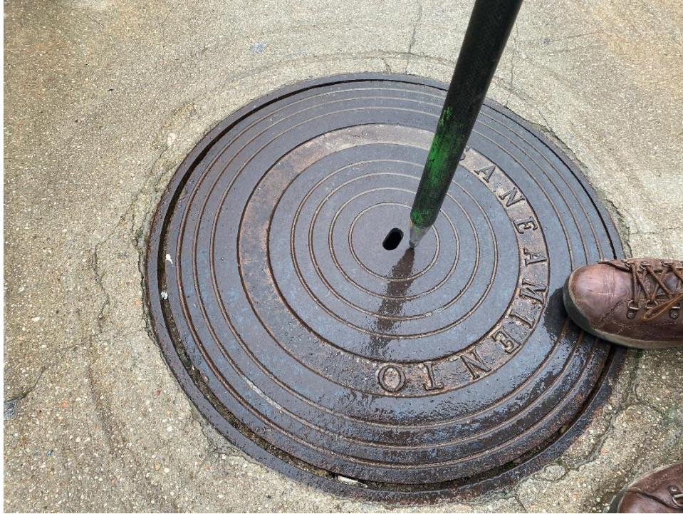
Imagen 6: Calle Paredes. Pozo P.62GC-52
