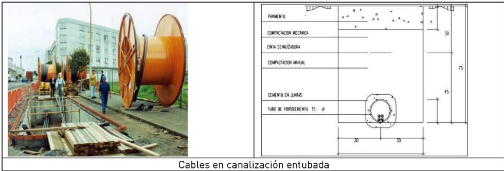
Cables en canalización entubada
