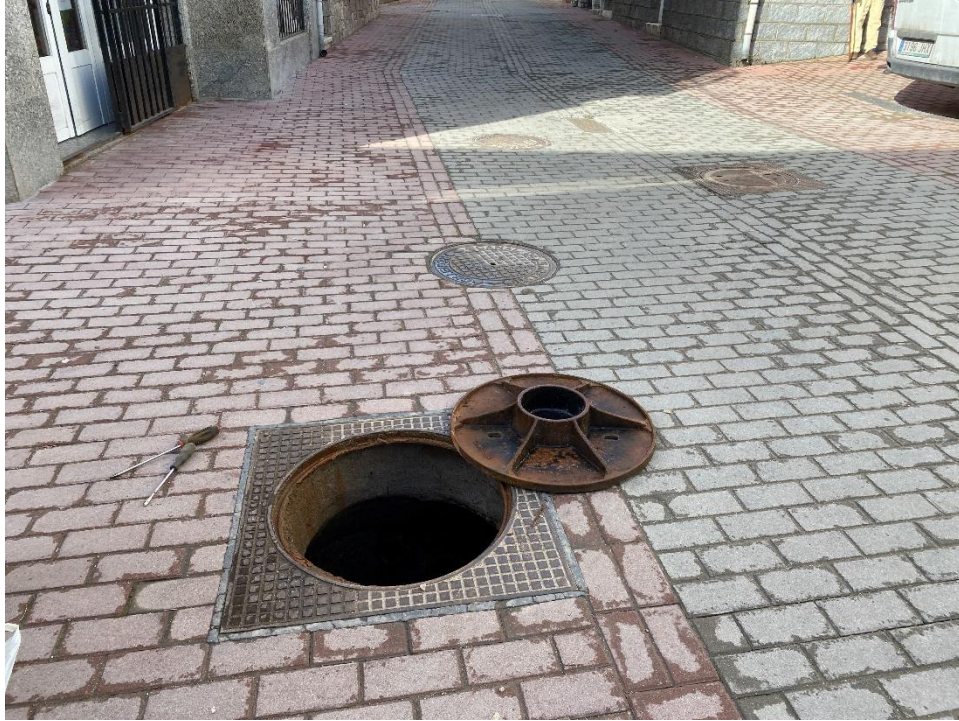
Imagen 24: Calle Escalona. Pozo P.62GC-187
