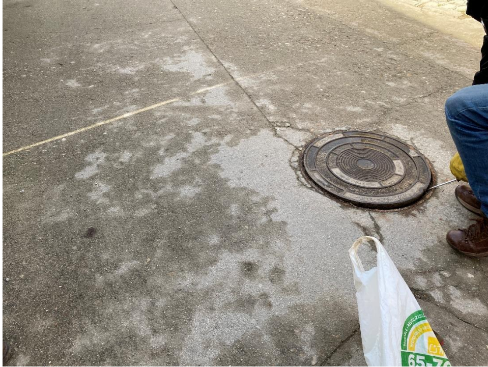
Imagen 28: Calle Escalona. Pozo P.62GC-49
