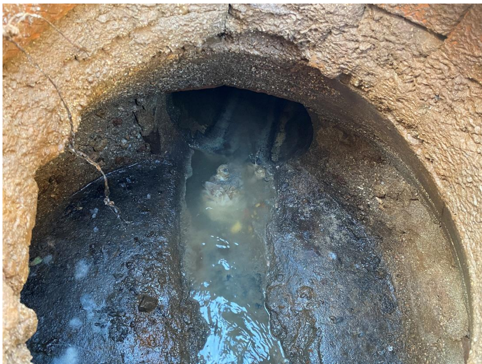
Imagen 29: Calle Escalona. Pozo P.62GC-49. Profundidad 1,12 m
