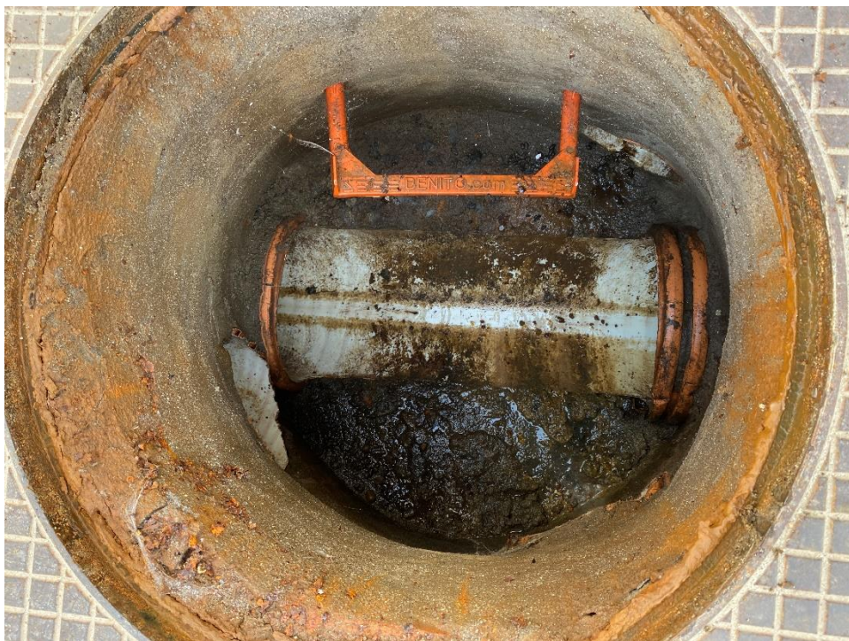
Imagen 25: Calle Escalona. Pozo P.62GC-187. Profundidad 1,25 m
