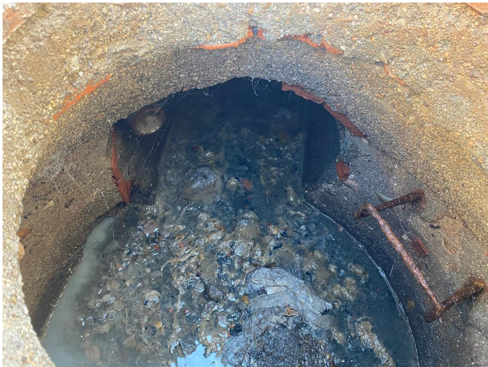
Imagen 7: Calle Paredes. Pozo P.62GC-52. Profundidad 1,11 m
