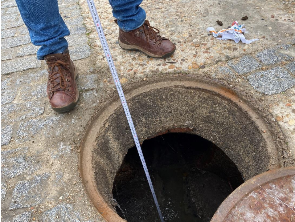
Imagen 16: Calle Doctor Abad. Pozo P.SC-01
