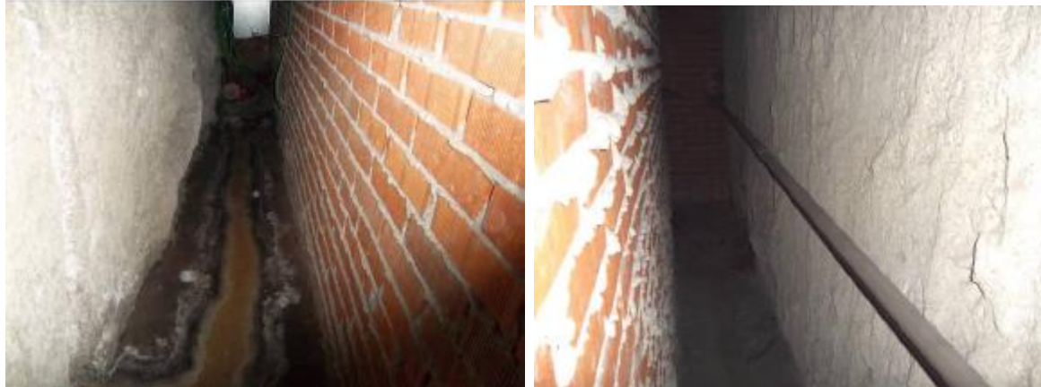
Cámara bufa nivel vestíbulo: Pantalla derecha en zona tras cuartos con agua (izquierda) y pantalla frontal en zona tras cuartos, seca (derecha)
