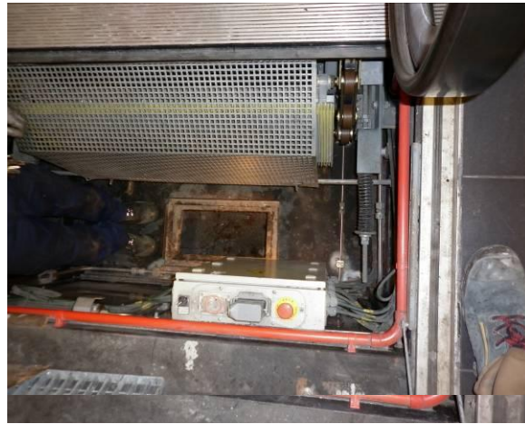
F-29. Foso escalera mecánica nº 6. Seco.
