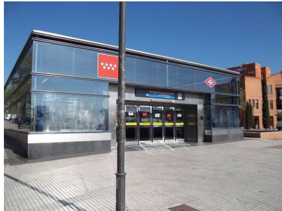
F-1. Acceso. Vista exterior del templete de acceso (frente).
