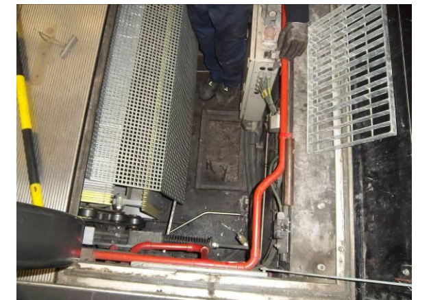
F-10. Escaleras acceso. Foso escalera mecánica nº 1. Seco.
