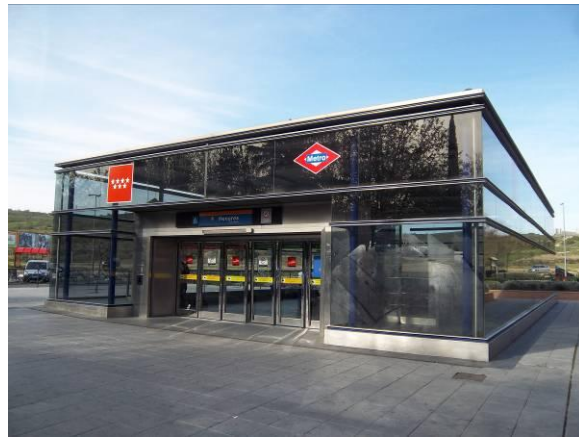
F-1 Templete exterior. Vista frontal.
