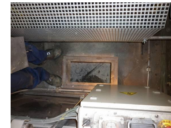
F-31. Escaleras vestíbulo-andén 2. Foso escalera mecánica nº 5. Seco.
