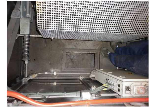
F-28 Escaleras vestíbulo-andén 1. Foso escalera mecánica nº 3. Seco.
