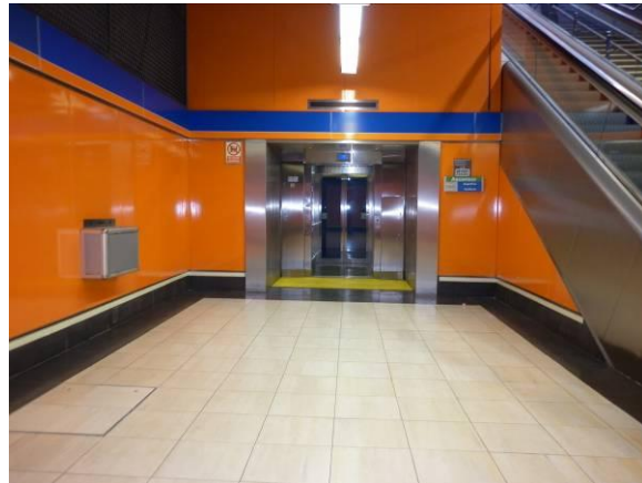
F-3. Aspecto del solado en acceso.
