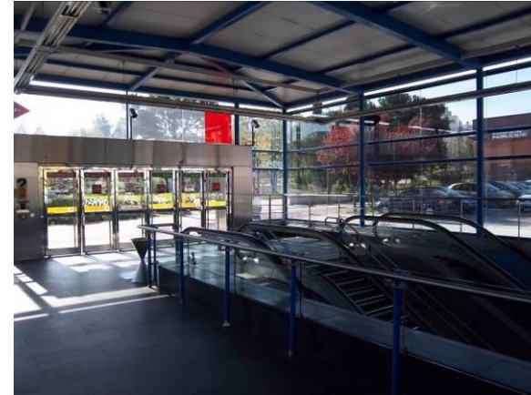
F-2. Vista del templete de acceso (interior).
