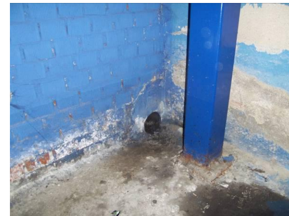
F-31. Desagüe foso ascensor vestíbulo-andén 1.
