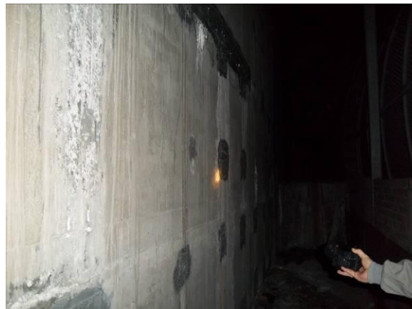
F-84 Pozo de extracción. Muro lateral izquierdo. Impermeabilización.
