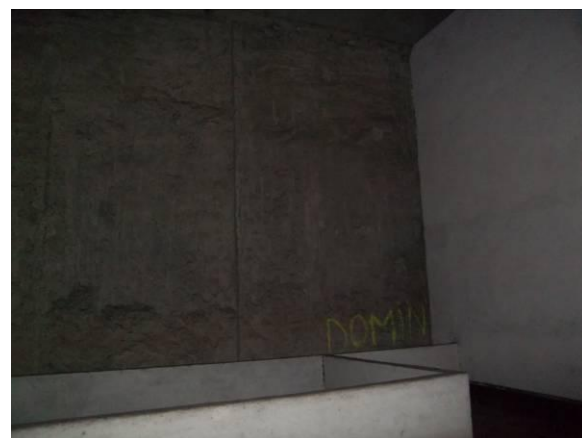
F-37. Nivel vestíbulo. Pozo de compensación entre salidas de emergencia. Aspecto de pantalla frontal final.
