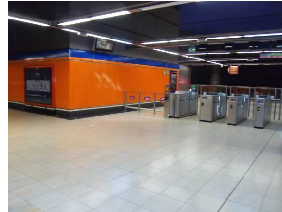
F-15. Vestíbulo. Aspecto general, solado.
