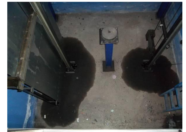
F-32. Foso ascensor vestíbulo-andén 2. Seco.
