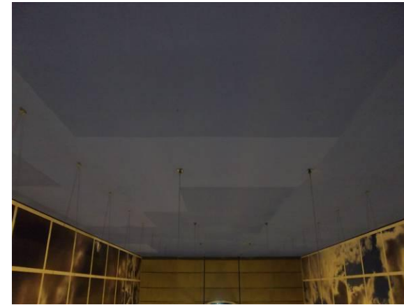
F-38. Cara inferior de losa vestíbulo desde nivel intermedio. Zona estrecha de la estación.
