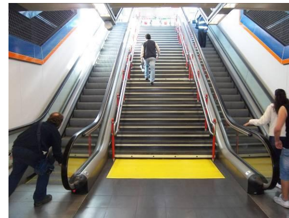
F-9. Escaleras acceso, tramo superior (escaleras mecánicas nº 1 y nº 2).
