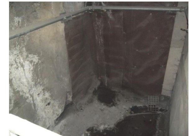
F-85. Pozo compensación andén 2. Pantalla frontal final en entronque con túnel.
