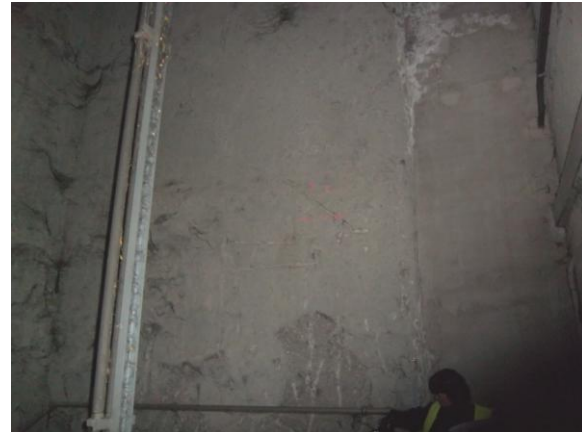
F-33. Nivel vestíbulo (pantalla derecha). Coquera y humedad en inicio zona estrecha de estación.
