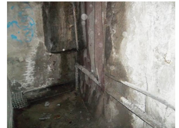
F-52 Pozo compensación andén 1. Pantalla frontal final en entronque con túnel.
