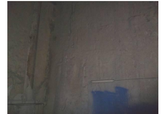
F-24. Nivel vestíbulo. Pantalla lateral izquierda en zona ancha estación.
