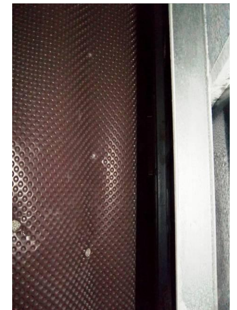
F-44. Cámara bufa andén 1 en zona estrecha estación. Lámina drenante.
