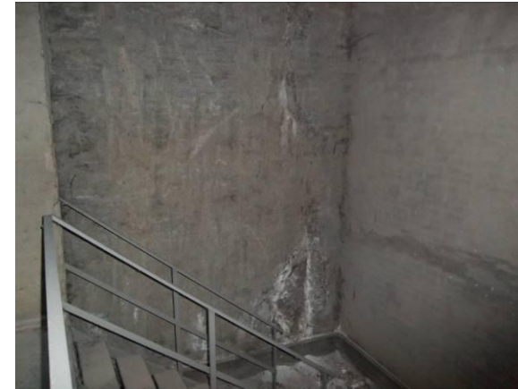
F-62. Pozo inmisión andén 2 tras sala de ventilación. Aspecto pantalla lateral.
