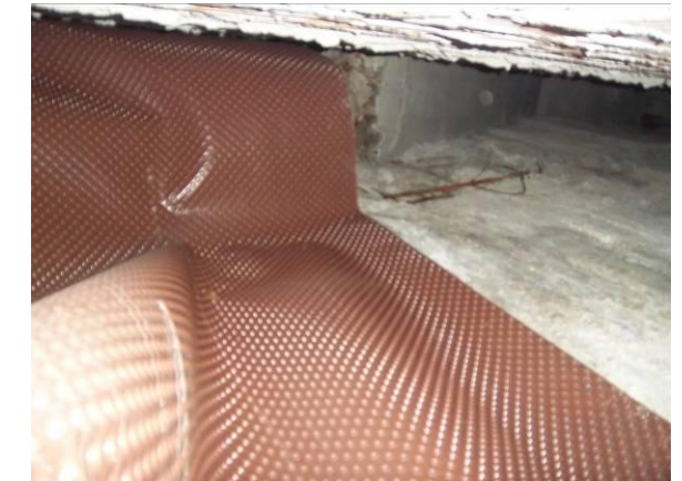
F-107. S. emergencia andén 2, Aspecto cámara bufa en segundo rellano.
