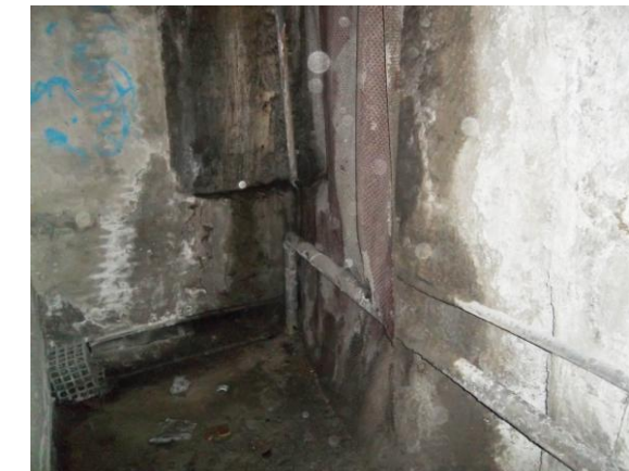
F-81. Pozo compensación andén 1. Pantalla frontal final en entronque con túnel.
