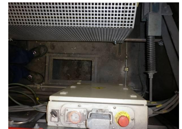
F-32 Escaleras vestíbulo-andén 2. Foso escalera mecánica nº 6. Seco.
