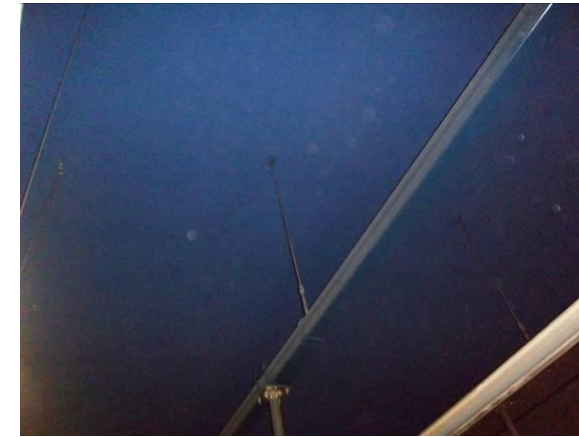
F-39. Losa de vestíbulo. Aspecto cara inferior desde andén 2.
