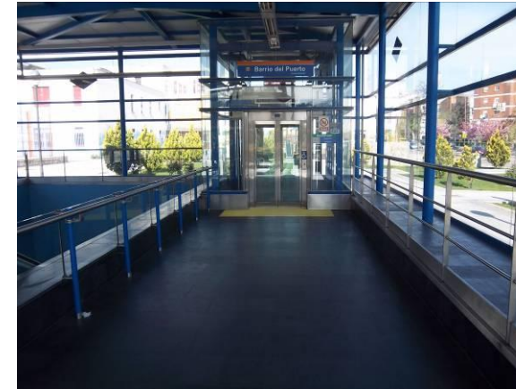
F-7. Vista ascensor del acceso en templete.
