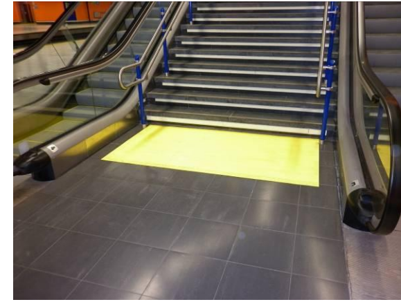
F-23. Escaleras vestíbulo-andén 1 (Escaleras mecánicas nº 3 y nº 4).
