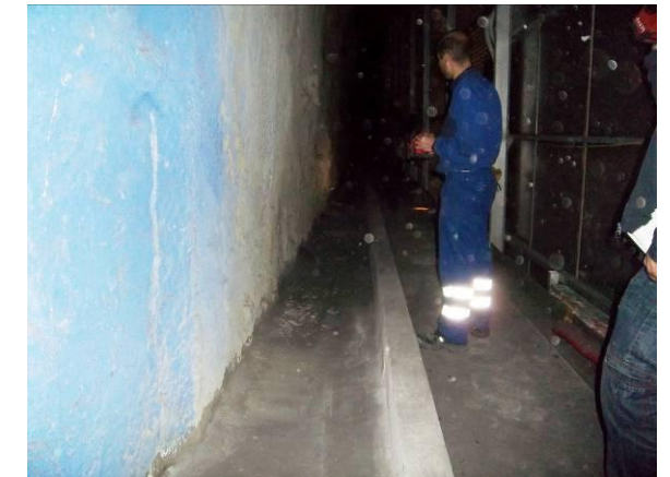
F-18. Camara bufa nivel vestíbulo tras escaleras acceso andén. Pantalla izquierda
