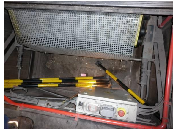
F-30. Nivel intermedio. Foso escalera mecánica nº 4, seco.
