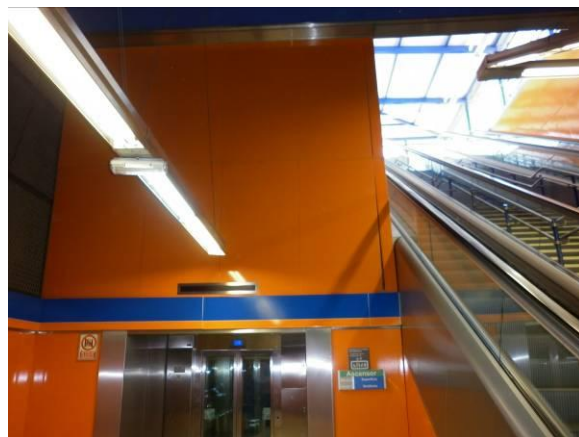
F-5. Vitrex "des cuadrados" en zona de acceso (hueco de ascensor).
