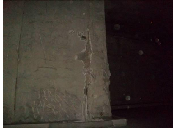
F-33. Nivel vestíbulo (pantalla derecha). Coquera y humedad en inicio zona estrecha de estación.
