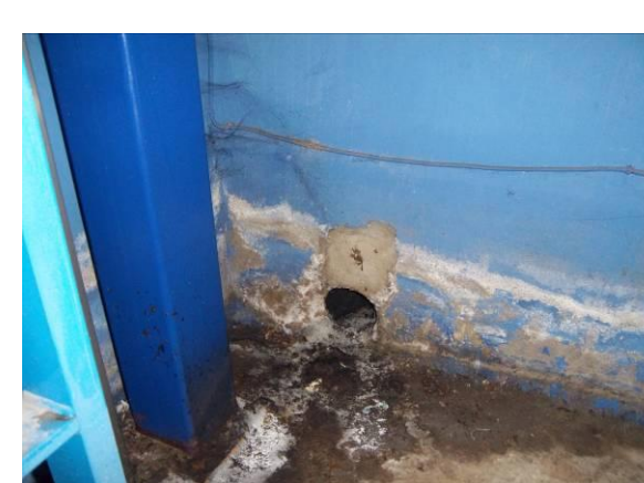
F-33. . Desagüe foso ascensor vestíbulo-andén 2.
