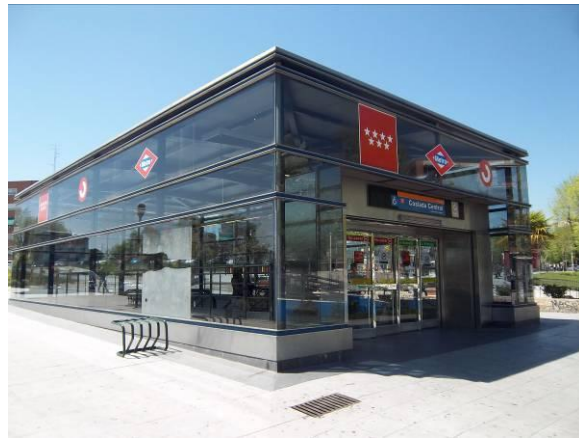
F-1. Vista del templete de acceso (exterior).
