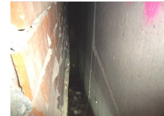
F-93. Salida de emergencia acceso al exterior. Cámara bufa tras escaleras de acceso al portón.
