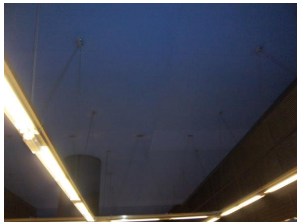
F-3. Aspecto de losa de cubierta de acceso.
