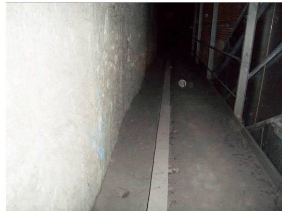
F-16. Nivel vestíbulo. Pantalla lateral derecha. Canaleta en zona ancha.
