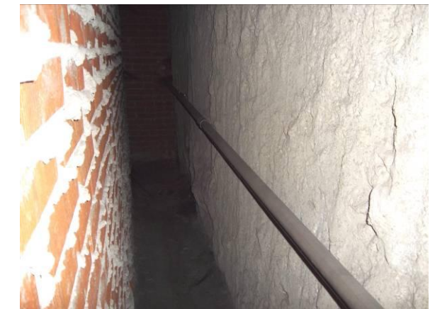
F-20. Camara bufa nivel vestíbulo. Pantalla frontal en zona tras cuartos. Seca.
