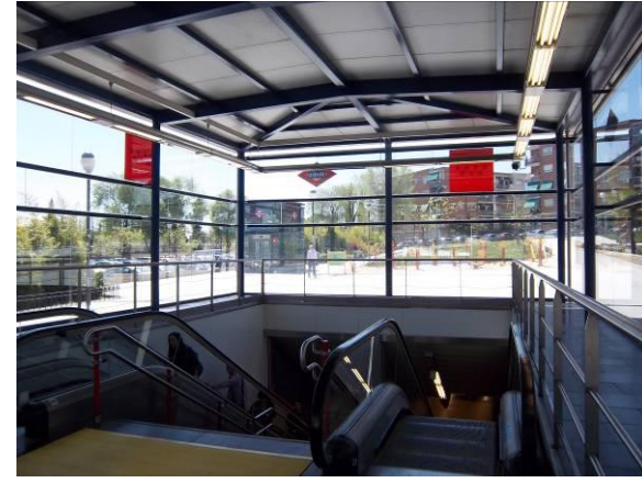
F-2. Vista del templete de acceso (interior).
