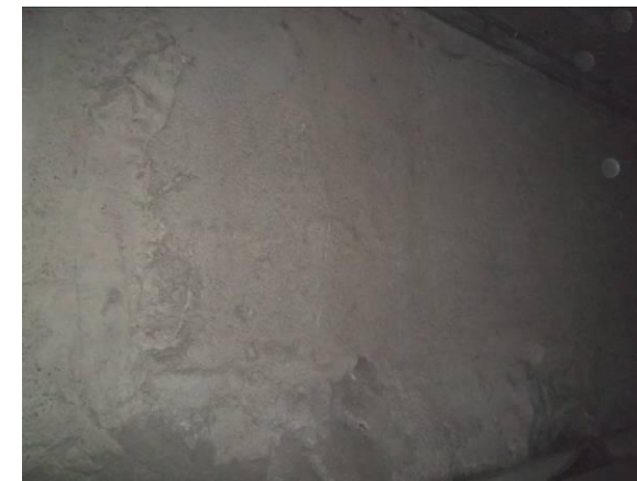
F-25. Nivel vestíbulo. Pozo compensación final estación. Pantalla lateral izquierda.
