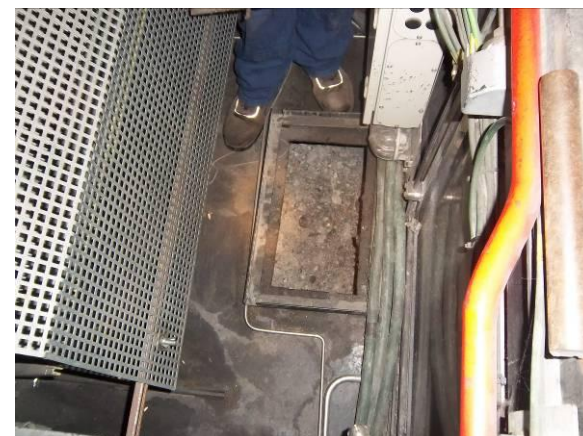
F6. Foso escalera mecánica nº 1. Seco.
