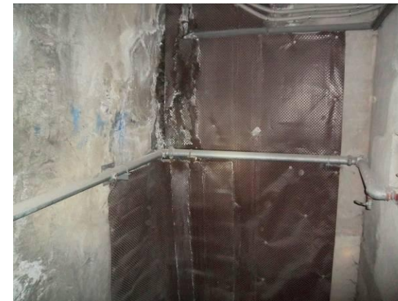
F-84. Pozo compensación andén 2. Pantalla frontal final en entronque con túnel.
