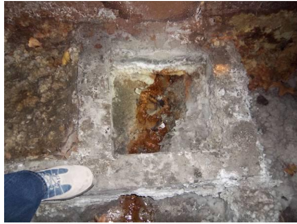
F-80 Pozo de extracción. Arqueta de drenaje desagüando a drenaje central.
