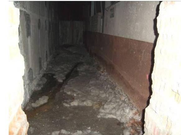
F-83 Pozo de extracción. Vista del lado izquierdo del pozo hacia P.K. crecientes.
