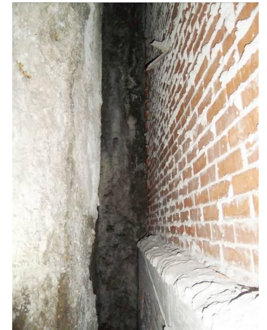
F-45. Nivel andén. Pozo de inmisión, canaleta a pie de pantalla colmatada e inundada.
