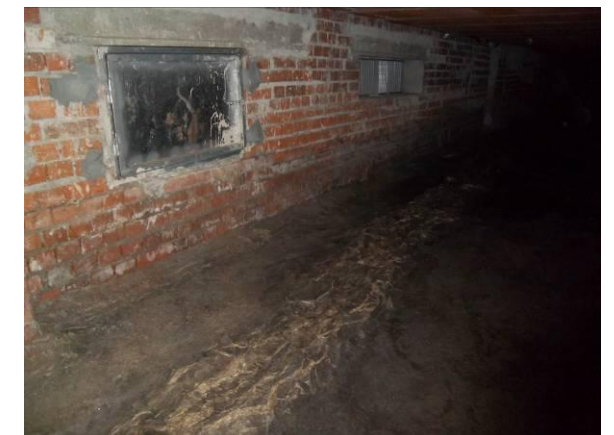
F-89. Bajo andén 2. Zona estrecha al final del bajo andén 2,
