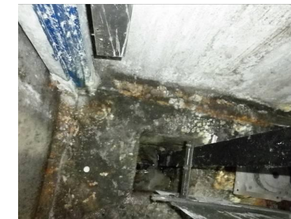
F-9. Acceso. Foso ascensor de acceso. Humedades en paramento lateral. Detalle del desagüe.
