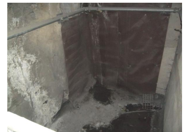
F-65. Pozo compensación andén 2. Pantalla frontal final en entronque con túnel.
