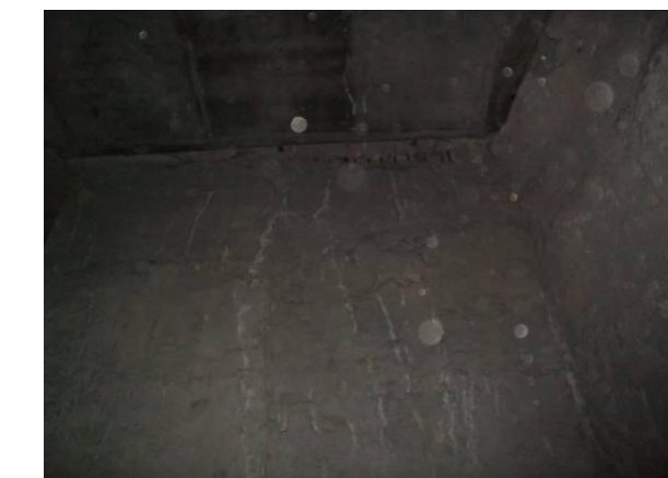
F-32. Nivel vestíbulo (pantalla derecha). Coquera (pantalla perpendicular al eje de estación).
