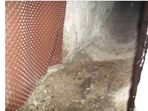
F-106. S. emergencia andén 2, Aspecto cámara bufa en segundo rellano.
