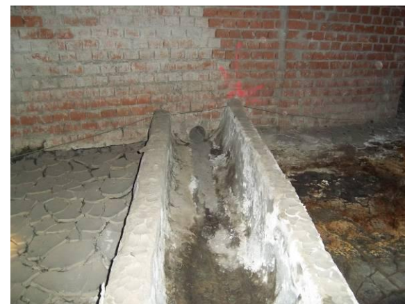
F-48. Bajo andn 2. Canaleta transversal operativa.
