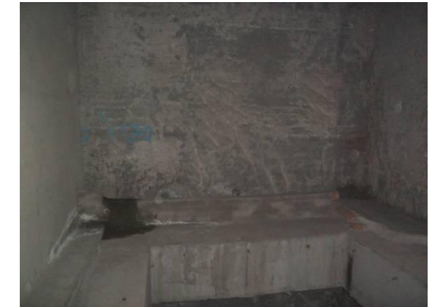
F-16. Nivel vestíbulo. Pozo de inmisión lado derecho. Aspecto de pantalla.
