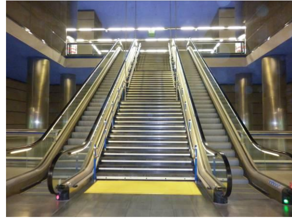
F-28. Nivel intermedio. Escaleras de acceso (Escaleras mecánicas nº 3 y nº 4).
