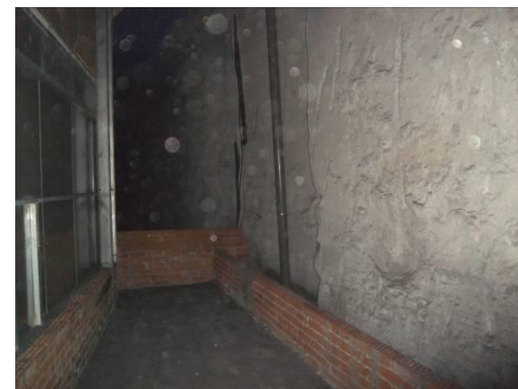
F-42. Nivel intermedio. Pantalla perimetral lado izquierdo (tecleo), y canaleta.
