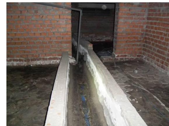
F-53. Bajo andén 1. Canaleta transversal limpia y operativa.
