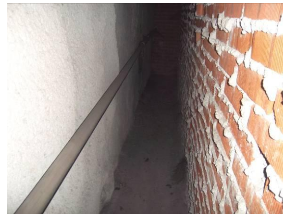
F-19. Camara bufa nivel vestíbulo. Pantalla frontal en zona tras cuartos. Seca.
