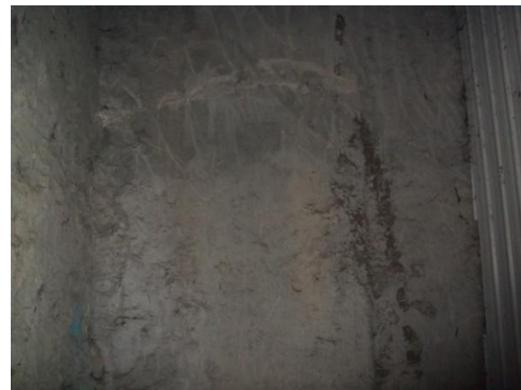
F-24. Nivel vestíbulo. Pantalla perimetral en pozo de inmisión lado derecho.
