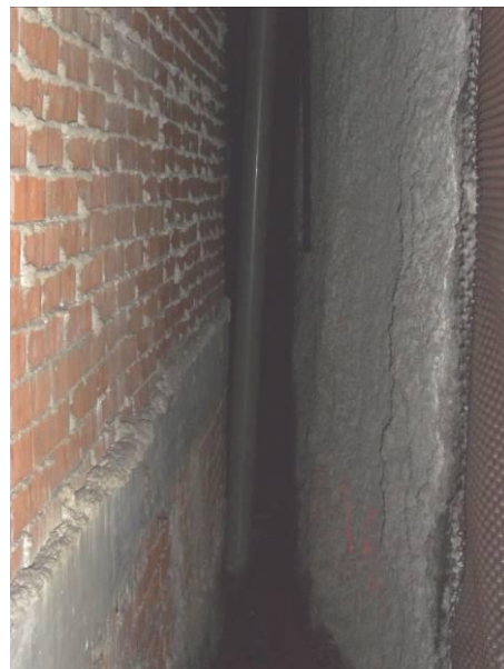
F-36. Cámara bufa andén 1. Aspecto cámara hacia P.K. crecientes.
