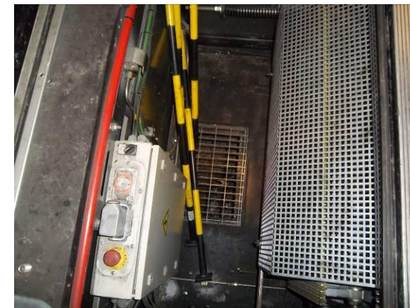
F-29. Foso escalera mecánica nº 6. Seco.
