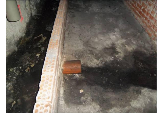
F-47. Cámara bufa andén 2. Drenaje de canaleta a bajo andén (zona ancha estación).
