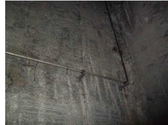
F-62. Pozo de inmisión andén 2. Aspecto de pantalla frontal.
