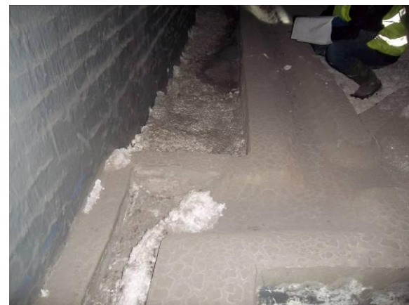
F-64. Bajo andén 1. Canaleta longitudinal, en perfecto estado.
