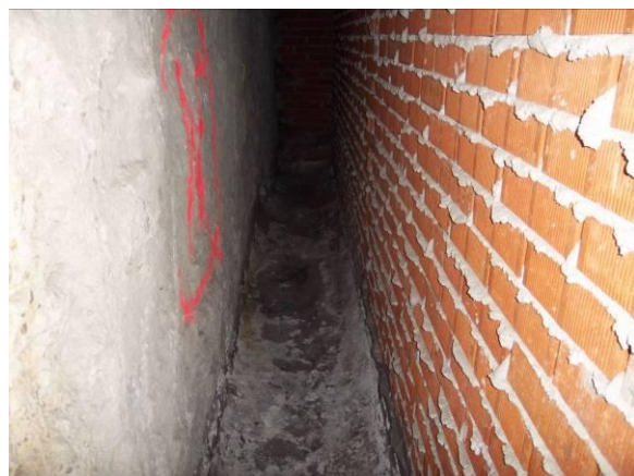
F-25. Nivel vestíbulo. Cámara bufa tras zona de cuartos en pantalla frontal, seca y limpia.
