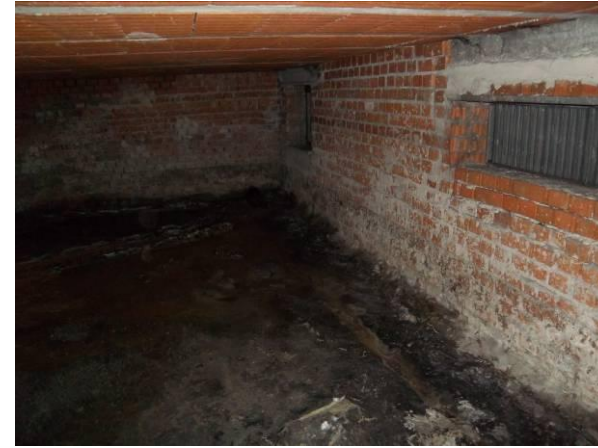
F-64. Bajo andén 2. Final de bajo andén previo a salida de emergencia.
