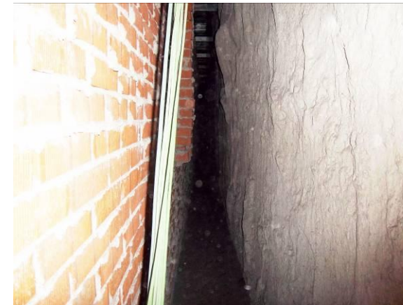
F-17. Camara bufa nivel vestíbulo. Pantalla izquierda en zona tras cuartos. Seca.
