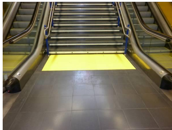
F-4. Acceso. Escaleras de acceso (esc. mecánicas nº 1 y nº 2) a nivel vestíbulo.
