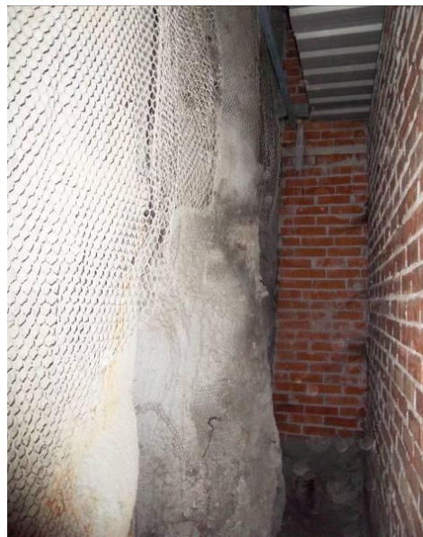
F-21. Cámara bufa tras cuartos en pantalla frontal.
