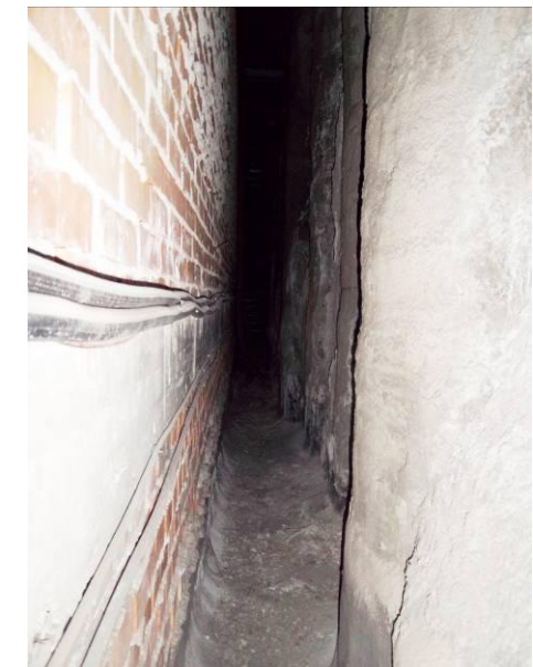
F-34. Cámara bufa nivel andén 2. Seca (zona tras cuartos).
