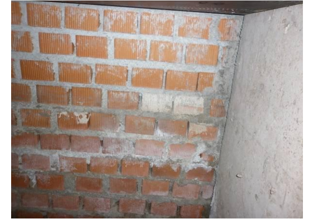
F-24. Interior foso escalera mecánica nº 3.
