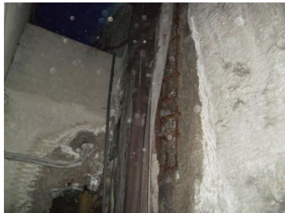
F-80. Pozo compensación andén 1. Pantalla frontal final en entronque con túnel.
