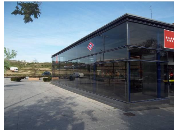
F-2. Templete exterior. Vista lateral.
