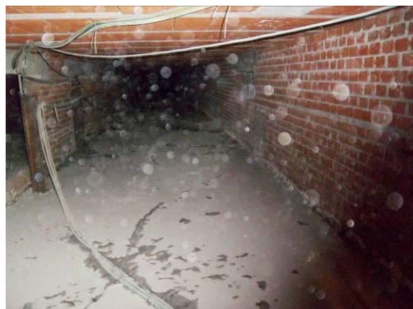
F-70. Bajo andén 1. Mortero poco alterado. Final de bajo andén, junto a pozos.
