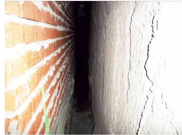
F-20. Cámara bufa nivel vestíbulo en pantalla derecha, tras cuartos.
