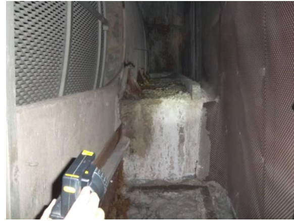
F-81 Pozo de extracción. Vista del lado derecho del pozo hacia P.K. crecientes.
