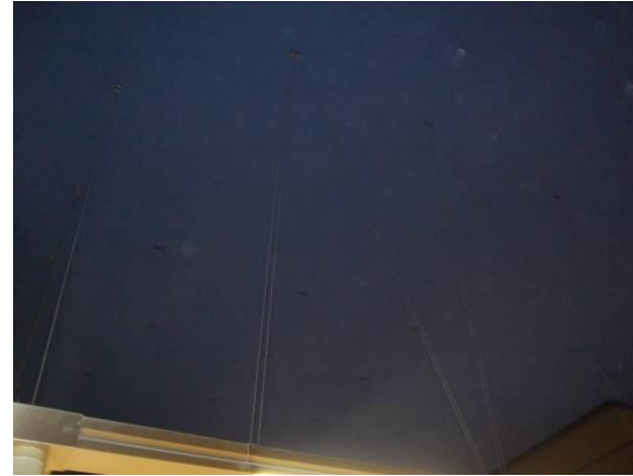
F-12. Nivel vestíbulo. Aspecto de losa de cubierta en zona abierta al público.
