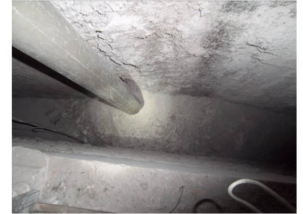
F-61. Cámara bufa tras andén 2. Relleno base tras cuarto de comunicaciones.
