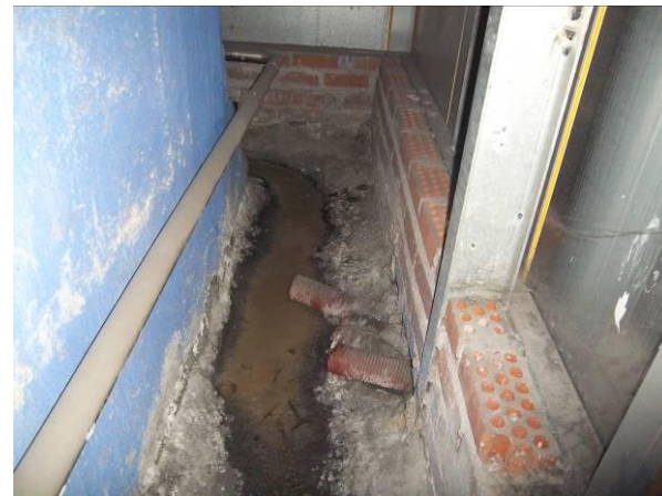
F-26 Nivel vestíbulo. Pantalla frontal final. Cámara bufa junto acceso.
