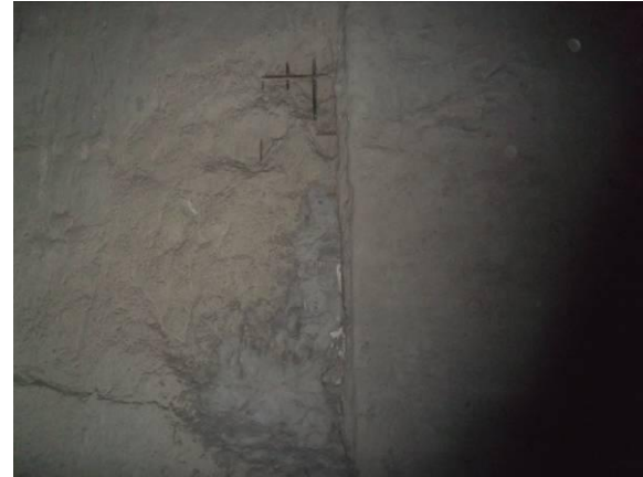
F-34. Nivel vestíbulo (pantalla derecha). Coquera (a 8.7 m del inicio de zona estrecha).
