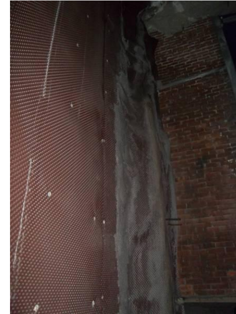
F-76 Pozo de extracción. Muro lateral derecho recubierto por lámina drenante.
