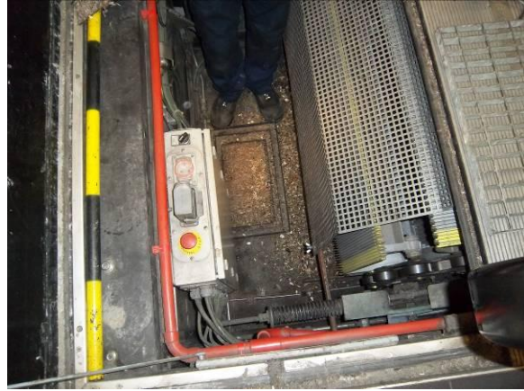
F-11. Escaleras acceso. Foso escalera mecánica nº 1. Seco.
