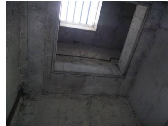
F-67. Pozo de inmisión andén 1. Aspecto general, seco.
