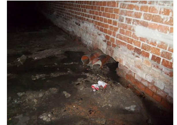
F-87. Bajo andén 2. Zona estrecha, Tubos procedentes de cámara bufa.
