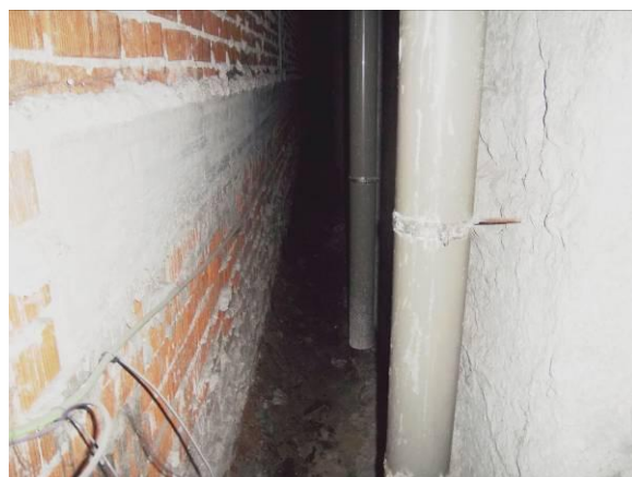
F-70. Cámara bufa andén 2. Aspecto tras sala de ventilación.
