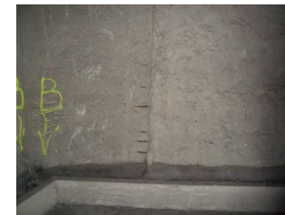
F-31. Nivel vestíbulo (pantalla derecha). Coquera (a 3 m del final de zona ancha).
