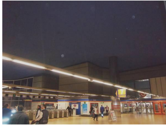
F-21. Losa de cubierta. Vista desde vestíbulo abierto al público.
