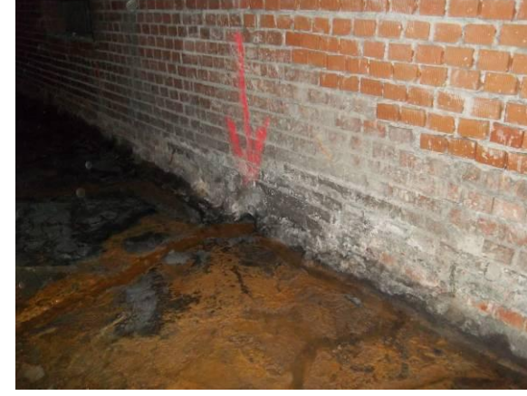
F-61. Bajo andén 2. Desagüe hacia drenaje central al inicio de zona estecha de estación.
