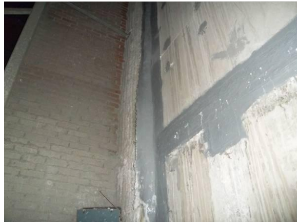
F-82 Pozo de extracción. Muro lateral izquierdo, junta con pantalla de estación.
