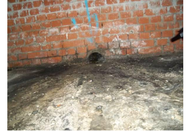
F-60. Bajo andén 2. Tubo de desagüe hacia drenaje central, semicolmatado.
