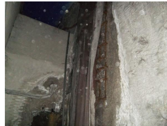
F-51. Pozo compensación andén 1. Pantalla frontal final en entronque con túnel.
