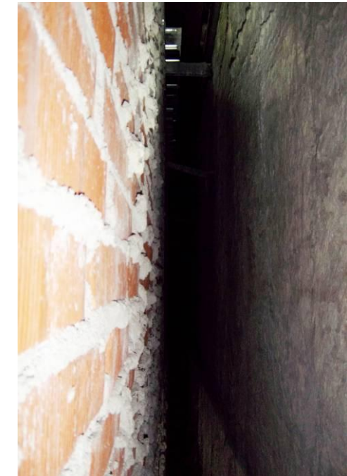
F-44. Aspecto cámara bufa nivel andén 1 en zona tras cuartos.
