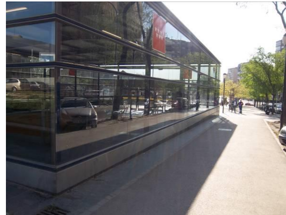
F-2. Acceso. Vista exterior del templete de acceso (lateral).
