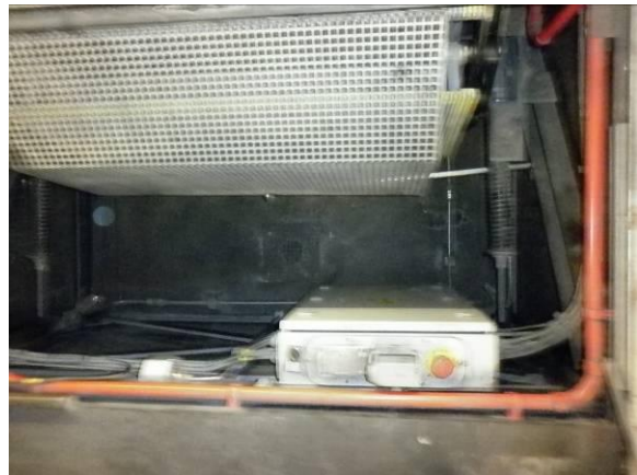
F-29. Nivel intermedio. Foso escalera mecánica nº 3, seco.
