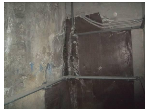
F-64. Pozo compensación andén 2. Pantalla frontal final en entronque con túnel.
