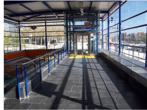
F-2. Vista del templete de acceso (interior).
