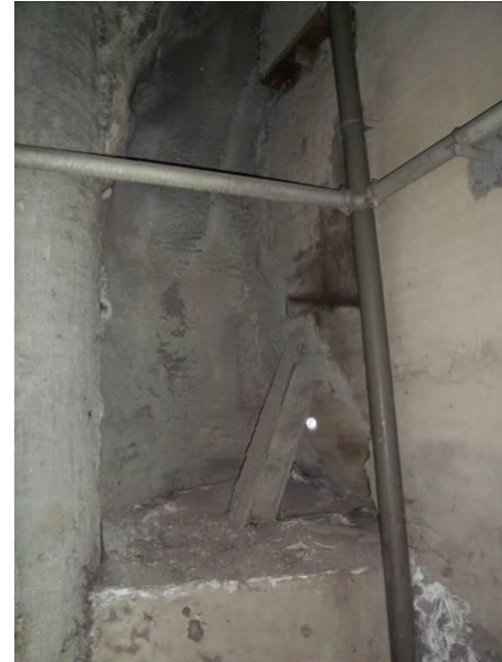
F-69. Pozo compensación (derecho), nivel bajo andén 1. Huevo en junta pantalla-túnel.
