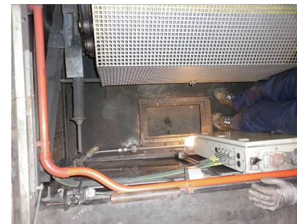
F-27. Foso escalera mecánica nº 5. Seco.
