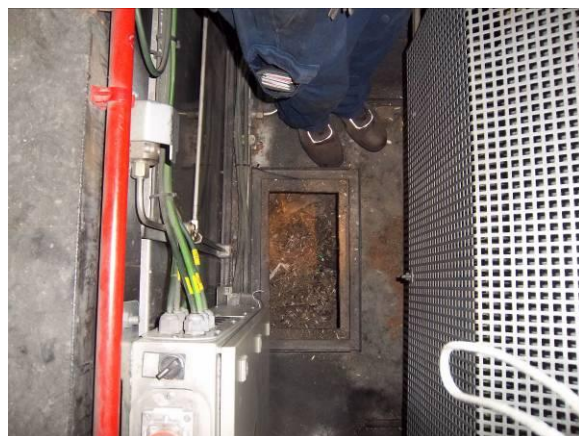
F-5. Foso escalera mecánica nº 2. Seco.
