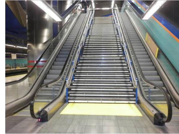
F-32. Nivel andén. Escaleras nivel intermedio-andén 1 (esc. mec. nº 5 y nº 6).
