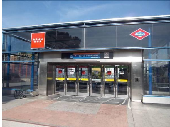
F-1. Vista del templete de acceso (exterior).
