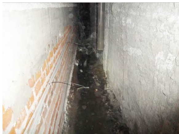
F-47. Cámara bufa tras andén 1. Zona ancha estación tras cuartos. Aspecto cámara bufa.
