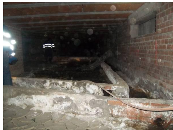
F-47. Bajo andén 2. Aspecto en zona central estación. Canaletas de fábrica.
