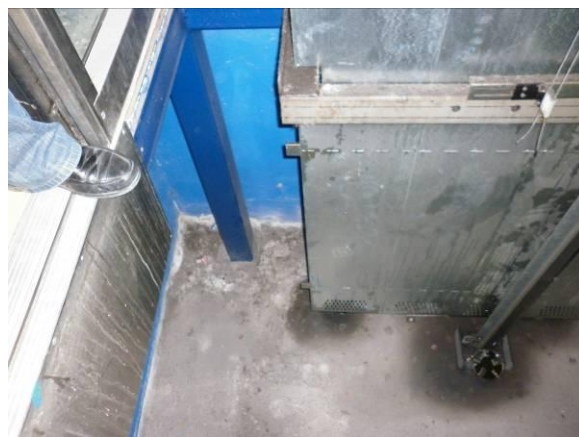
F-37. Ascensor vestíbulo-andén 1. Aspecto del foso, seco.
