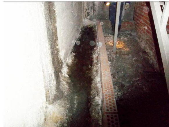
F-46 Cámara bufa tras andén 1. Zona ancha estación tras escaleras. Aspecto canaleta.
