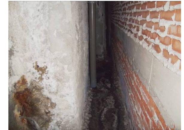
F-75. Cámara bufa andén 2. Aspecto al final de zona ancha de la estación.
