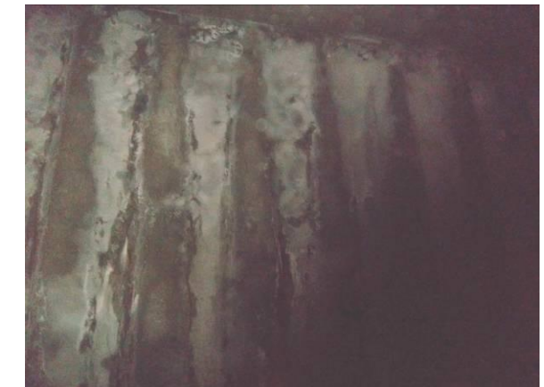
F-18. Pantalla pilotes nivel vestíbulo. Pantalla lateral derecha.
