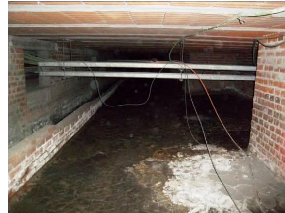
F-51. Bajo andén 1. Aspecto general. Húmedo y localmente encharcado, con barro.
