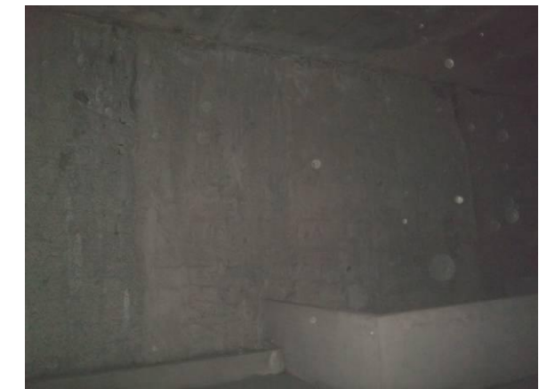
F-26. Nivel vestíbulo. Pozo compensación final estación. Pantalla transversal final.
