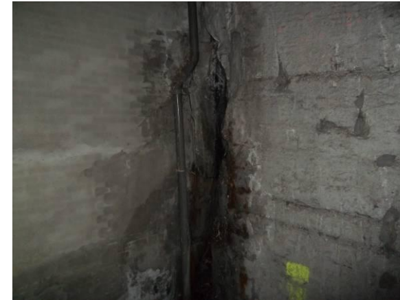
F-60. Pozo de compensación andén 2. Entronque pantallas frontal y túnel.
