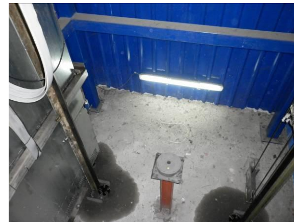
F-9 Acceso. Foso ascensor acceso. Seco y sin sales.
