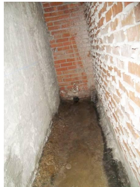
F-89. Salida emergencia andén 1. Cámara bufa a nivel de 7º rellano.
