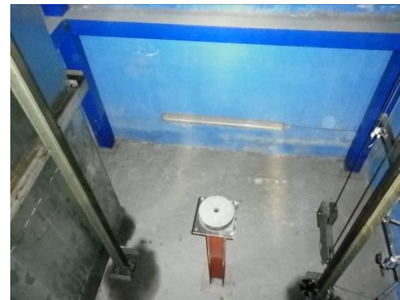
F-30. Foso de ascensor vestíbulo-andén 1. Seco.
