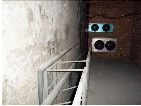
F-47. Aspecto cámara bufa nivel andén 2. tras caja de ascensor
