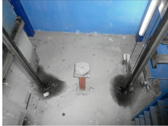
F-38. Nivel andén. Foso ascensor vestíbulo-andén 1. Seco y sin sales.
