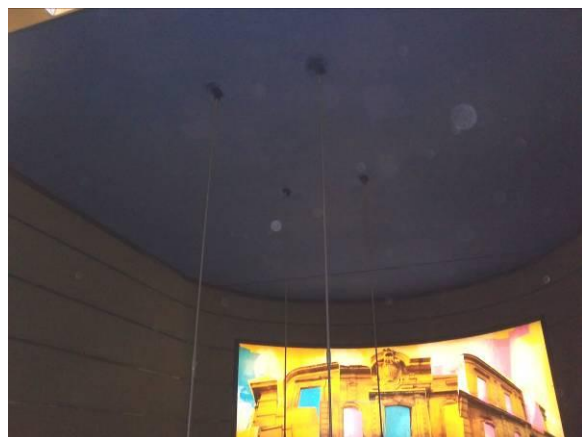
F-31. Nivel intermedio. Tirantes de sujeción de escalera central Vestíbulo-N. intermedio.
