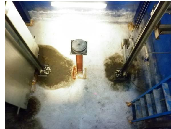
F-35. Foso ascensor vestíbulo-andén 2. Seco.
