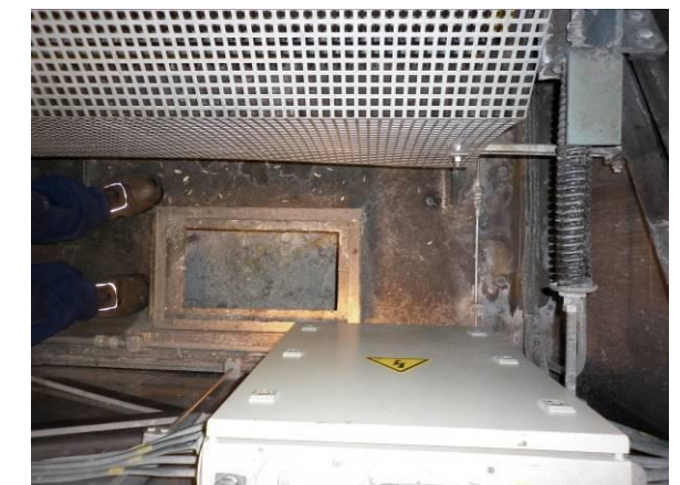
F-37. Nivel andén. Foso escalera mecánica nº 8, seco y con algunas sales.
