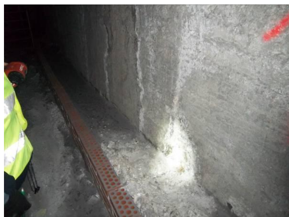
F-58. Cámara bufa tras andén 2. Zona ancha tras escaleras. Aspecto canaleta.
