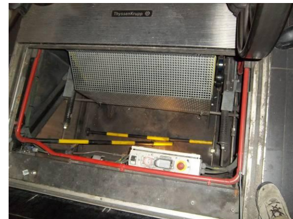
F-40. Nivel intermedio. Foso escalera mecánica nº 5. Seco.
