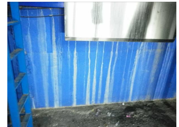
F-10. Acceso. Foso ascensor acceso. Paramento bajo puerta de entrada.
