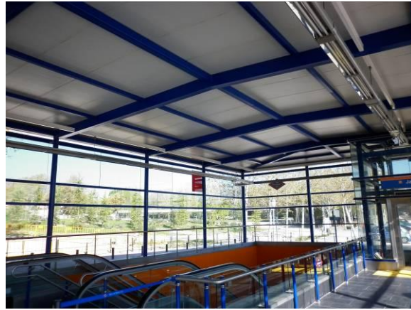
F-1. Vista del templete de acceso (interior).
