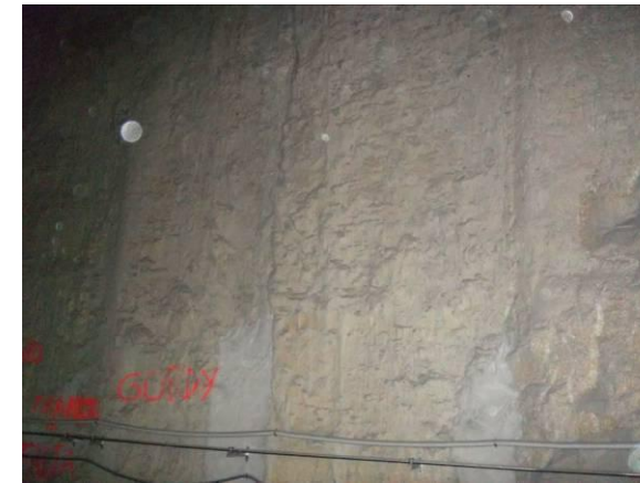
F-23. Nivel vestíbulo. Pantalla lateral izquierda en zona ancha estación.
