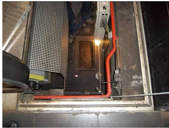
F-13. Escaleras acceso. Foso escalera mecánica nº 3. Seco.
