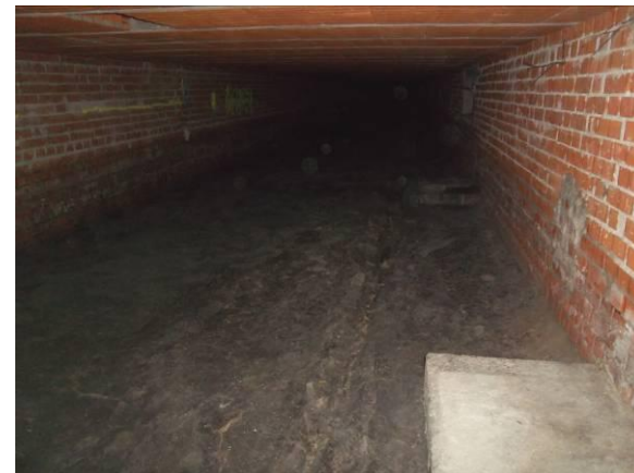
F-83. Bajo andén 1. Zona estrecha de estación previa a salida de emergencia.
