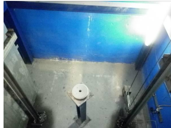
F-36. Ascensor vestíbulo-andén 1. Aspecto del foso, seco.
