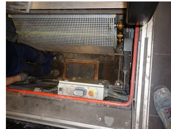
F-25. Foso escalera mecánica nº 4. Seco.
