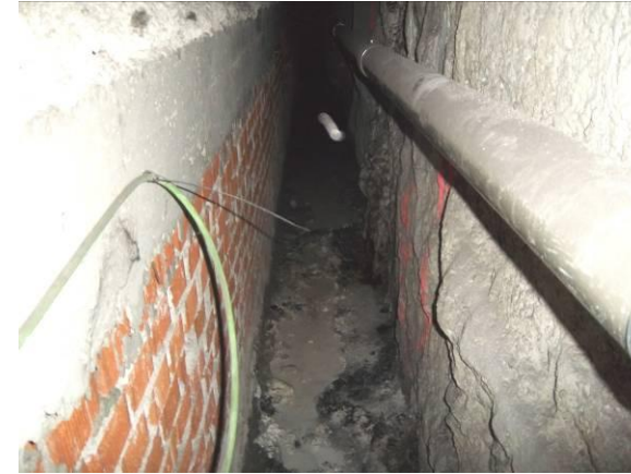
F-46. Cámara bufa andén 2. Aspecto hacia P.K. decrecientes (tras sala ventilación).
