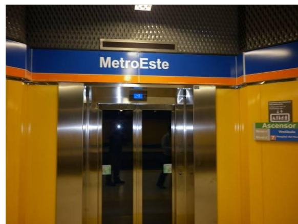
F-31. Ascensor vestíbulo-andén 2.
