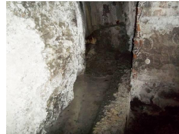
F-45. Nivel andén. Pozo de inmisión, canaleta a pie de pantalla colmatada e inundada.
