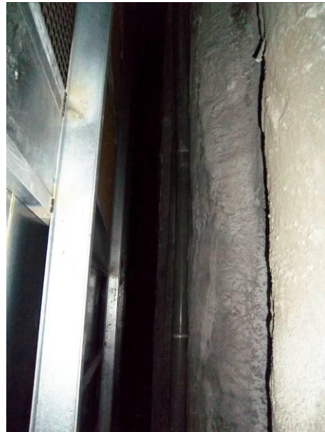
F-45. Cámara bufa andén 1. Zona estrecha estación. Vista hacia salida de emergencia.
