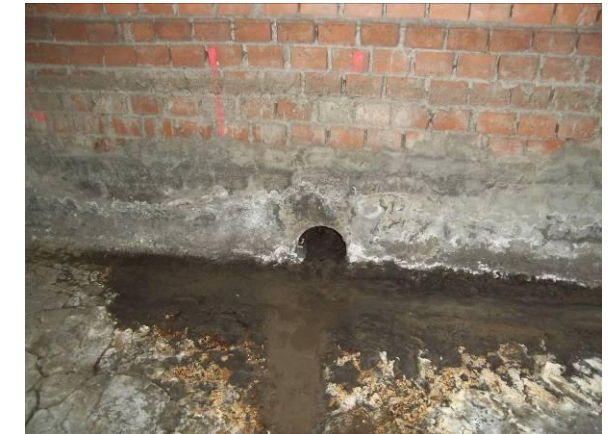
F-50. Bajo andén 2. Desagüe hacia drenaje central de la estación operativo.
