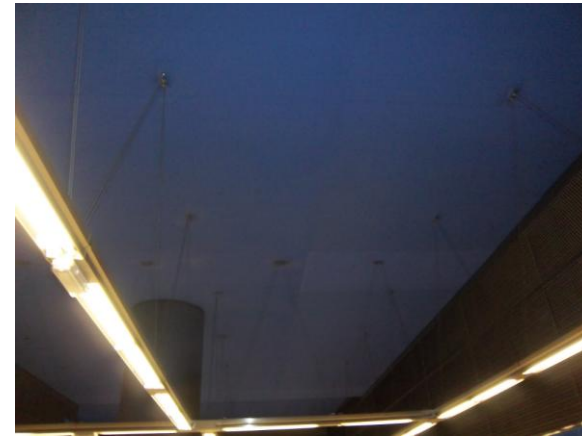
F-12. Losa de cubierta. Vista desde zona pública de vestíbulo.
