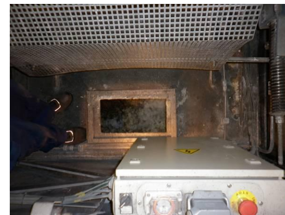
F-36. Nivel andén. Foso escalera mecánica nº 7, seco y con algunas sales.
