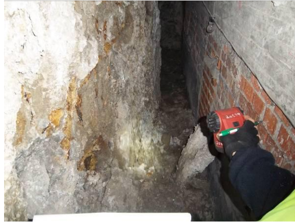
F-48. Nivel andén. Pantalla derecha (andén 1). Coquera en pantalla.
