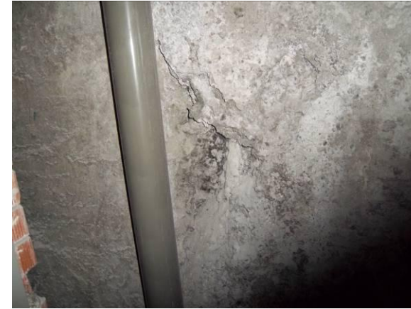
F-60. Cámara bufa tras andén 2. Coquera tras cuarto de comunicaciones.
