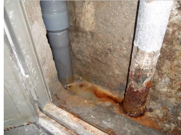
F-82. Salida de emergencia andén 1. Aspecto cámara bufa en rellano 1º.
