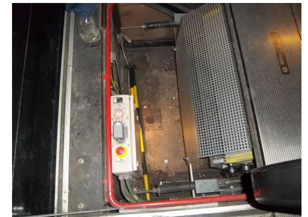
F-41. Nivel intermedio. Foso escalera mecánica nº 6. Seco.
