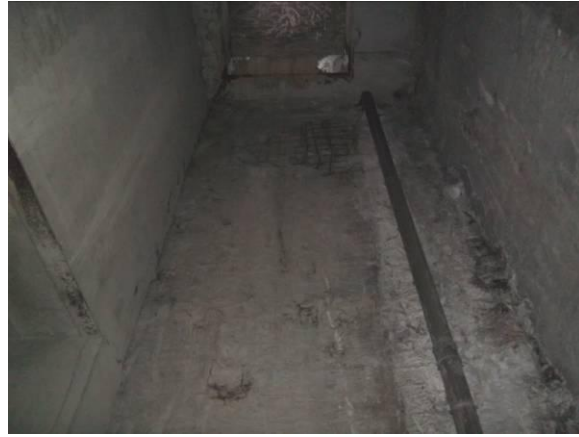
F-90. Pozo inmisión andén 1. Inicio estación. Coquera bajo estampidor vestíbulo.
