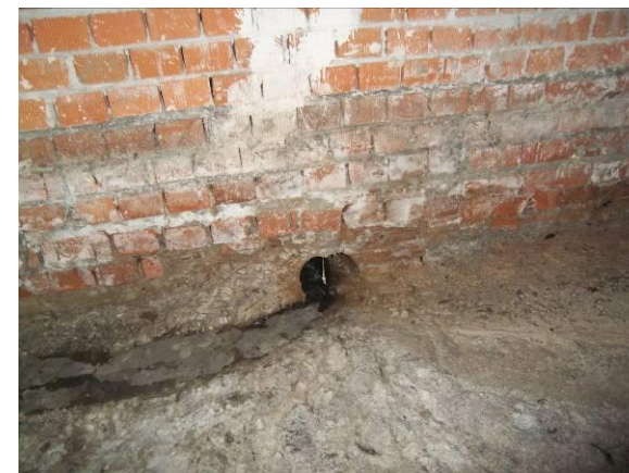
F-88. Bajo andén 2. Zona estrecha de la estación. Vista desagüe P.K. 4+461.15.
