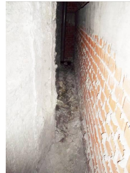
F-41. Cámara bufa tras andén 1. Zona ancha estación. Cámara bufa delante de pantalla transversal.
