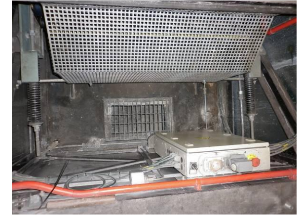
F-33. Nivel andén. Foso escalera mecánica nº 5, seco y con algunas sales.
