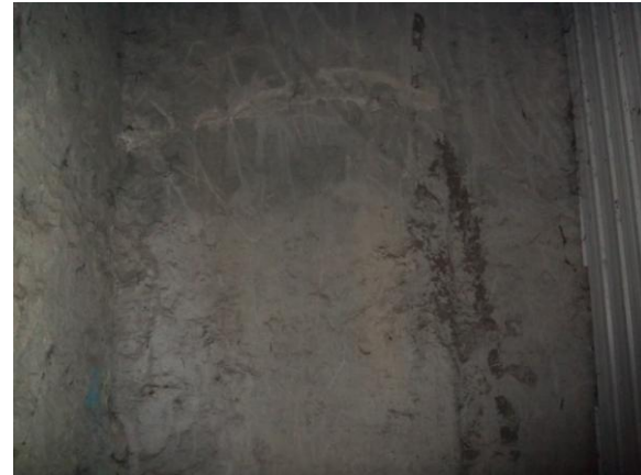
F-34. Nivel vestíbulo (pantalla derecha). Coquera (a 8.7 m del inicio de zona estrecha).
