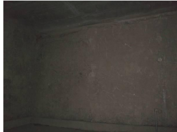
F-19. Nivel vestíbulo. Pozo compensación final estación. Pantalla lateral derecha.
