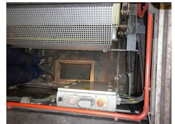
F-28. Foso escalera mecánica nº 6. Seco.
