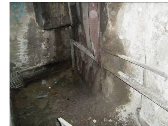
F-53. Pozo compensación andén 1. Pantalla frontal final en entronque con túnel.
