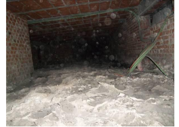
F-67. Bajo andén 2. Mortero alterado y roto. Zona ancha frente cuarto bombeo fecales.
