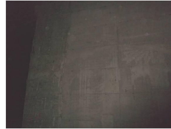
F-19. Nivel vestíbulo. Pantalla lateral izquierda. Aspecto de muro cierre de rampa.
