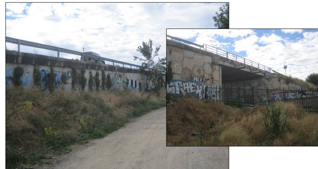
Figuras nº 37 y nº 38. Muro de tierra armada en terraplén lado Guadarrama de la estructura del P.K. 2+300 de la M-510. (Fuente: Elaboración propia. Junio de 2013).
