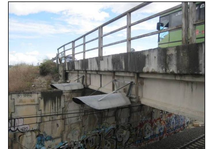
VIGA DE BORDE EN LA ESTRUCTURA (8)
