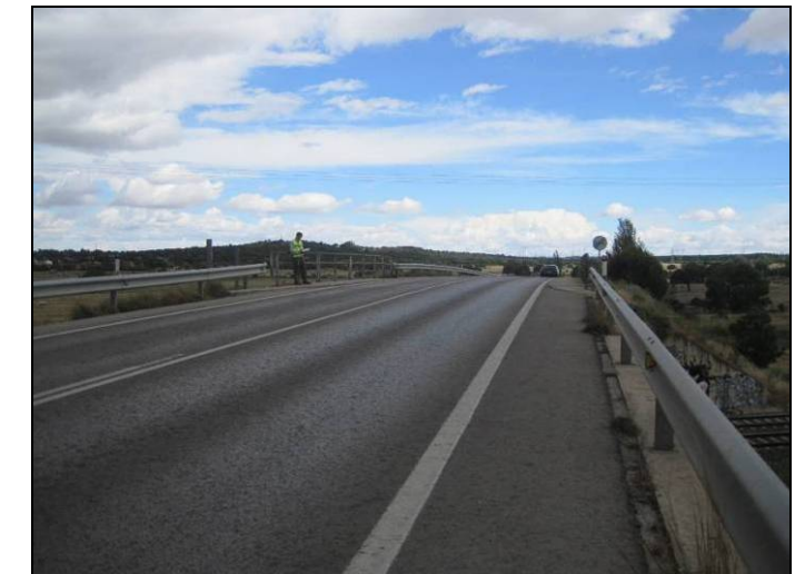
CALZADA EN LA ESTRUCTURA (7)
