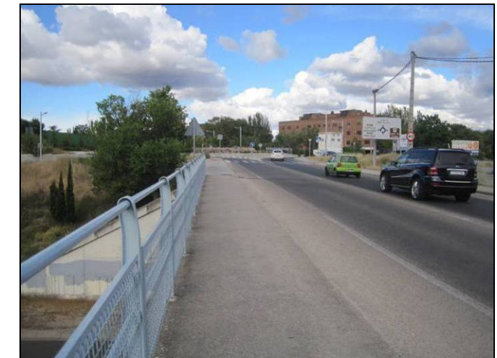
ACERADO Y BARANDILLA EN LATERAL IZQUIERDO (8)
