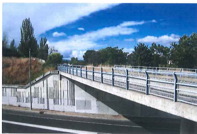
VISTA GENERAL DE LA ESTRUCTURA
