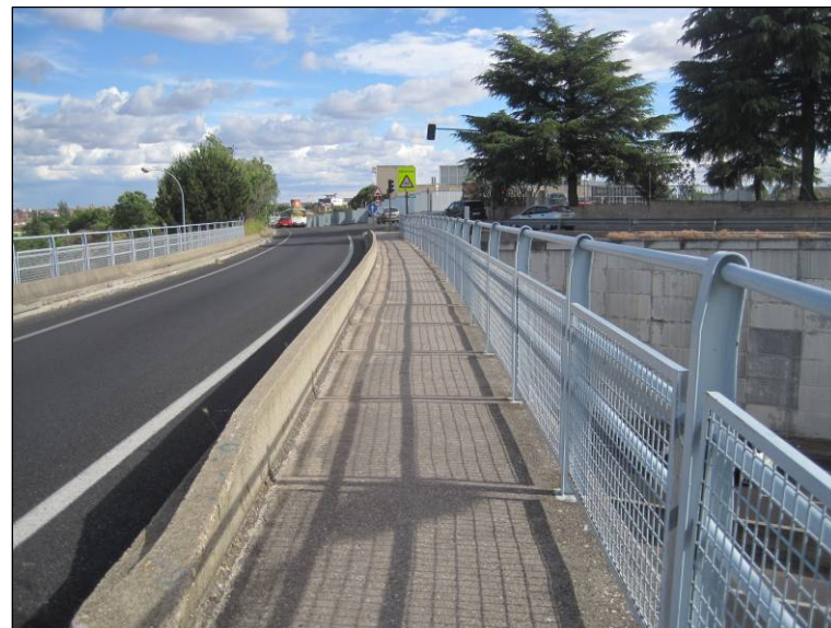
Figura nº 16. Vista de la calzada del paso superior de la M-508 P.K. 3+000. (Fuente: Elaboración propia. Junio de 2013).
