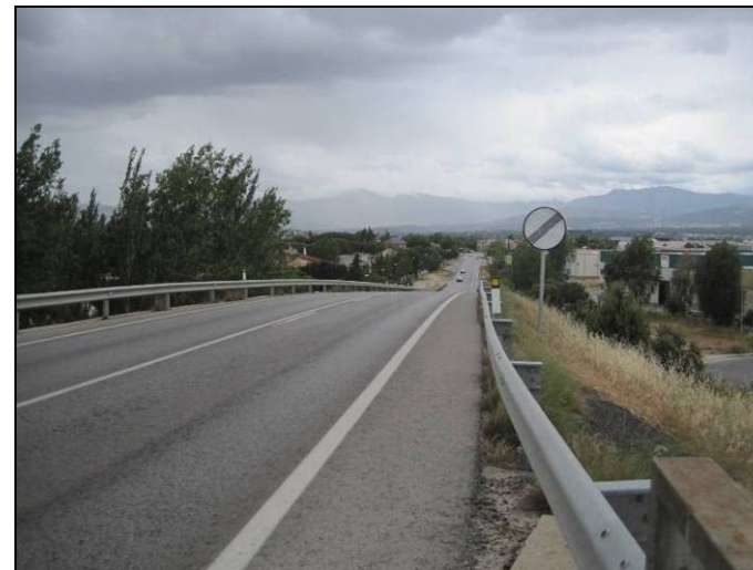
ACCESO A LA ESTRUCTURA, SENTIDO A-6 (5)
