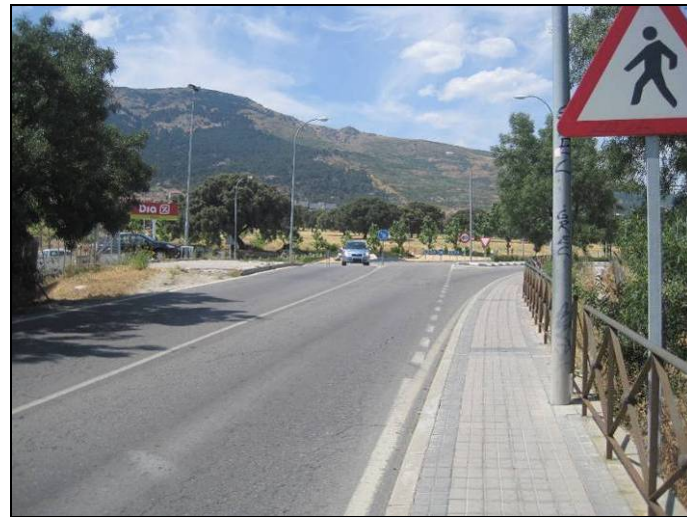
ACCESO A LA ESTRUCTURA, SENTIDO A-6 (1)
