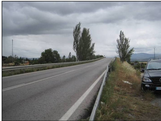
ACCESO A LA ESTRUCTURA, SENTIDO A-6 (1)
