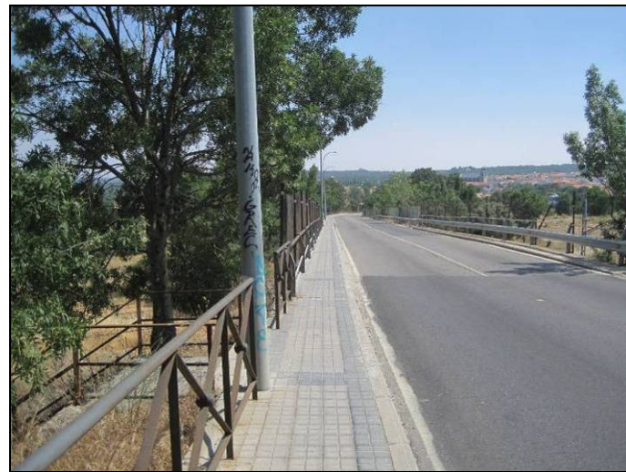
CALZADA EN ESTRUCTURA, SENTIDO GALAPAGAR (2)
