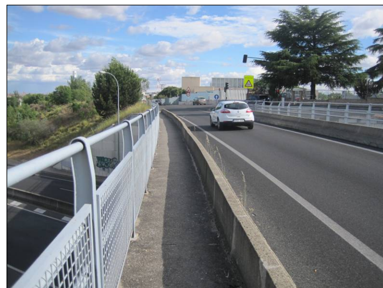
Figura nº 20. Sistemas de contención en estructura de la M-508 (P.K. 3+000). (Fuente: Elaboración propia. Junio de 2013).
