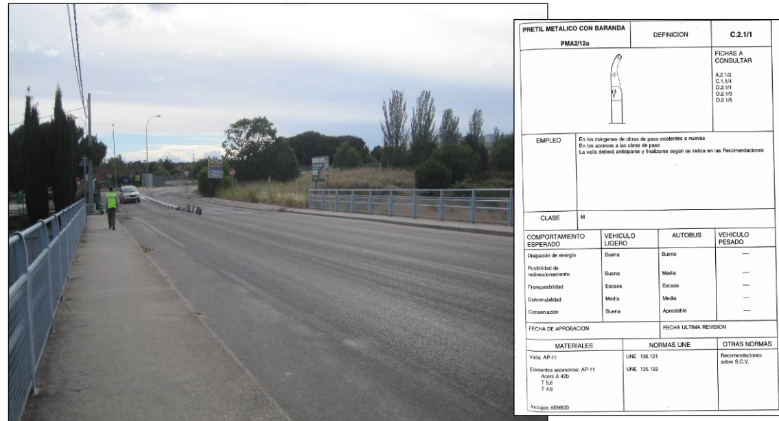
Figuras nº 2 y nº 3. Pretiles metálicos en estructura de la Avda. de Rodajos y ficha de PMA2/12a. (Fuente: Elaboración propia y Orden Circular 321/95. Junio de 2013).
