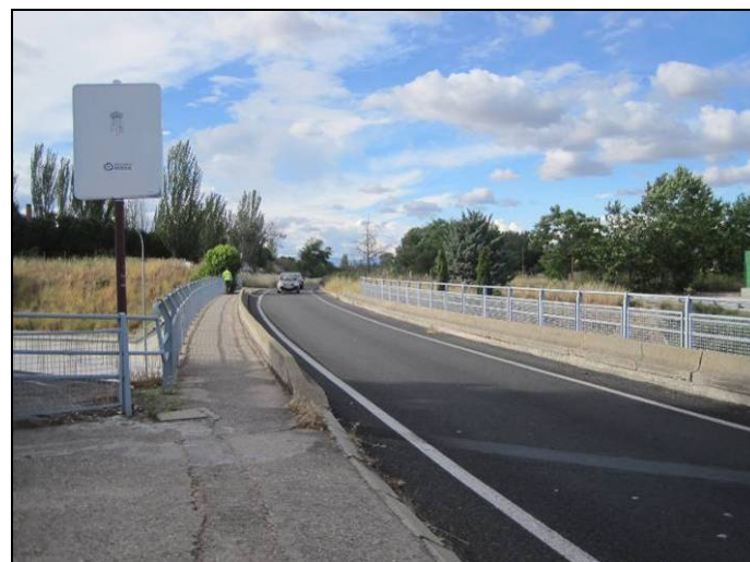
VISTA GENERAL DEL PUENTE, SENTIDO HÚMERA (3)
