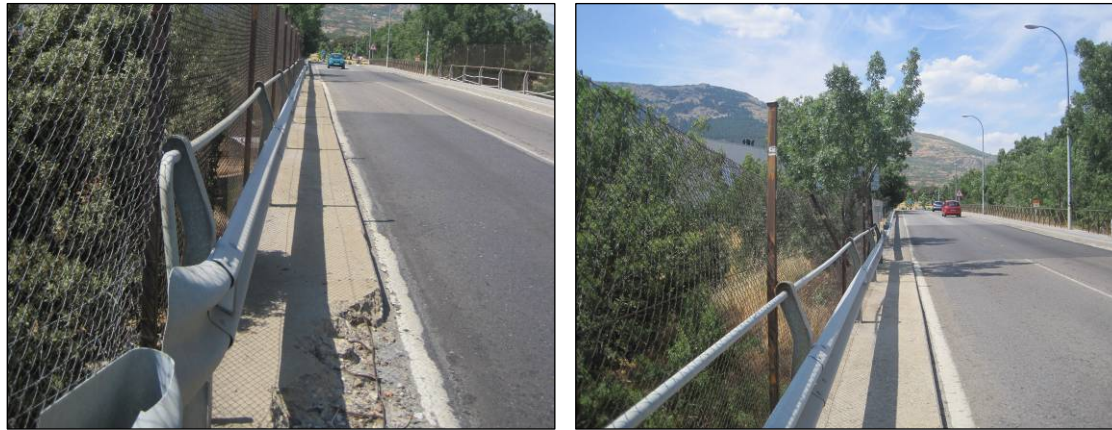
Figuras nº 28 y nº 29. Vistas de la margen derecha de la estructura de la M-600 en el P.K. 8+000 sobre el FF.CC. (Fuente: Elaboración propia. Julio de 2013).
