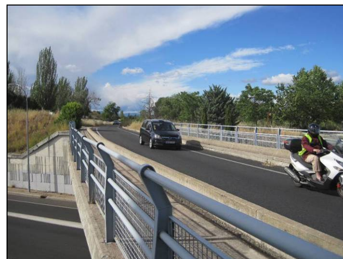
VISTA LATERAL DERECHO DEL TABLERO (6)
