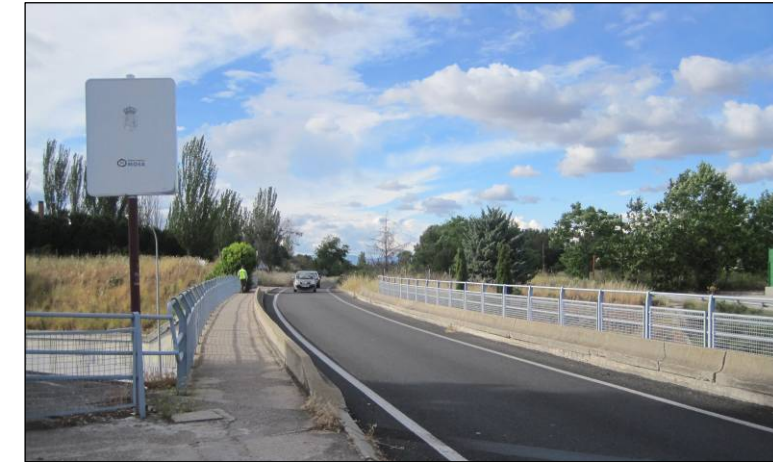
Figura nº 13. Sistemas de contención en estructura de la M-508 (P.K. 3+000). (Fuente: Elaboración propia. Junio de 2013).
