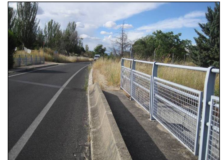
ACCESO A LA ESTRUCTURA DESDE HÚMERA (7)
