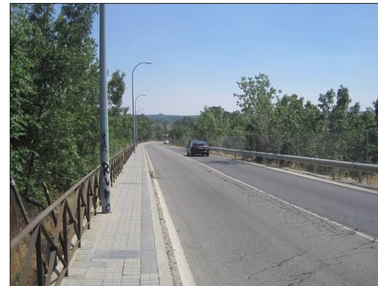
Figura nº 32. Zona posterior a la estructura del P.K. 8+000 de la M-600, sentido Madrid. (Fuente: Elaboración propia. Julio de 2013).
