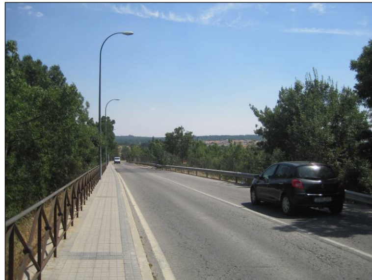
Figura nº 29. Zona previa a la estructura del P.K. 8+000 de la M-600, sentido Madrid. (Fuente: Elaboración propia. Julio de 2013).
