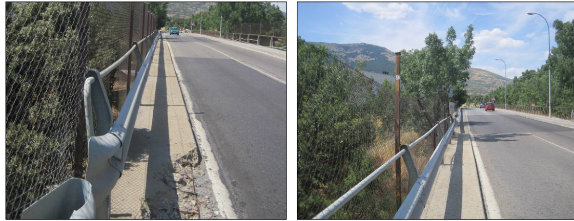
Figuras nº 46 y nº 47. Vistas de la margen derecha de la estructura de la M-600 en el P.K. 8+000 sobre el FF.CC. (Fuente: Elaboración propia. Julio de 2013).
