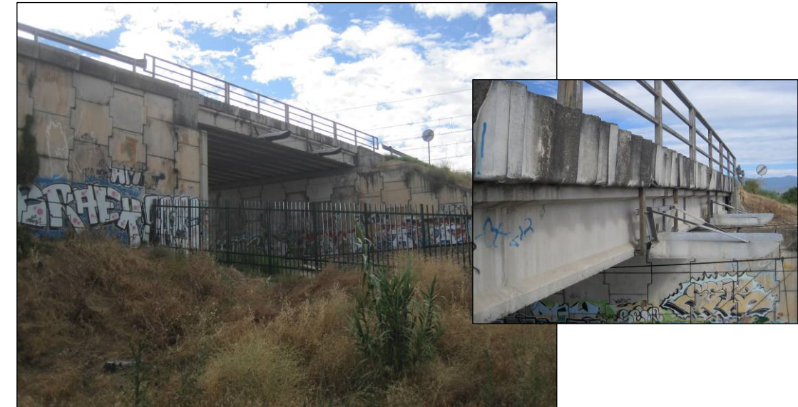
Figuras nº 27 y nº 28. Vista del tablero de la estructura de la M-510 P.K. 2+300. (Fuente: Elaboración propia. Julio de 2013).
