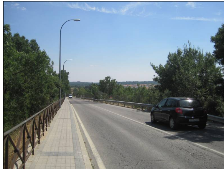
Figura nº 53. Zona previa a la estructura del P.K. 8+000 de la M-600, sentido Madrid. (Fuente: Elaboración propia. Julio de 2013).
