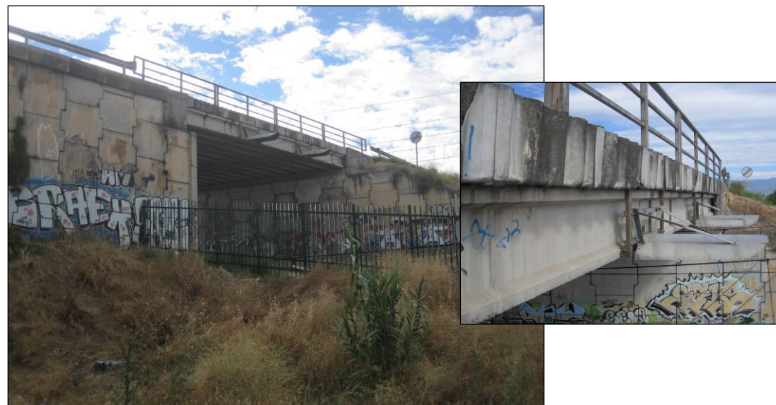
Figuras nº 17 y nº 18. Vista del tablero de la estructura de la M-510 P.K. 2+300. (Fuente: Elaboración propia. Julio de 2013).
