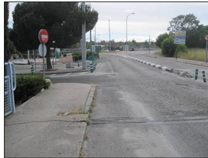
ACCESO A GASOLINERA (4)
