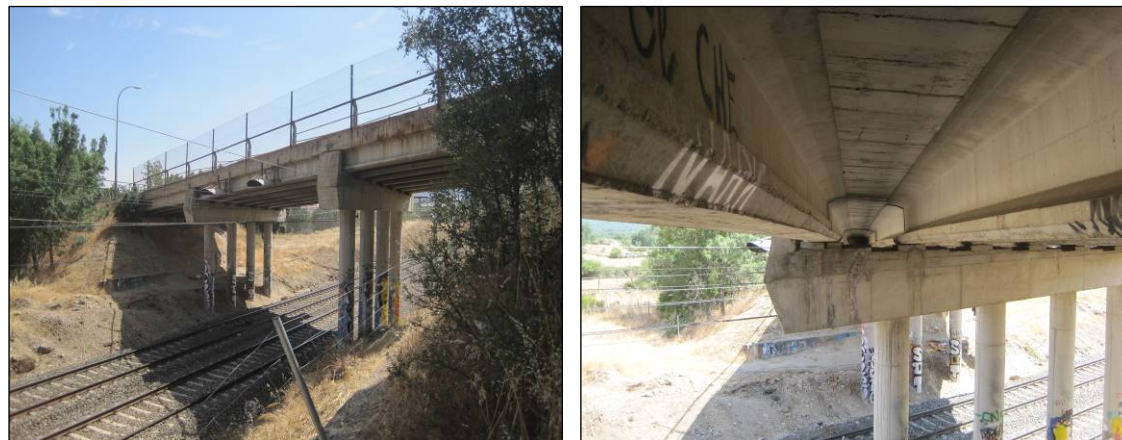
Figuras nº 40 y nº 41. Vistas del alzado y cara inferior de la estructura de la M-600 en el P.K. 8+000 sobre el FF.CC. (Fuente: Elaboración propia. Julio de 2013).
