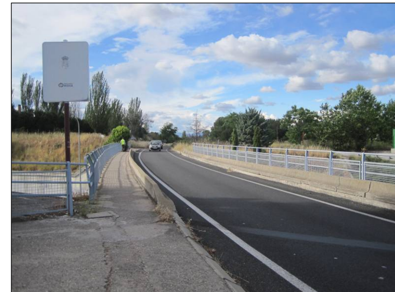
Figura nº 11. Sistemas de contención en estructura de la M-508 (P.K. 3+000). (Fuente: Elaboración propia. Junio de 2013).
