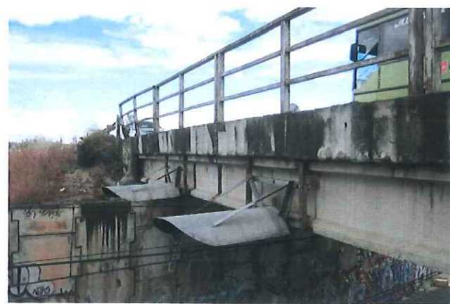
VISTA GENERAL DE LA ESTRUCTURA
