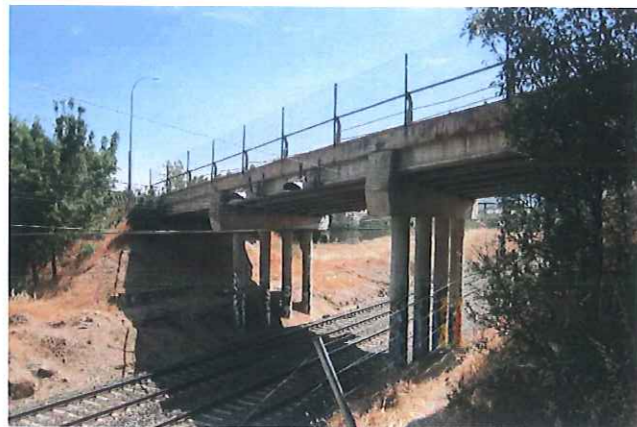
VISTA GENERAL DE LA ESTRUCTURA
