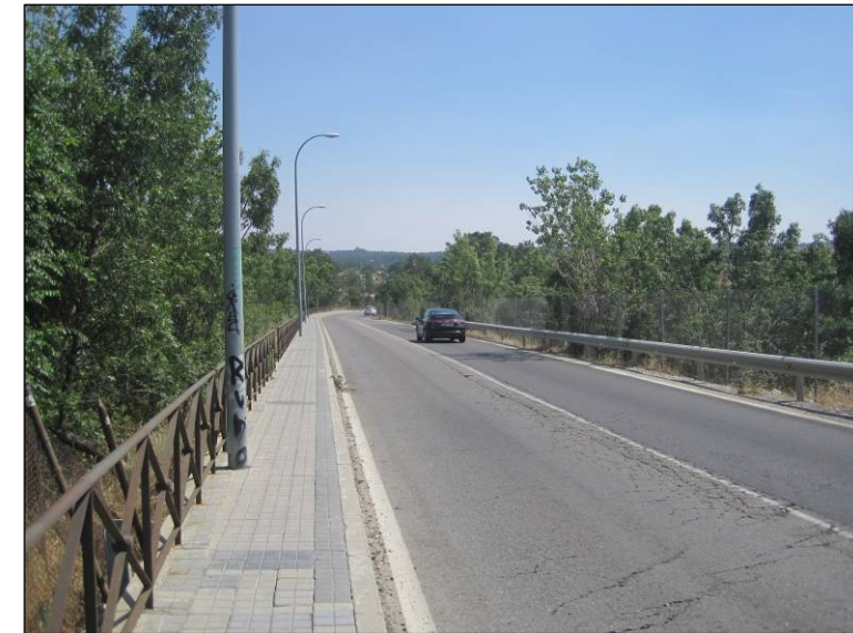
Figura nº 56. Zona posterior a la estructura del P.K. 8+000 de la M-600, sentido Madrid. (Fuente: Elaboración propia. Julio de 2013).
