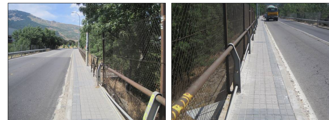
Figuras nº 44 y nº 45. Vistas de la margen izquierda de la estructura de la M-600 en el P.K. 8+000 sobre el FF.CC. (Fuente: Elaboración propia. Julio de 2013).
