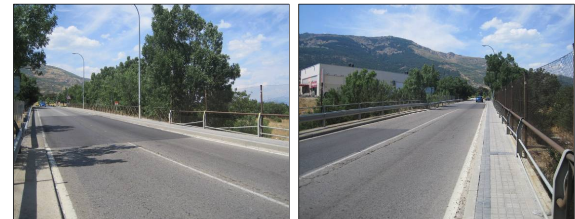
Figuras nº 25 y nº 26. Deterioros en los elementos de contención de la estructura del P.K. 8+000 de la M-600. (Fuente: Elaboración propia. Julio de 2013).
