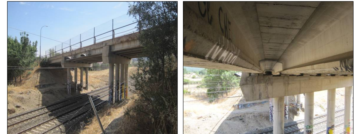
Figuras nº 24 y nº 25. Vistas del alzado y cara inferior de la estructura de la M-600 en el P.K. 8+000 sobre el FF.CC. (Fuente: Elaboración propia. Julio de 2013).
