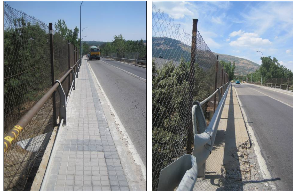
Figuras nº 27 y nº 28. Vistas de la valla antivandálica en bordes de la estructura del P.K. 8+000 de la M-600. (Fuente: Elaboración propia. Julio de 2013).
