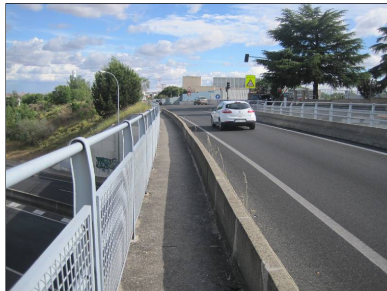
Figura nº 12. Sistemas de contención en estructura de la M-508 (P.K. 3+000). (Fuente: Elaboración propia. Junio de 2013).
