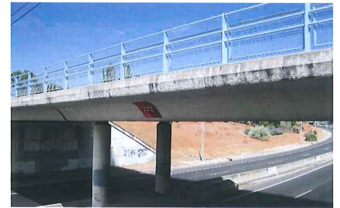
VISTA GENERAL DE LA ESTRUCTURA
