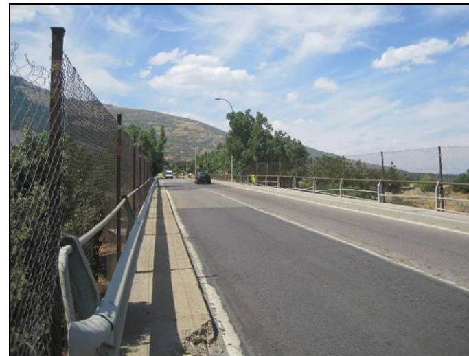
CALZADA EN ESTRUCTURA, SENTIDO A-6 (4)
