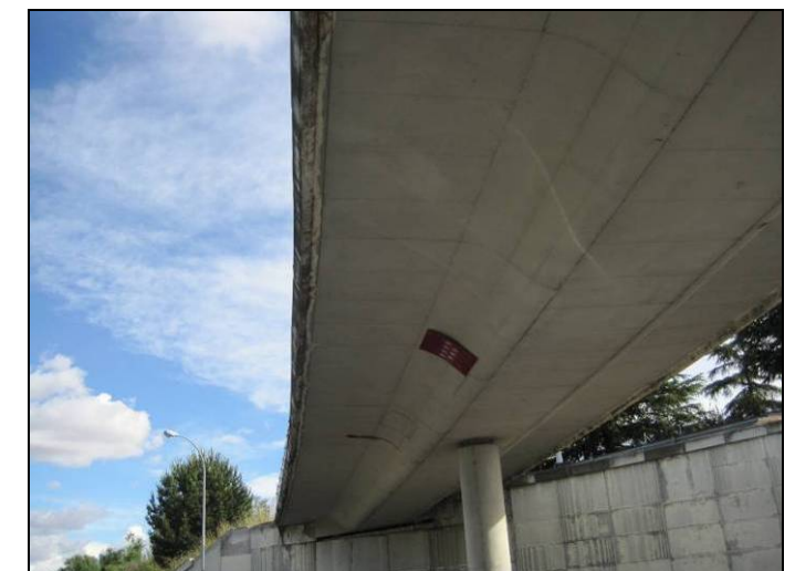
VISTA INFERIOR DEL TABLERO (9)
