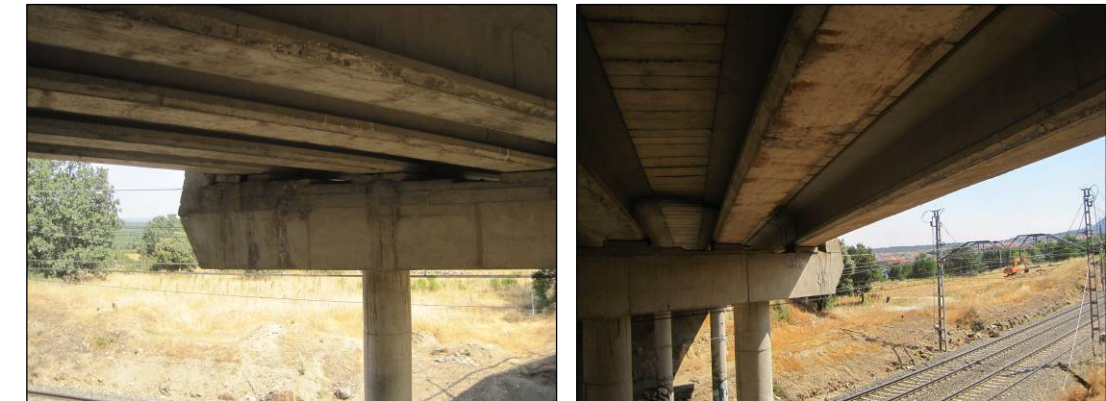
Figuras nº 42 y nº 43. Vistas del cargadero y apoyo de vigas del paso superior al ferrocarril de la M-600 en el P.K. 8+000 sobre el FF.CC. (Fuente: Elaboración propia. Julio de 2013).
