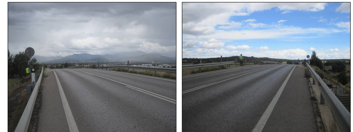
Figuras nº 29 y nº 30. Vista de la calzada de la estructura de la M-510 P.K. 2+300. (Fuente: Elaboración propia. Julio de 2013).
