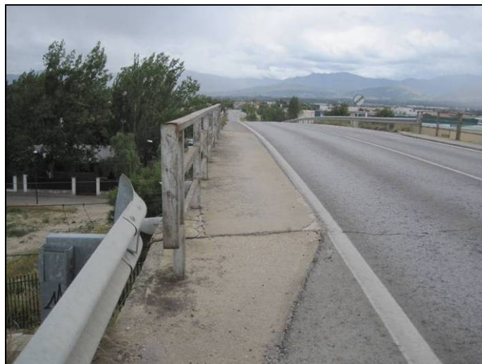
LATERAL DE LA ESTRUCTURA, SENTIDO A-6 (2)
