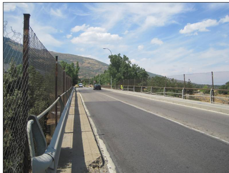
Figura nº 48. Sistemas de contención en estructura de la M-600 (P.K. 8+000). (Fuente: Elaboración propia. Julio de 2013).
