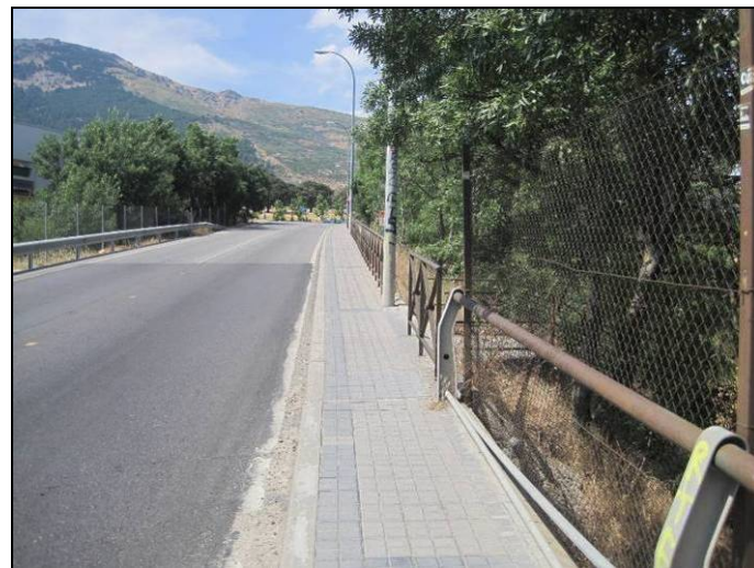
CALZADA EN ESTRUCTURA, SENTIDO A-6 (3)
