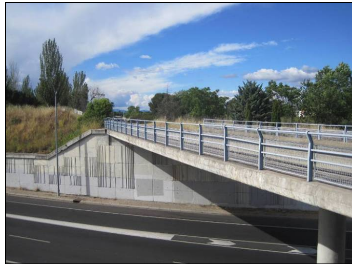
VISTA LATERAL DERECHO DEL TABLERO (1)
