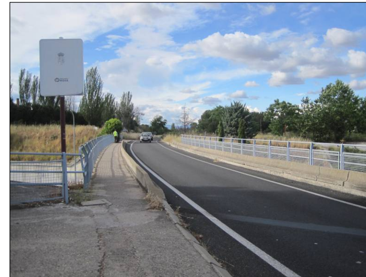
Figura nº 21. Sistemas de contención en estructura de la M-508 (P.K. 3+000). (Fuente: Elaboración propia. Junio de 2013).
