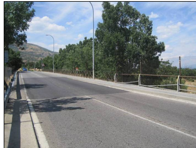
CALZADA EN ESTRUCTURA, SENTIDO A-6 (5)
