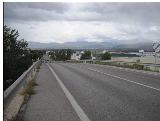
ACCESO A LA ESTRUCTURA, SENTIDO A-6 (6)
