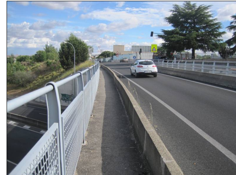
Figura nº 10. Sistemas de contención en estructura de la M-508 (P.K. 3+000). (Fuente: Elaboración propia. Junio de 2013).
