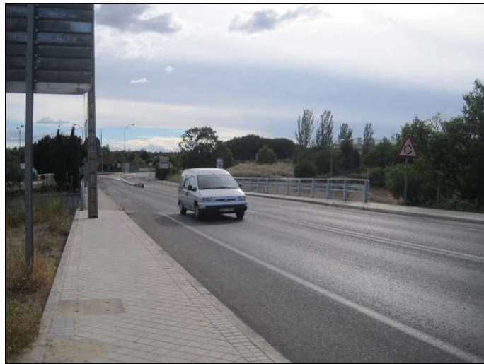
VISTA GENERAL SENTIDO GLORIETA SOMOSAGUAS (1)
