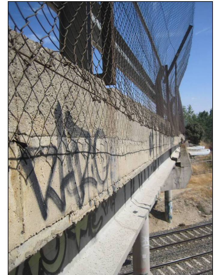
VIGA DE BORDE (8)
