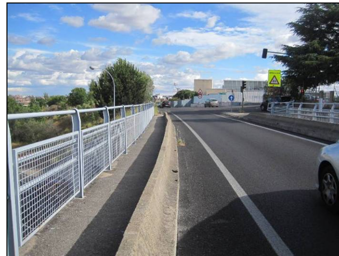
ACERADO, BARANDILLA Y BARRERA RÍGIDA EN LATERAL IZQUIERDO (4)
