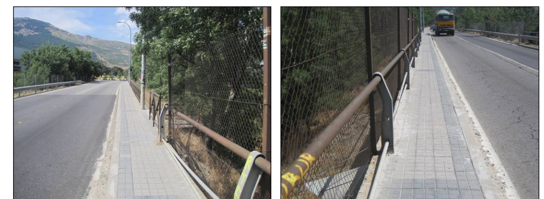
Figuras nº 26 y nº 27. Vistas de la margen izquierda de la estructura de la M-600 en el P.K. 8+000 sobre el FF.CC. (Fuente: Elaboración propia. Julio de 2013).
