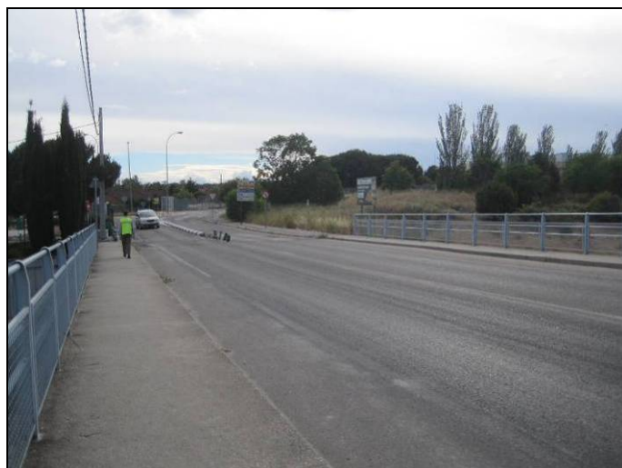
VISTA GENERAL SENTIDO GLORIETA SOMOSAGUAS (3)
