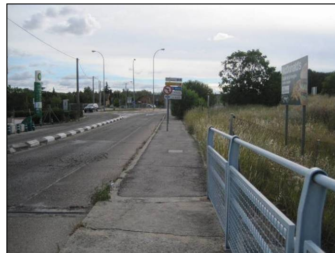
ACERADO Y BARANDILLA EN LATERAL DERECHO (6)
