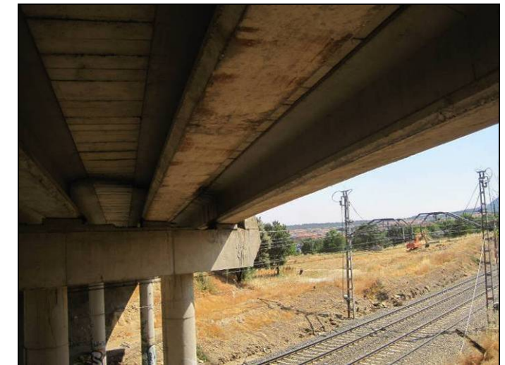
VISTA INFERIOR DEL TABLERO (7)
