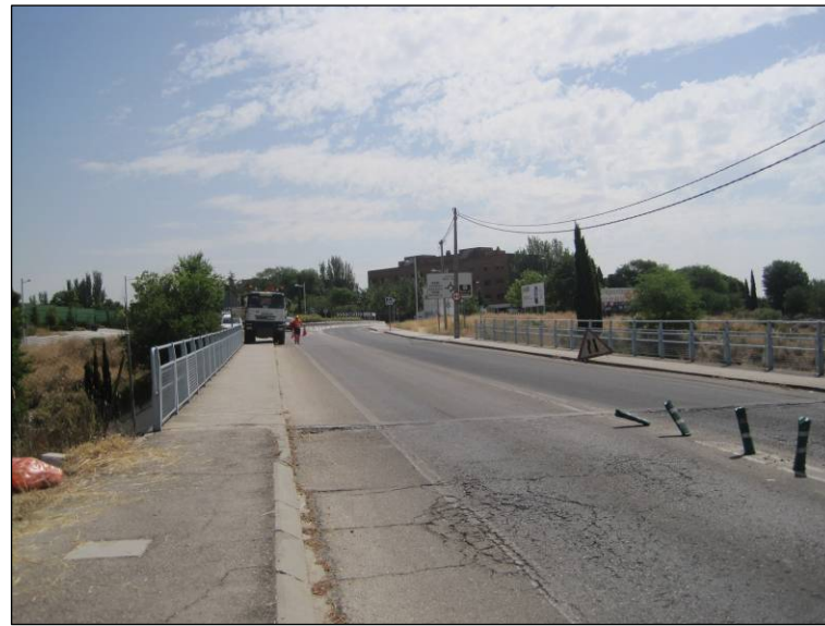
Figura nº 2. Vista de la calzada del paso superior de la Avda. de Rodajos. (Fuente: Elaboración propia. Julio de 2013).
