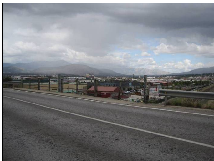
CALZADA EN LA ESTRUCTURA (3)
