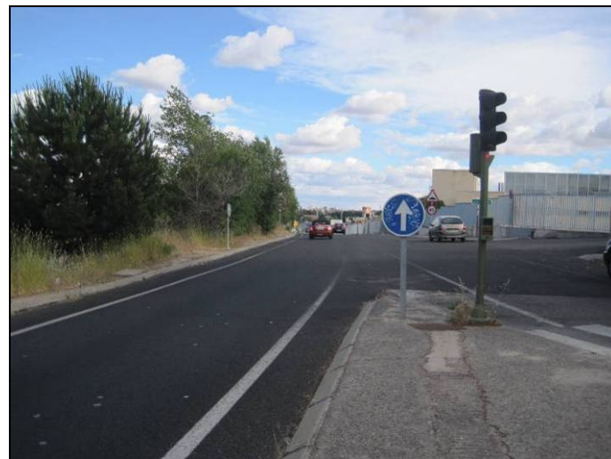
SALIDA DE LA ESTRUCTURA, SENTIDO CARABANCHEL (2)
