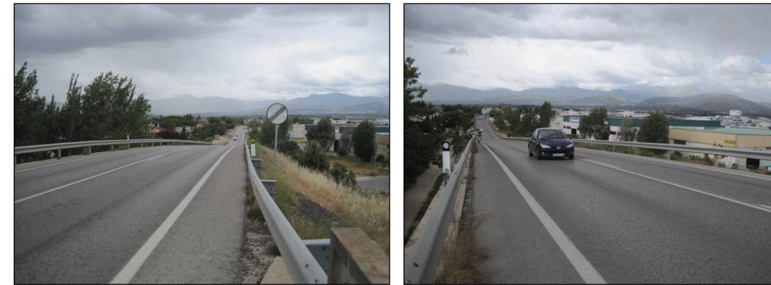
Figuras nº 35 y nº 36. Barreras metálicas de seguridad en el tramo posterior a la estructura del P.K. 2+300 de la M-510. (Fuente: Elaboración propia. Junio de 2013).
