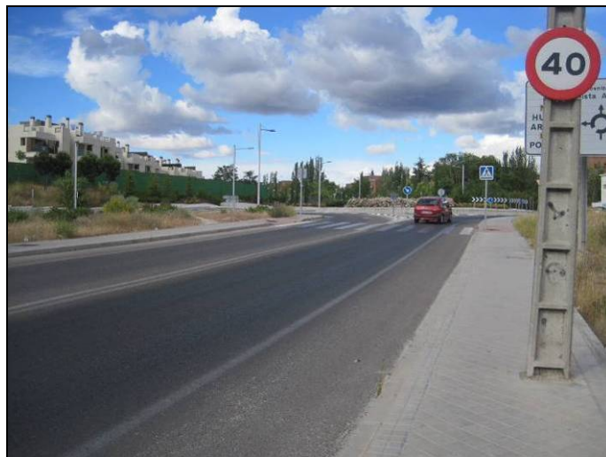
SALIDA DE LA ESTRUCTURA SENTIDO CASA DE CAMPO (2)
