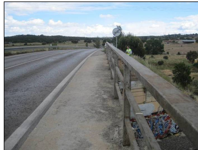
LATERAL DE LA ESTRUCTURA, SENTIDO GALAPAGAR (4)
