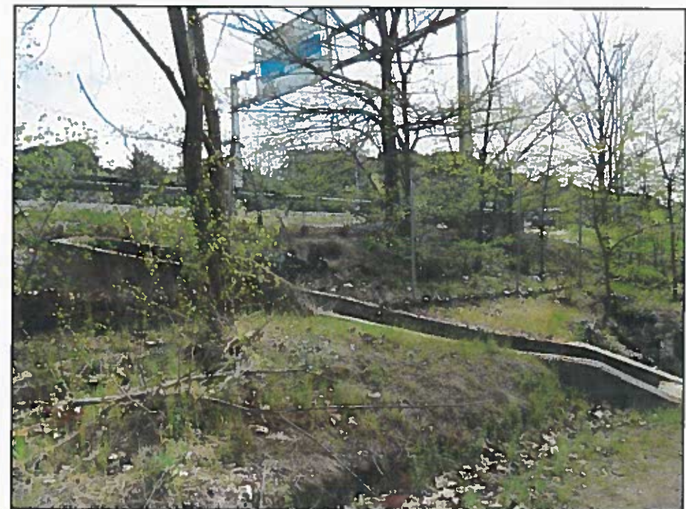
Foto nº 16. Canal de desagüe de la cuneta ubicado al final del desmonte de la calzada derecha.
