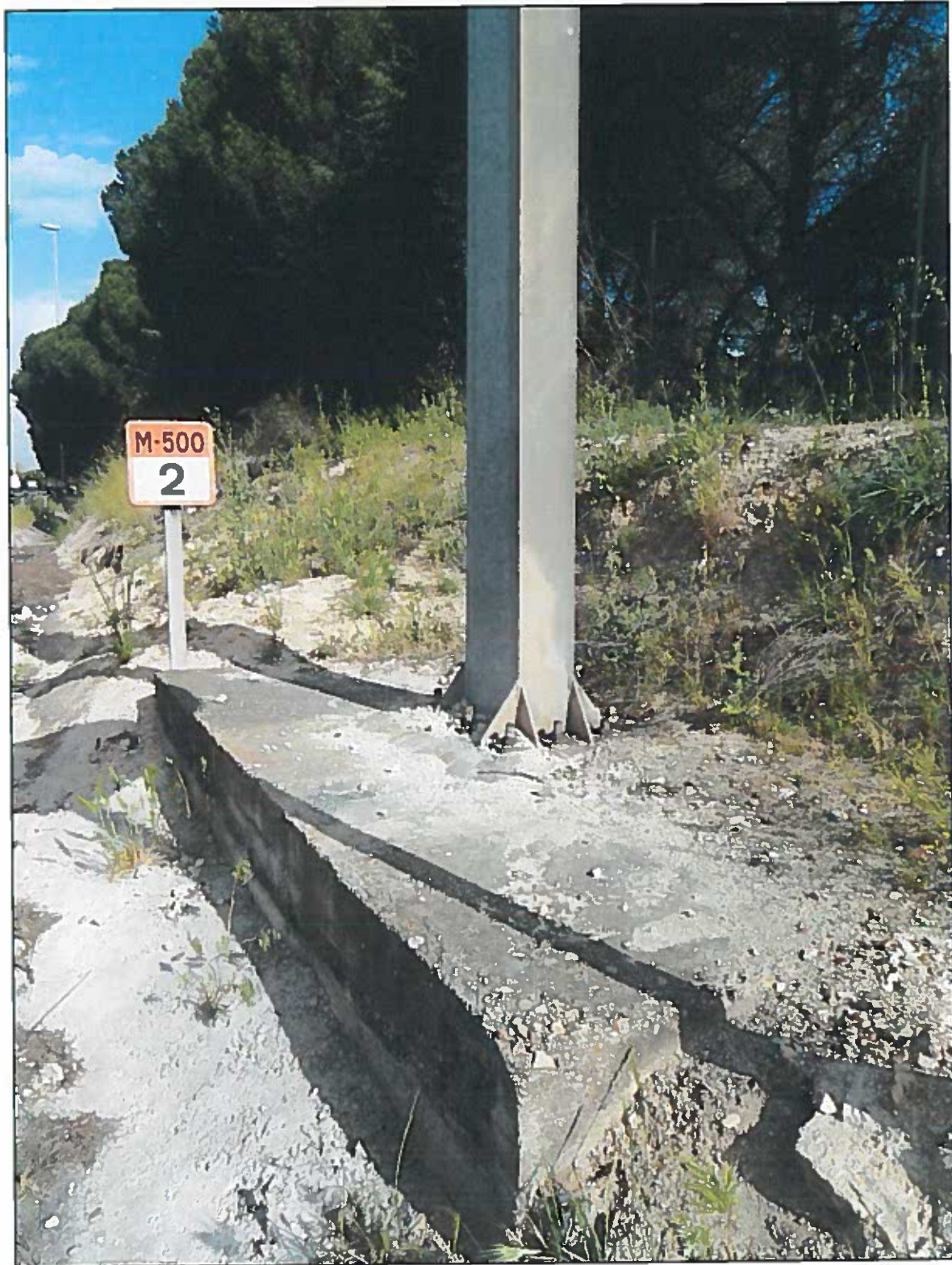
Foto nº 25. Detalle de la cimentación del pórtico existente en la calzada izquierda que será reubicado.
