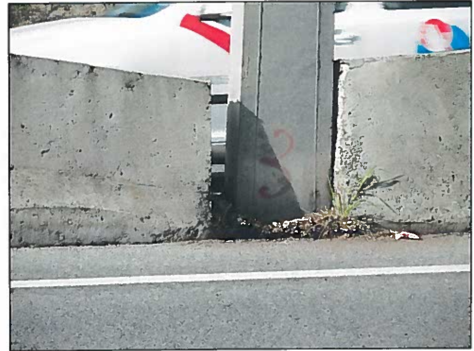
Foto nº 4. Detalle de la colocación del pórtico de señalización en la mediana de la carretera.
