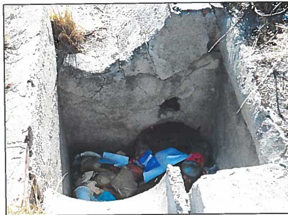
Foto nº 6. Estado actual de las arquetas en la calzada derecha con colector y tubo dren.
