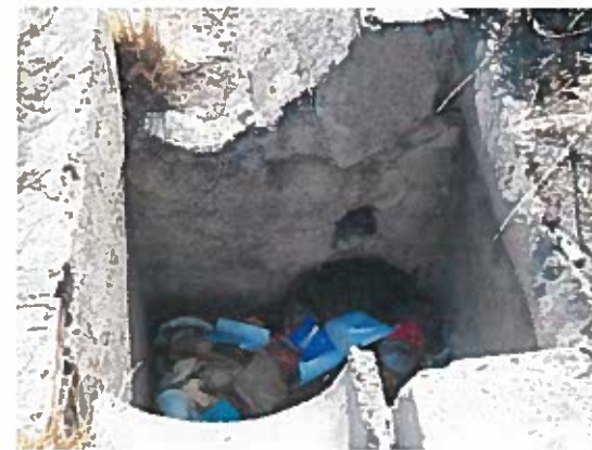
Arqueta en la que se aprecia el colector existente bajo la cuneta
