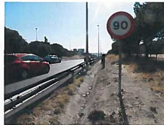
Cuneta revestida de hormigón existente en los márgenes de la M-500
