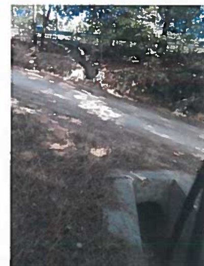
Elemento de desagüe en el que vierte la cuneta existente en la calzada derecha
