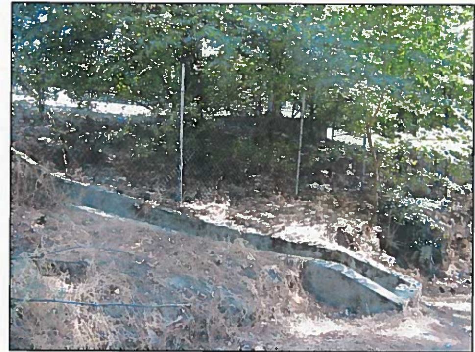
Foto nº 3. . Vista del canal de desagüe final de la cuneta de la calzada derecha.
