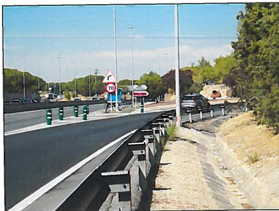
Foto nº 22. Vista de la barrera existente y la cuneta en la zona de ampliación de la calzada izquierda.
