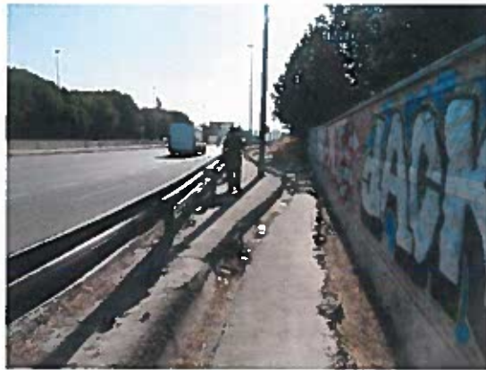
Cuneta revestida de hormigón existente en los márgenes de la M-500
