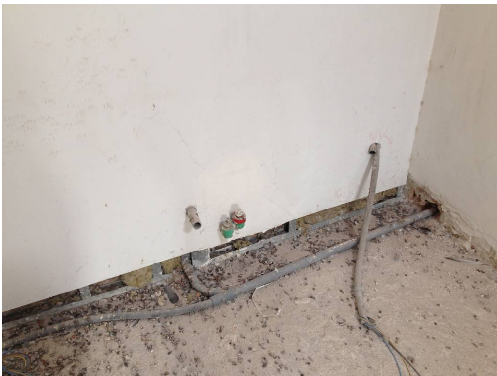
Tomas hidráulicas y eléctricas para fancoils en planta primera.
