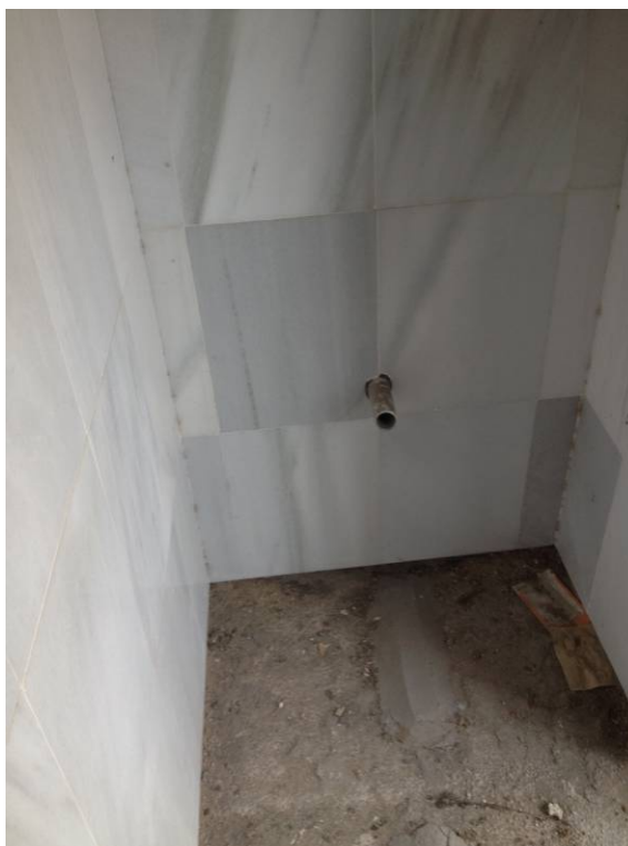
Desagüe previsto para aparato sanitario.
