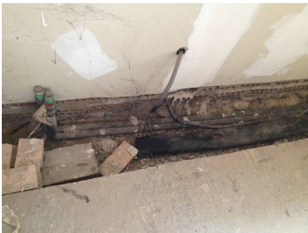
Tomas hidráulicas y eléctricas para fancoils en planta baja.
