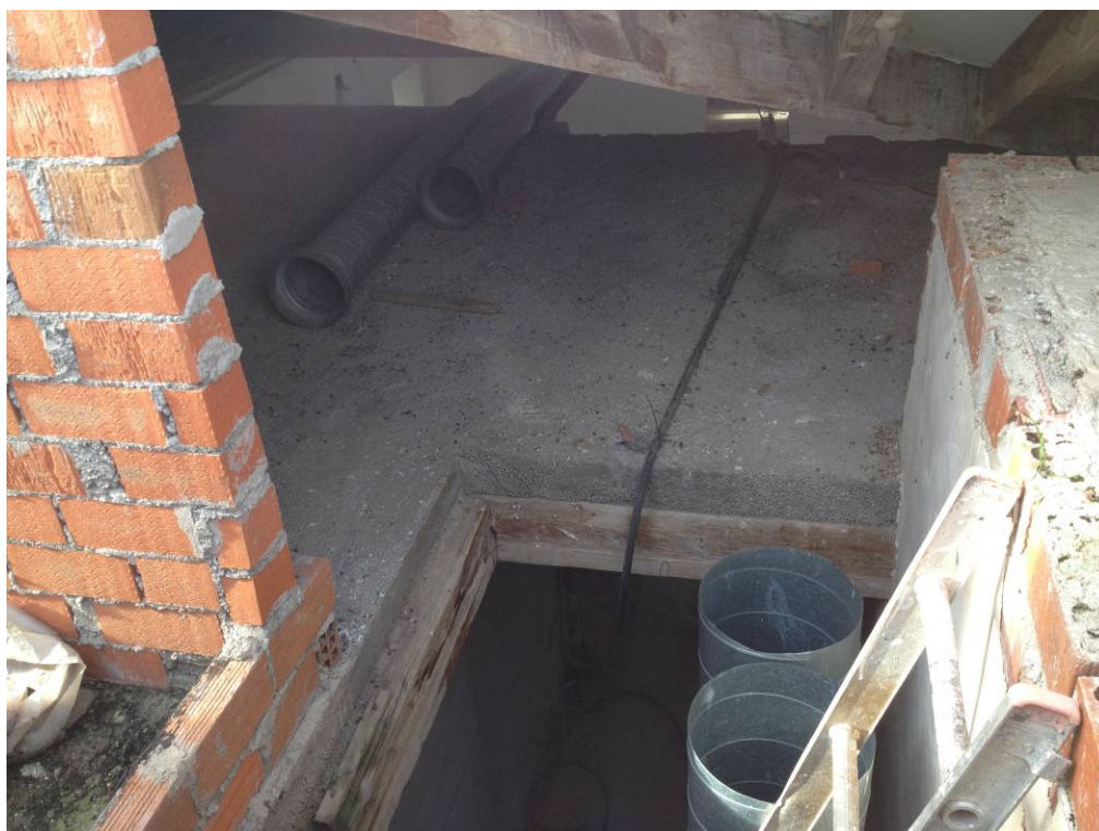
Conductos sin conexión en altillo de la planta primera.
