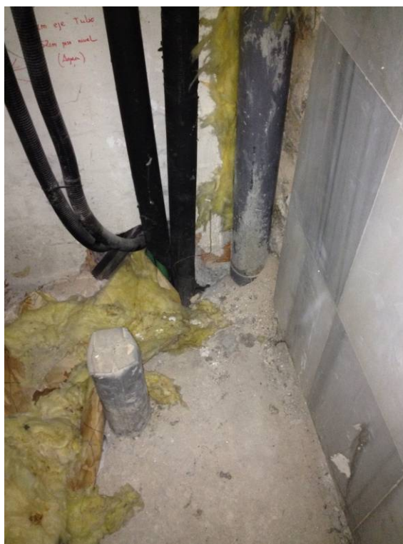
Bajante con aislamiento dañado.
