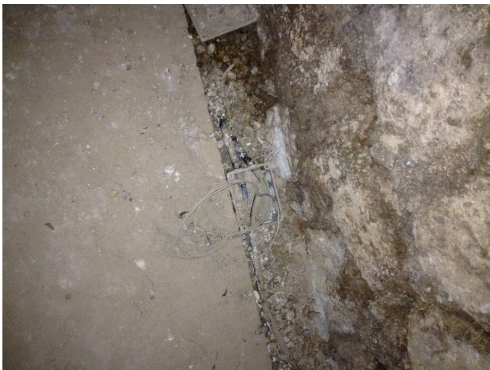
Cajas eléctricas inacabadas en sótano.
