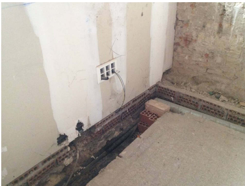
Cajas previstas sin cableado de voz y datos.
