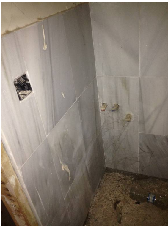
Caja para mecanismo sin cableado.
