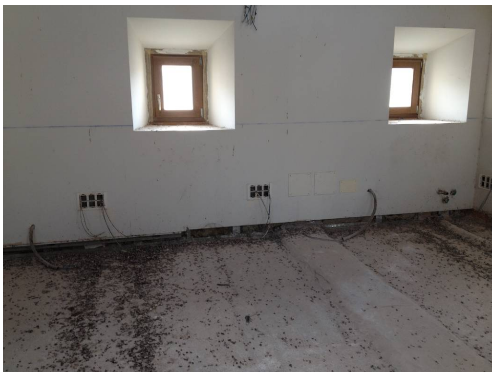
Tomas eléctricas inacabadas.
