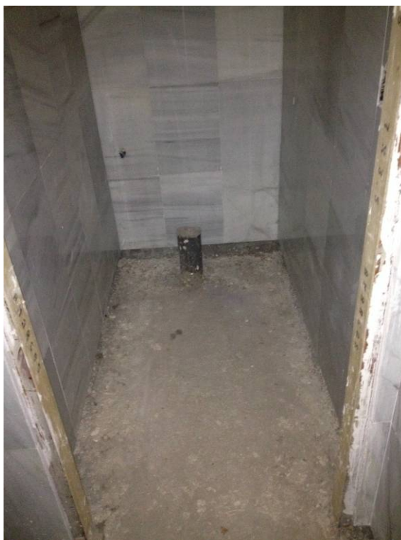
Toma de agua y desagüe previstos para aparato sanitario.
