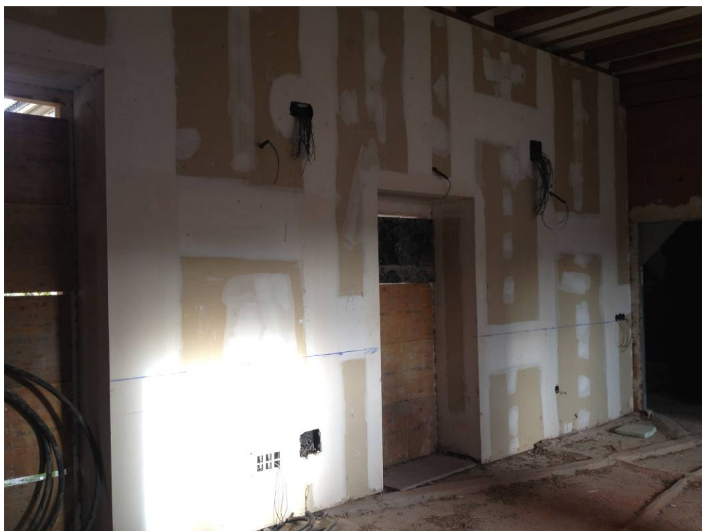
Cableado parcialmente instalado.
