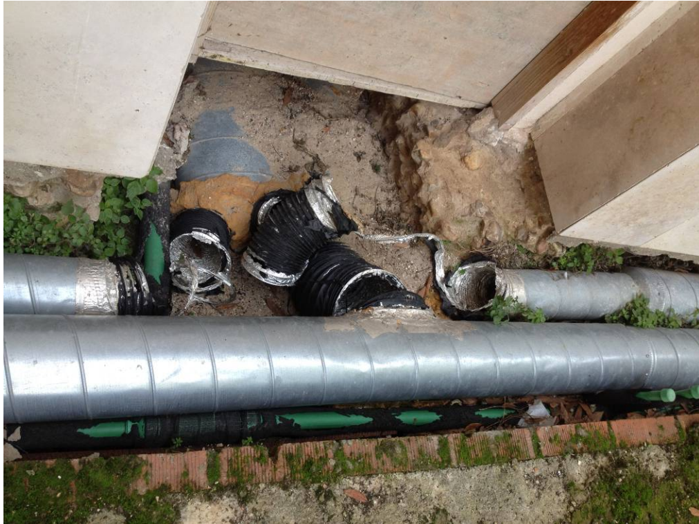
Conductos de ventilación dañados en planta baja.
