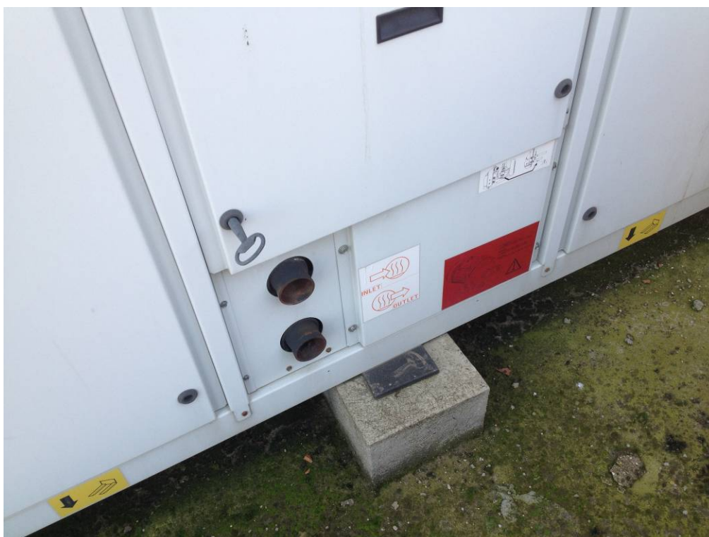
Máquina en cubierta sin conexión.
