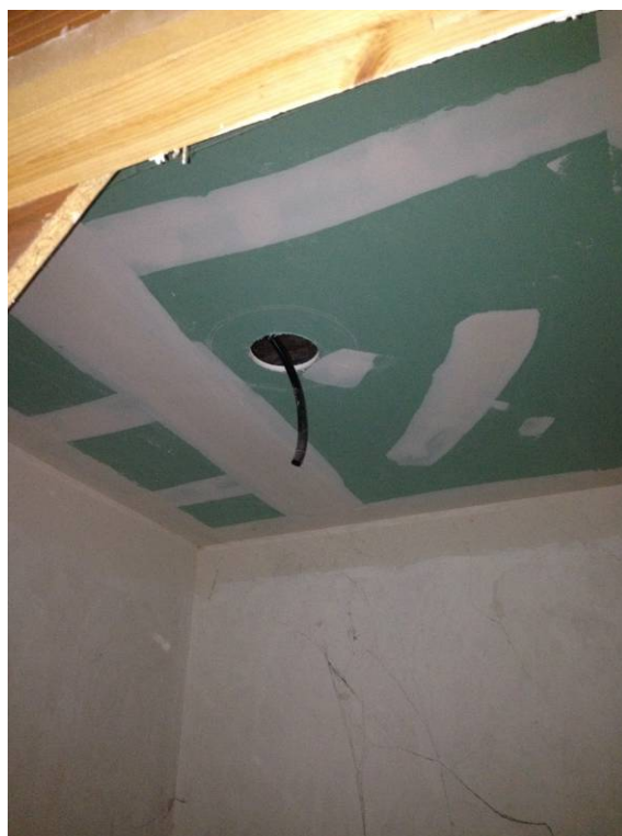
Punto de luz sin cableado.
