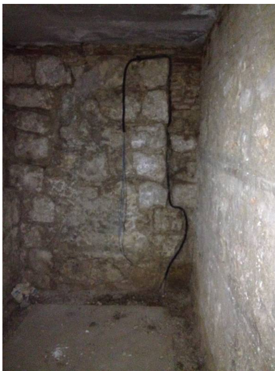
Tubos y cableado eléctrico inacabado en sótano.
