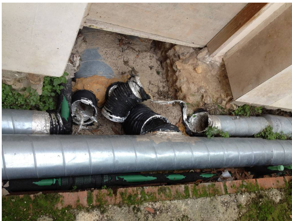
Tomas hidráulicas con aislamiento dañado.
