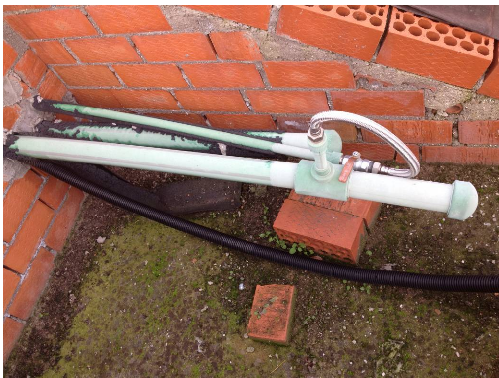
Tomas hidráulicas sin conexión a máquina de cubierta y con aislamiento dañado.
