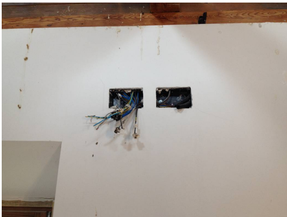
Cajas eléctricas con cableado parcialmente instalado.
