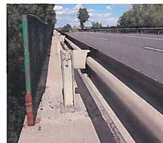
Fig.- 2: Sistema de contención existente en la estructura
