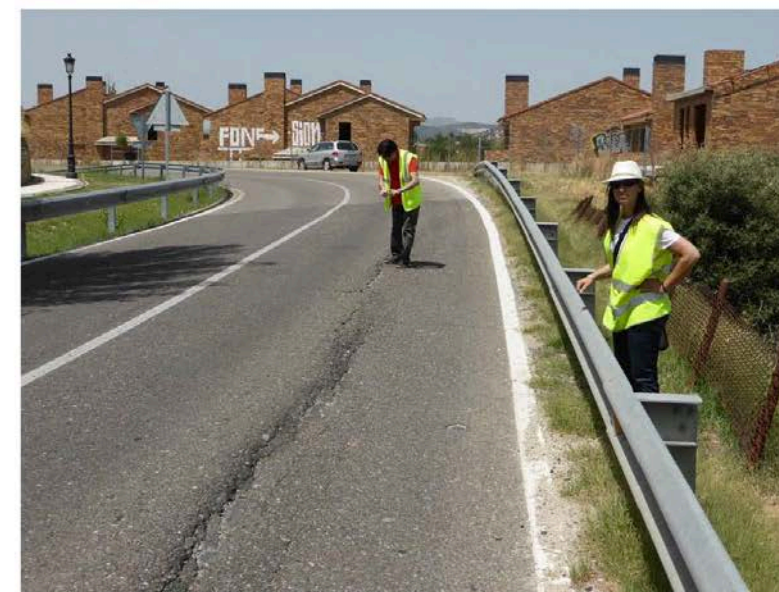
Foto 1.1 – Vista zona grieta con hundimiento
