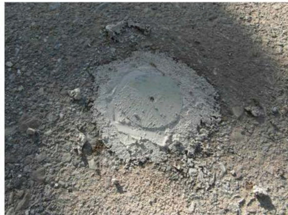
Sondeo S01 finalizado con tapa metálica y mortero de cemento.
