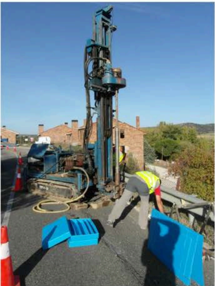
Maniobras de perforación del Sondeo S01.
