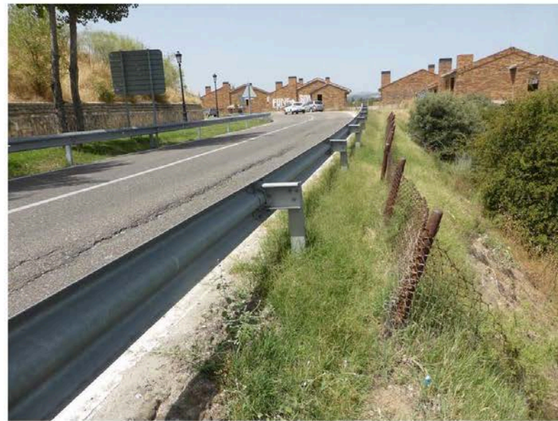
Foto 1.6 – Vista valla inclinada junto a bionda
