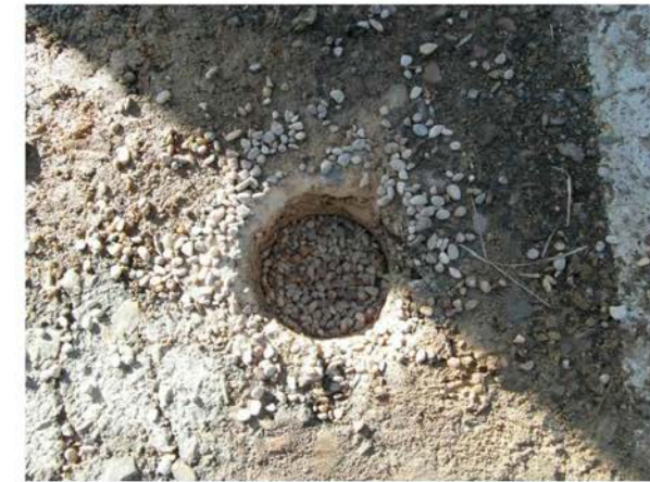
Sondeo S02 relleno con grava fina previo sellado.
