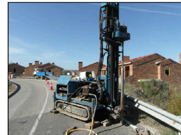
Fotografía 1: Máquina de sondeos TP50-D durante la ejecución del sondeo S-02
