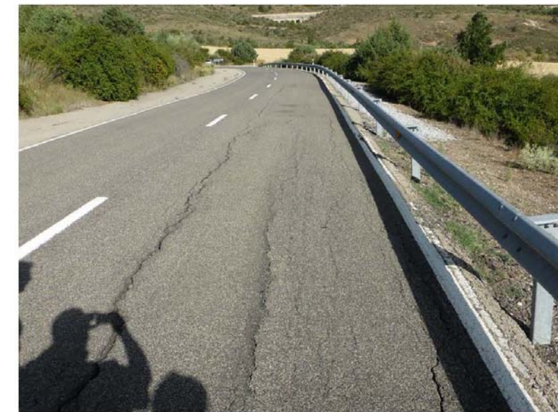
Foto 2.1 – Grietas longitudinales con hundimiento calzada
