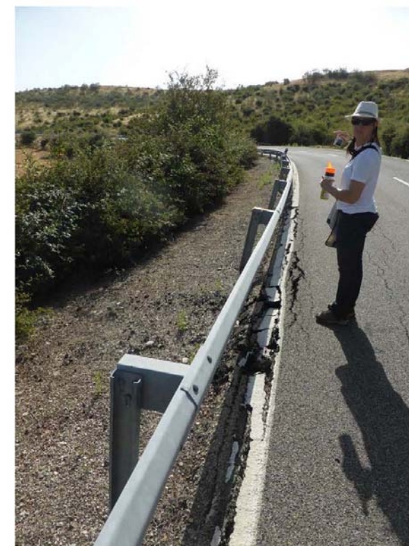
Foto 2.7 – Vista grieta en borde pavimento
