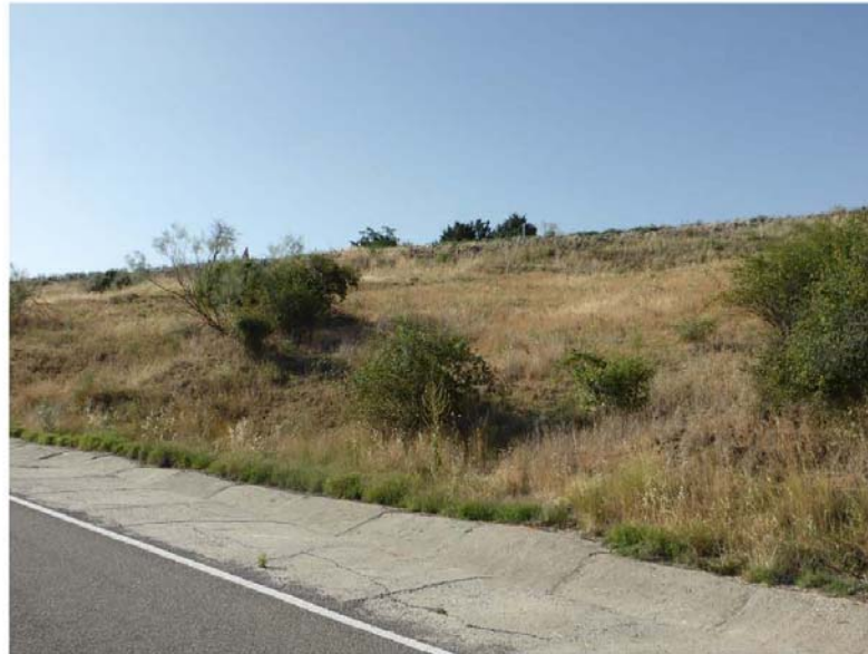
Foto 4.1 – Vista escarpe morfológico que debe coincidir con la cabeza de la zona inestable
