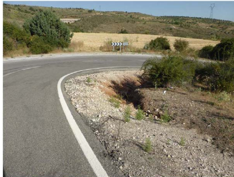
Foto 2.5 – Cuneta no revestida erosionada
