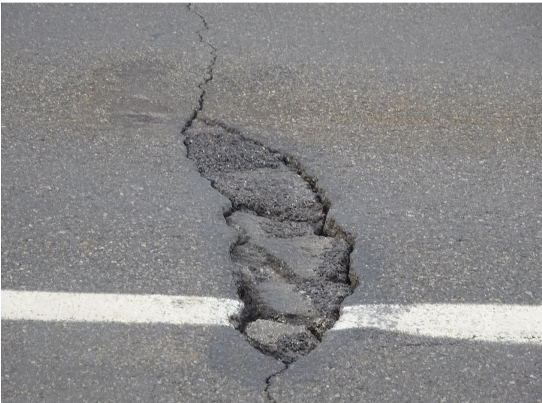
Fig. 8. Aspecto junta doble sobre pilas interiores. Detalle de deterioro en zona de rodadura y línea blanca.
