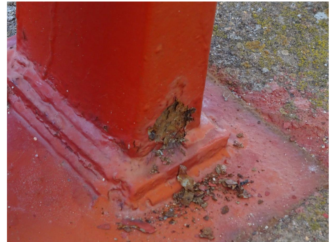
Fig. 2. Estado barandilla; corrosión.
