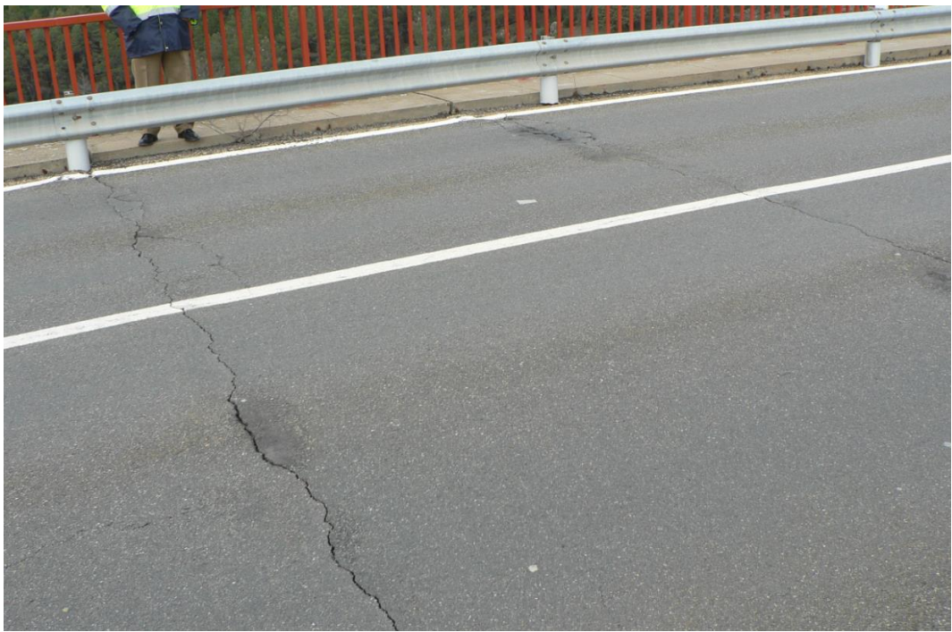
Fig. 7. Aspecto junta doble sobre pilas interiores
