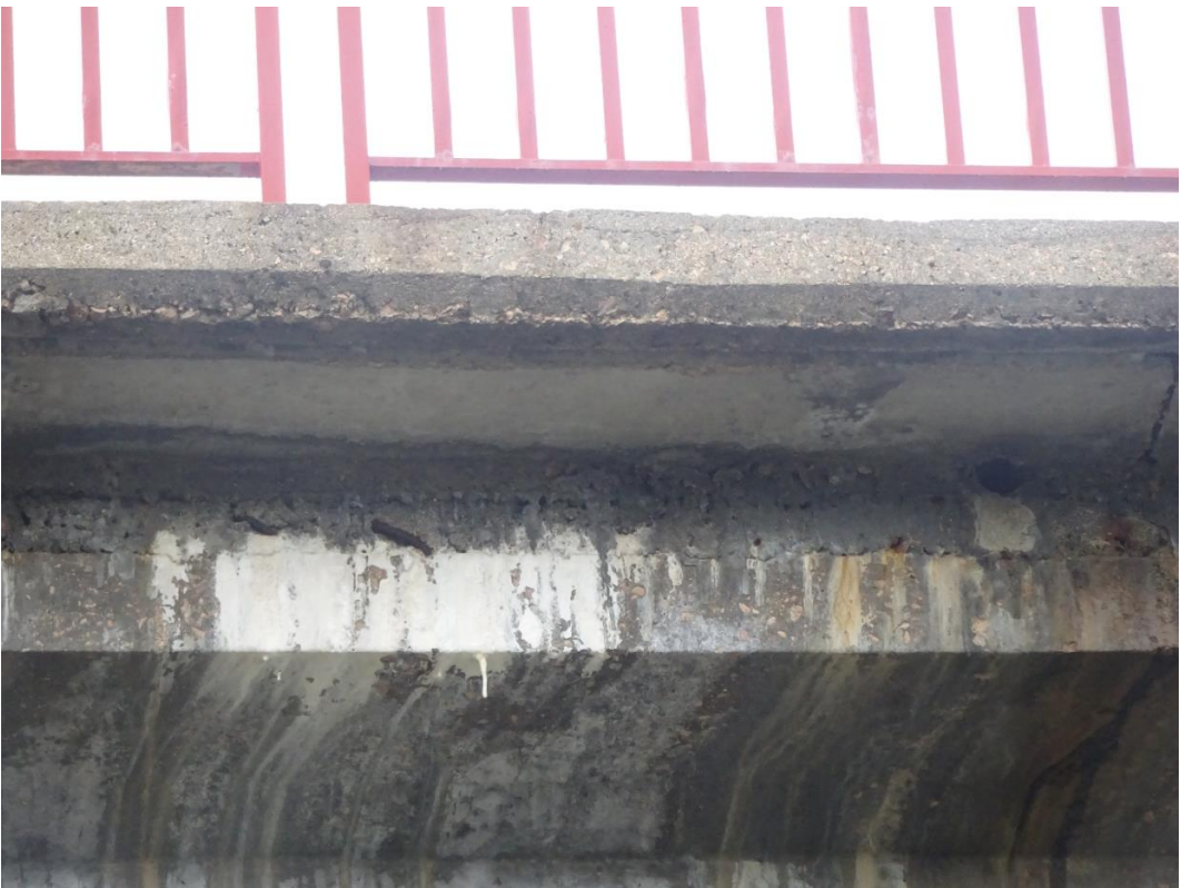
Fig. 10. Aspecto superficie lateral losa y cabeza de viga.
