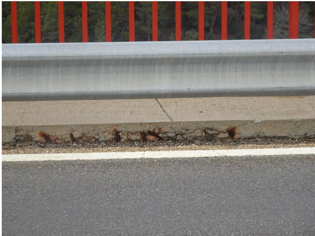
Fig. 5. Estado acera prefabricada; deterioro de la armadura
