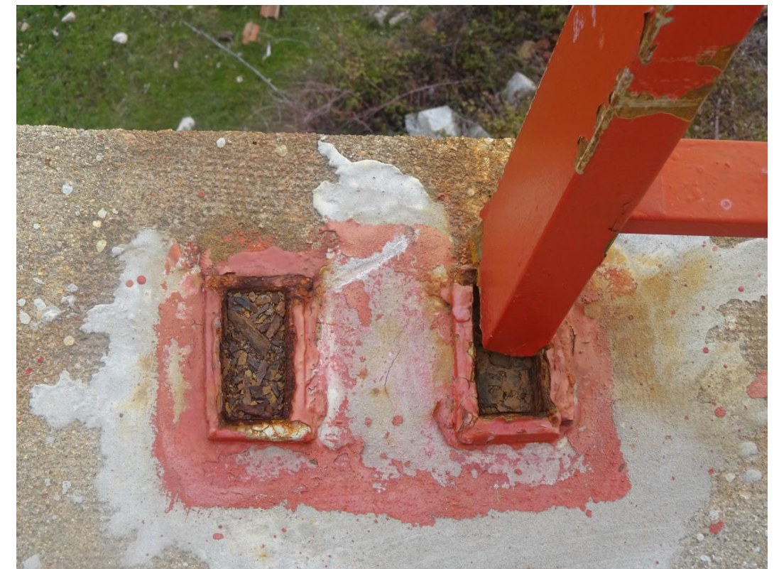
Fig. 3. Estado barandilla; corrosión.
