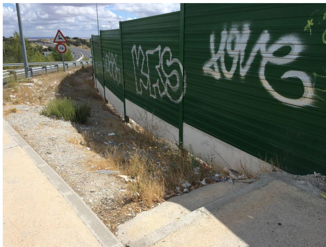
Imagen 1. Punto de inicio de la cuneta
