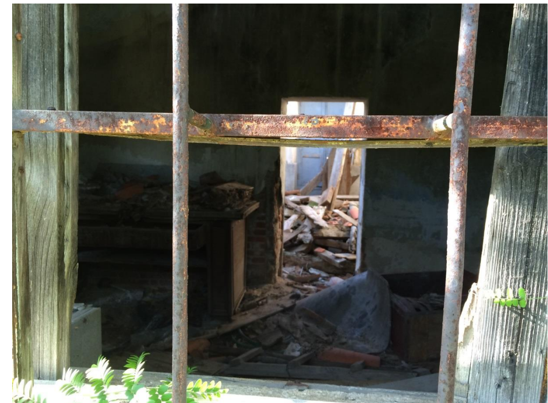
Interior del edificio abandonado
