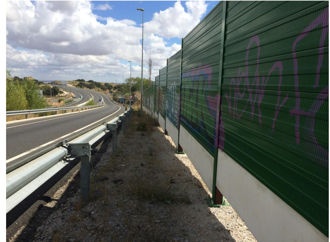
Zona de pantallas con huecos (PE-1)
