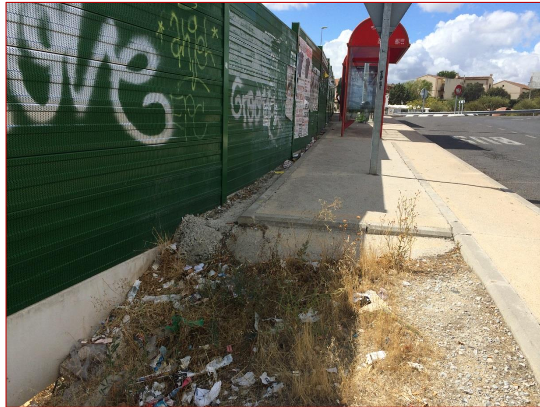
Inicio de la cuneta triangular
