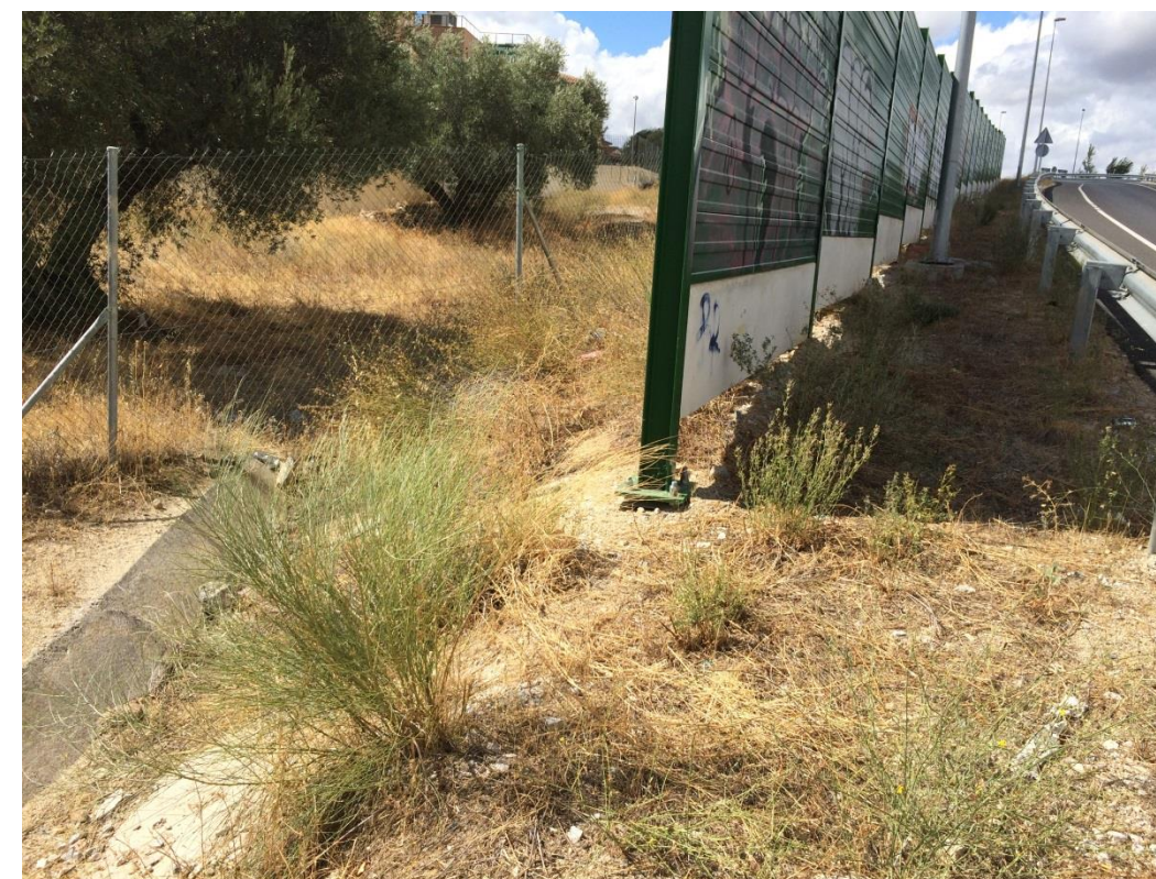
Imagen 3. Punto de conexión de la cuneta con la cuneta existente
