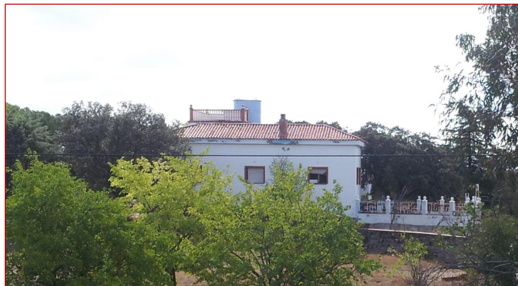
Edificación abandonada situada a la altura de las pantallas P4 y P5
