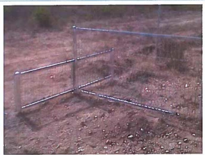
Figura 15. Ejemplo de portillo doble de escape con mampara de separación. Fte: <http://historiasdevallasycercados.wordpress.com>
