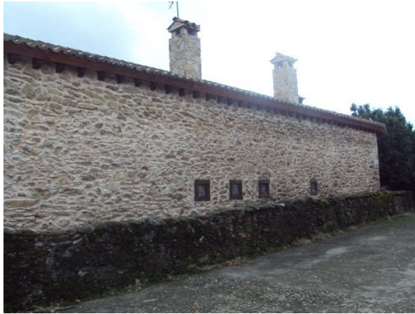
Izquierda: Muro de piedra local rehabilitado con técnicas tradicionales.
