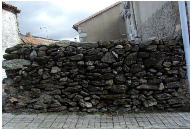
Cerca de piedra tradicional mampuesta en la calle Real, con junta seca, cerrando el perímetro del solar.
