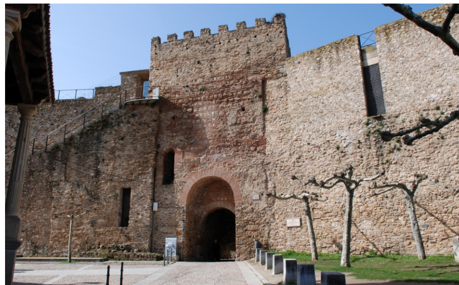
Vista de la torre del reloj y puerta de acceso. Buitrago del Lozoya.
