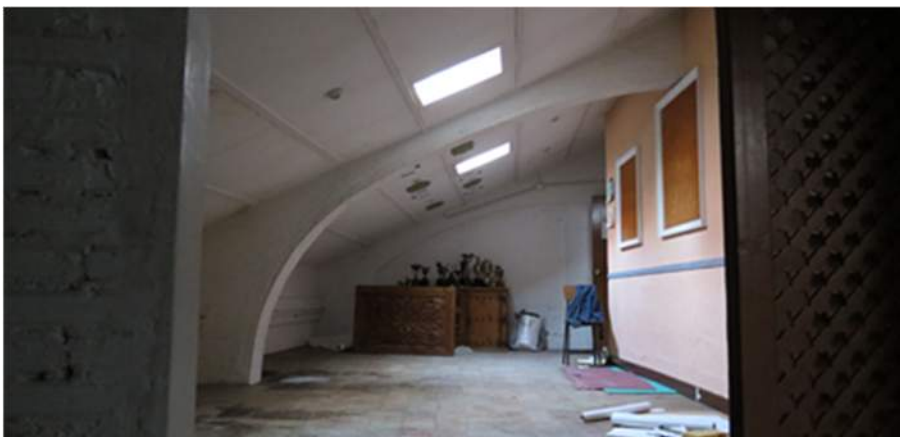
FOTOS 20 y 21: Planta bajo cubierta.
