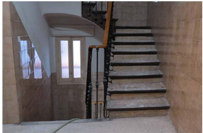
FOTOS 15 a 17: Caja de escalera en planta primera.
