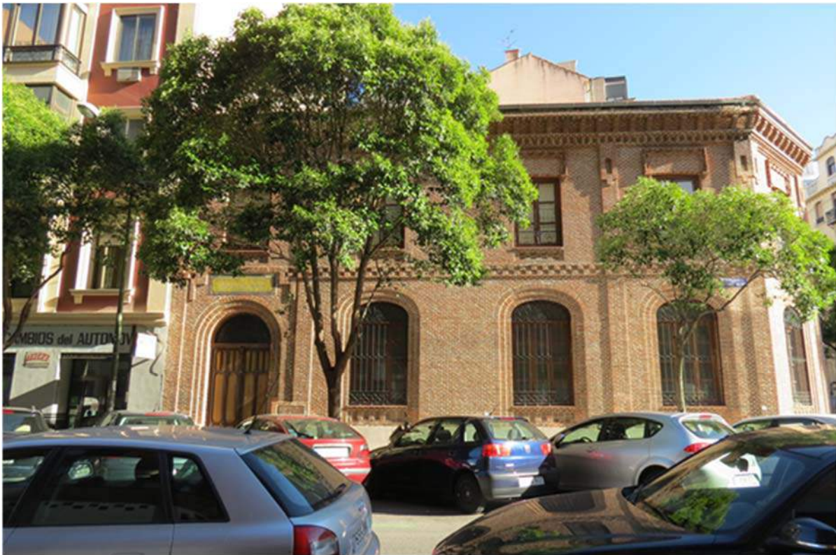
FOTO 1: Fachada principal del edificio de c/Meléndez Valdés, 35.
