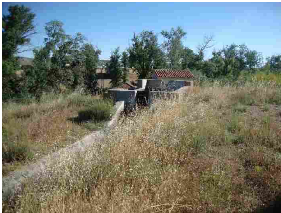
Cámara de descarga posterior al bombeo.
