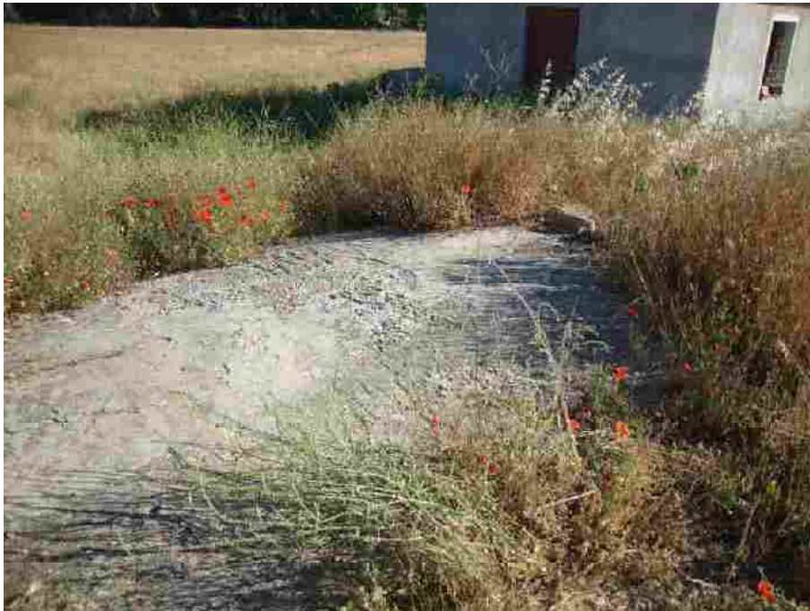
Losas de paso a parcelas antiguas.
