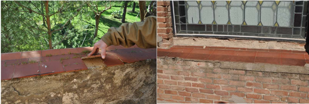
Baldosín catalán utilizado a modo de albardilla o de vierteaguas, sin goterón.
