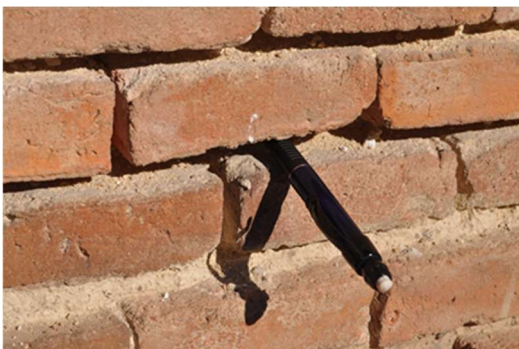
pérdida de rejuntado por meteorización del mortero
