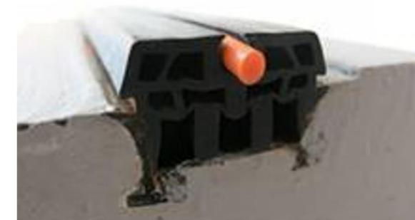
Figura nº 59. Detalle Cordón Hidrofílico Expansivo
