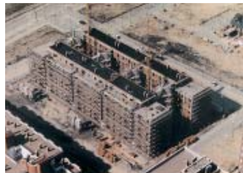
Vista del proceso constructivo
