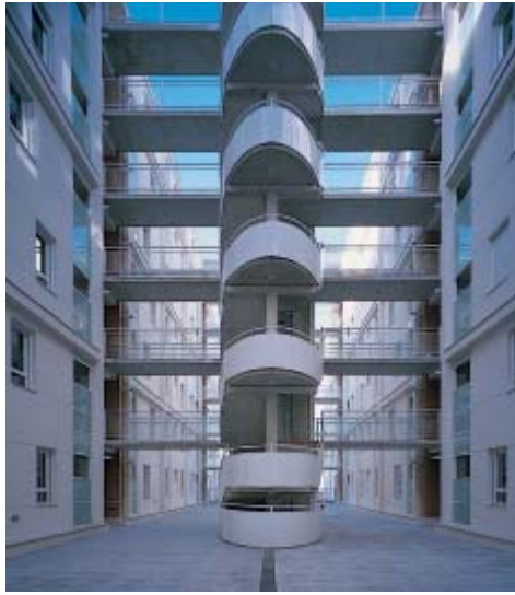
Vista del núcleo de comunicaciones
