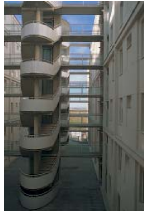
Vista de las pasarelas de acceso a las viviendas
