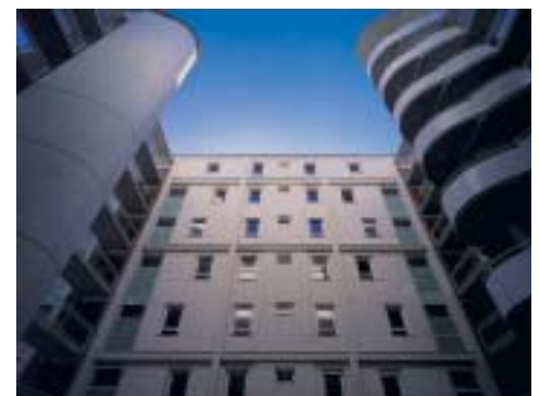
Vista interior del patio
