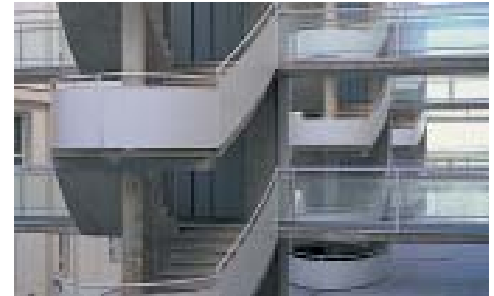
Vista de las escaleras de acceso a viviendas
