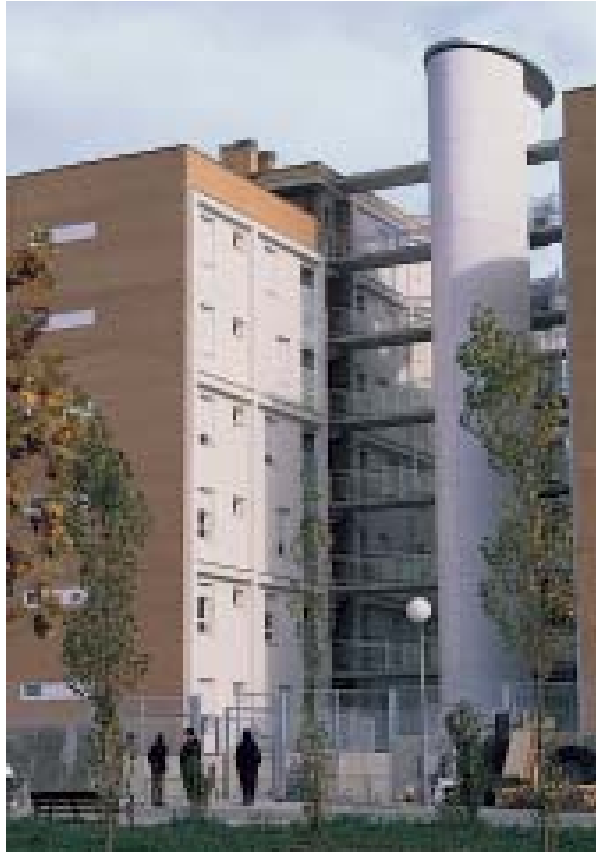
Vista exterior SO del núcleo de comunicaciones
