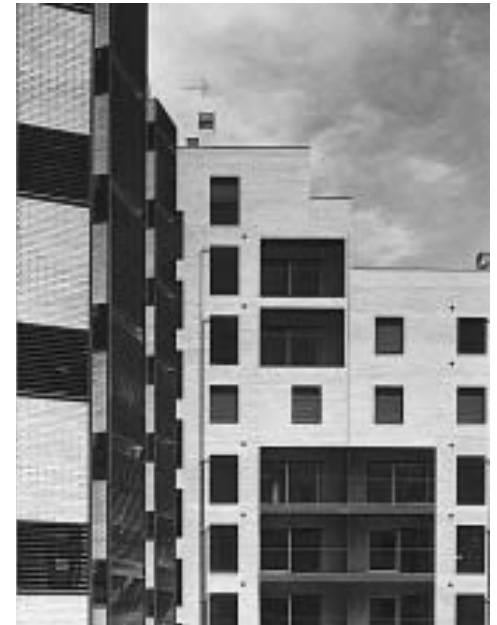
Vista del remate de esquina, desde el patio de manzana
