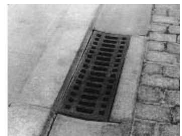
Detalle de la canaleta y rejilla
