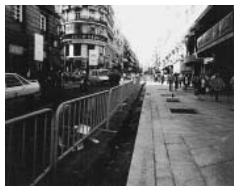
Vistas de los diferentes estados de las obras
