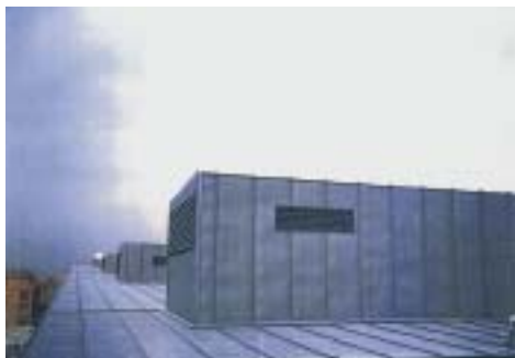
Tratamiento de los elementos de instalaciones en la cubierta
