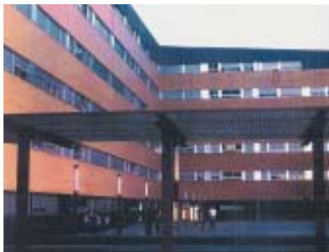
Vista E del patio interior
