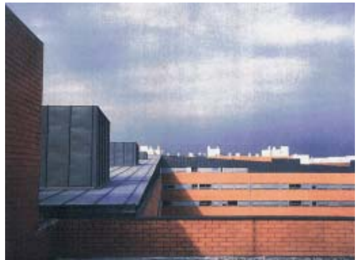
Vista de la cubierta
