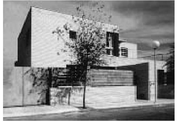
Vista de los accesos
