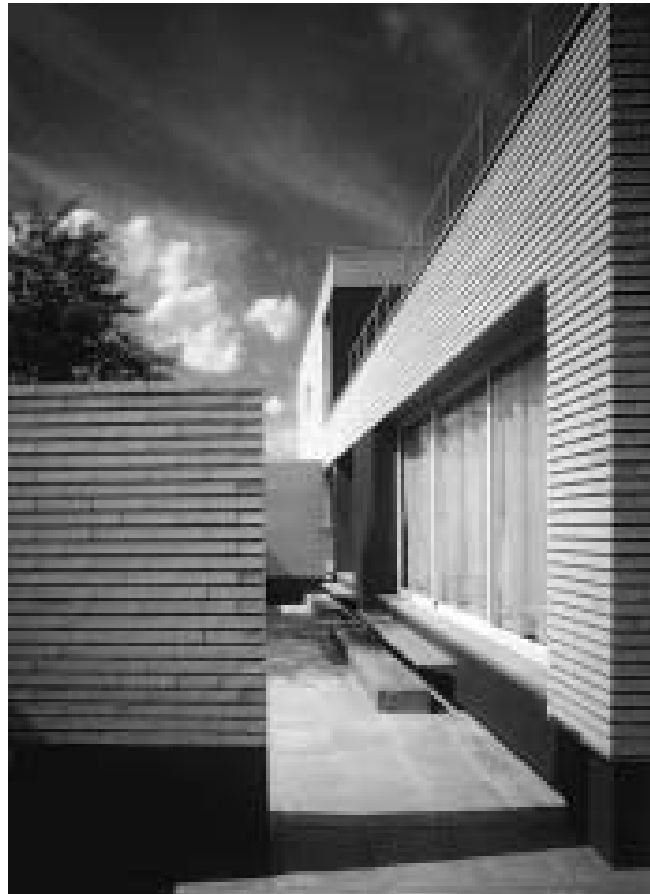
Vista desde el patio de vivienda
