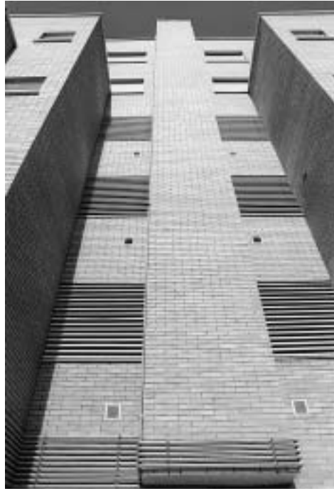
Vista del remate de fachada
