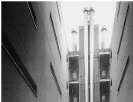
Vista del patio interior de viviendas
