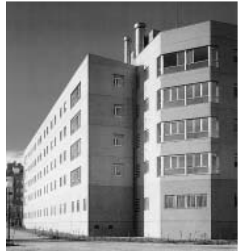
Vista exterior del encuentro entre bloques
