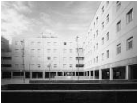
Vista general del patio de manzana
