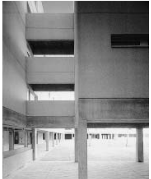
Vista desde patio interior del encuentro entre bloques
