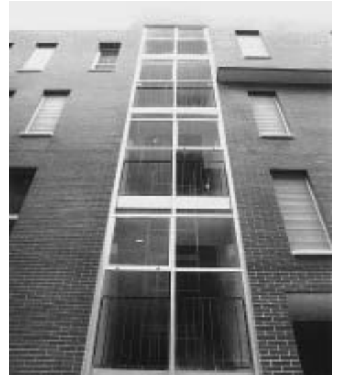
Vista exterior de los huecos de escalera
