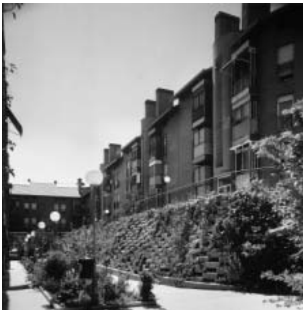
Vista general del patio de manzana
