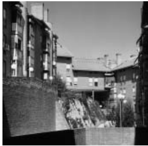
Vista interior desde uno de los accesos
