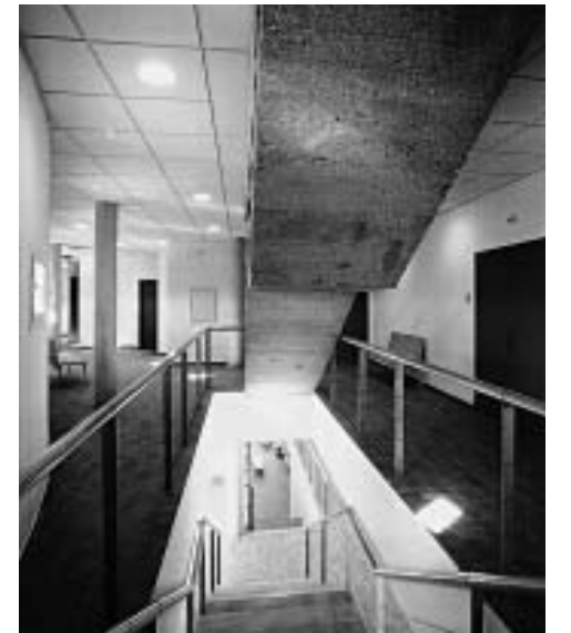
Vista del desarrollo de las escaleras
