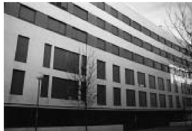
Vista de la fachada N
