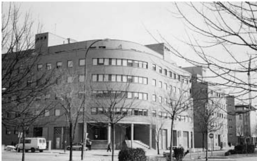
Vista de uno de los portales de esquina
