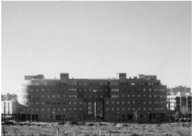
Vista general del edificio
