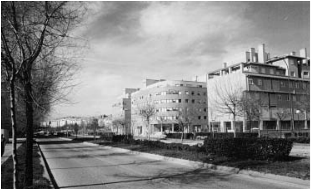
Vista general de acceso a uno de los portales
