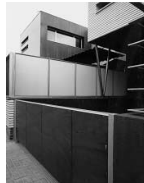
Vista exterior del acceso SO
