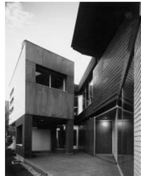
Vista acceso SE a la vivienda
